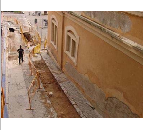
Excavacions c/ Bernat de Fonollar. Consorti del Patrimoni de Sitges
