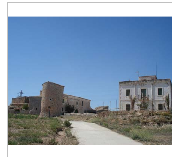
Vista de l'emplaçament. 23.5.2006. Diputació de Barcelona
