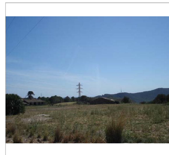
Vista de l'emplaçament. 23.5.2006. Diputació de Barcelona
