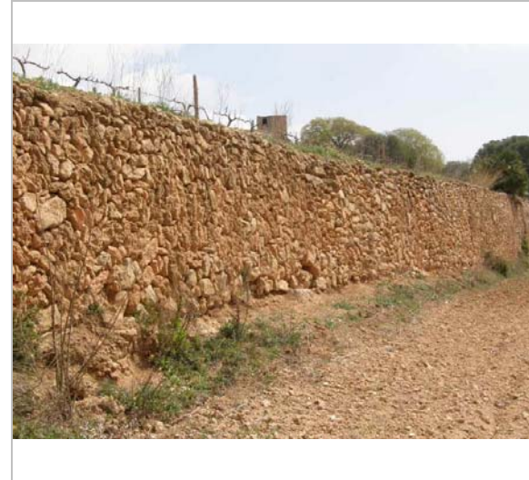
Un mur molt alt de pedra seca. 4.4.2015 Jaume Marsé
