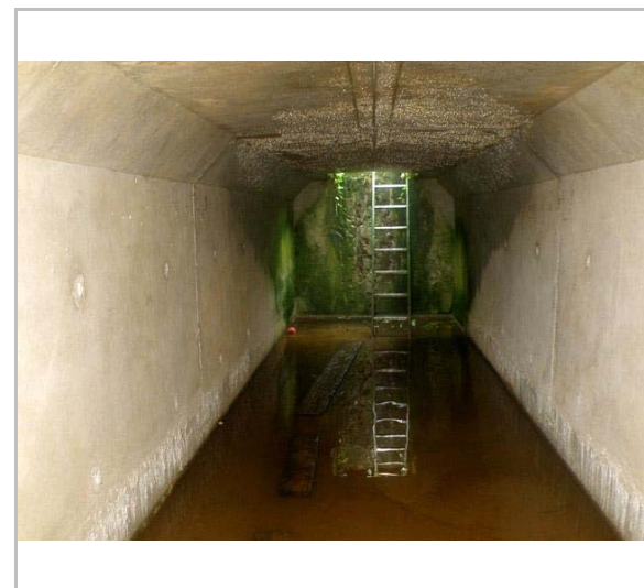
El túnel per sota l'autopista. 2013. espeleoindex
