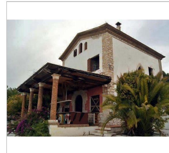
Vista façana i el porxo. 2014
