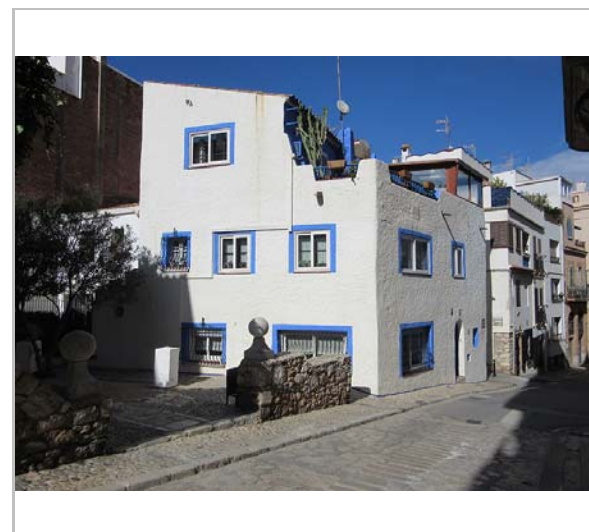
Vista de la casa. 3.3.2015 JM. Pujol
