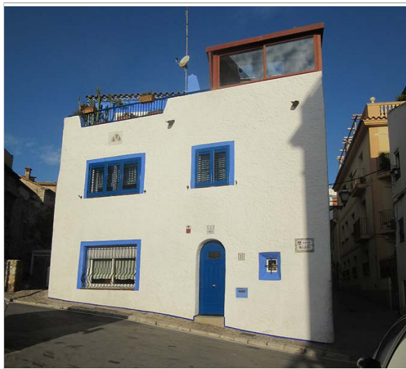
Vista de la casa. 21.10.2015 JM. Pujol
