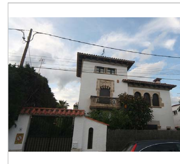
Vista de la Casa. 12.5.2016. JM. Pujol
