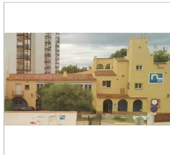
Façana Nord. 29.9.2016. JM. Pujol
