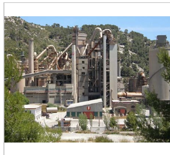
Vista de la fàbrica. 23.5.2014 Jaume Marsé
