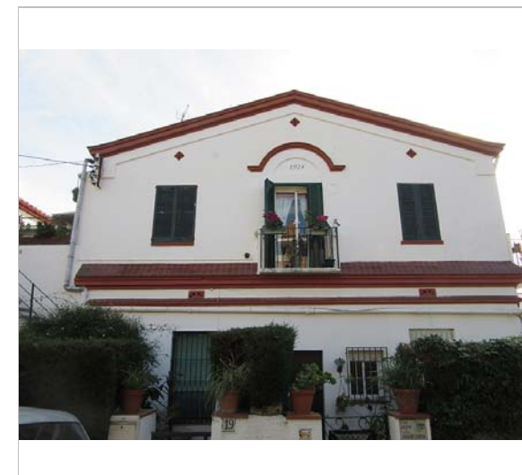
Vista de la casa. 2.1.2016 JM. Pujol
