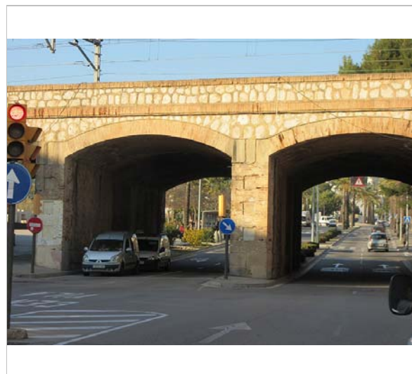
Vista el pont, banda sud. 14.1.2015 JM. Pujol
