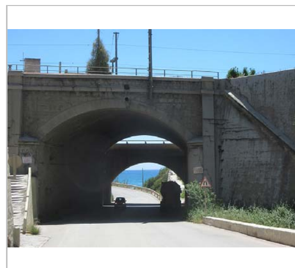
Viaducte de Vallcarca. 30.5.2016. JM. Pujol
