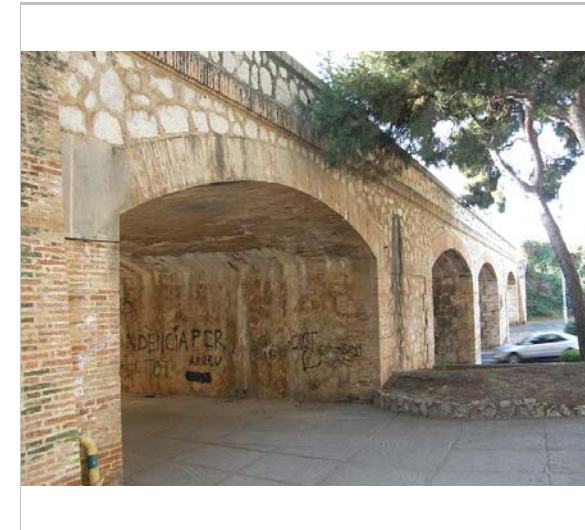
Vista el pont, banda nord. 13.1.2015
