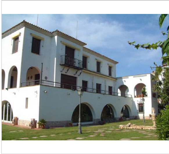
Vista de la casa. 2006. Diputació de Barcelona
