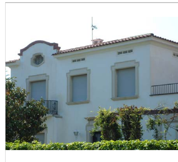
Vista de la casa. 3.5.2006. Diputació de Barcelona
