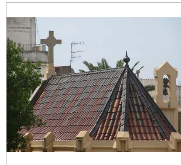
Coberta de la capella. 27.7.2015. JM. Pujol
