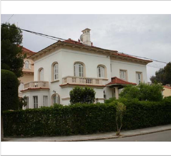
Façana principal. 2006. Diputació de Barcelona
