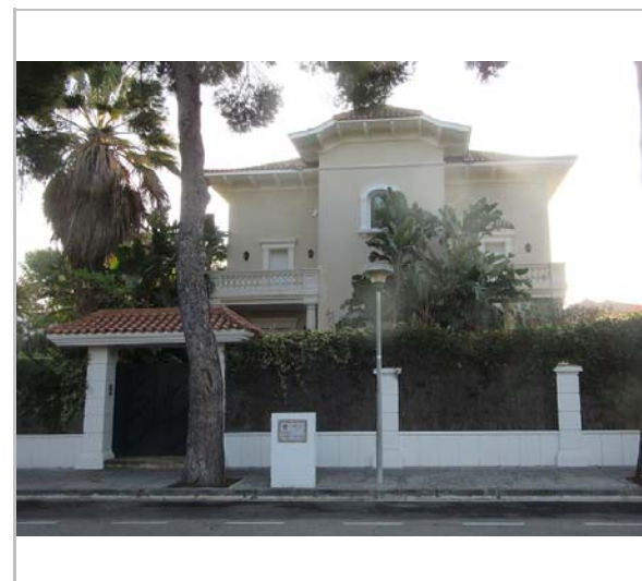
Vista de la casa. 9.12.2015. JM. Pujol
