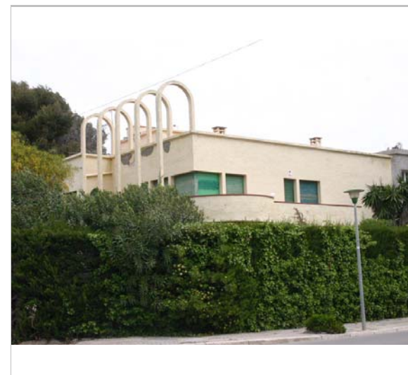
Vista de la casa. 2006. Diputació de Barcelona
