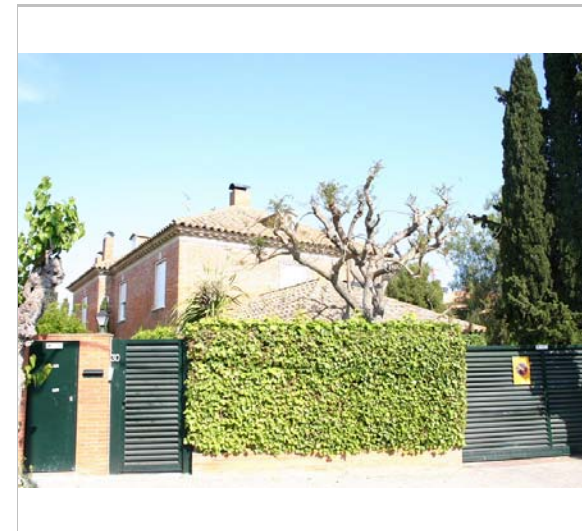
Vista de la casa. 2.5.2006. Diputació de Barcelona
