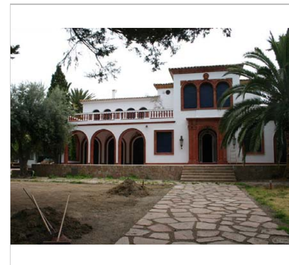
Vista de la casa. 2006. Diputació de Barcelona
