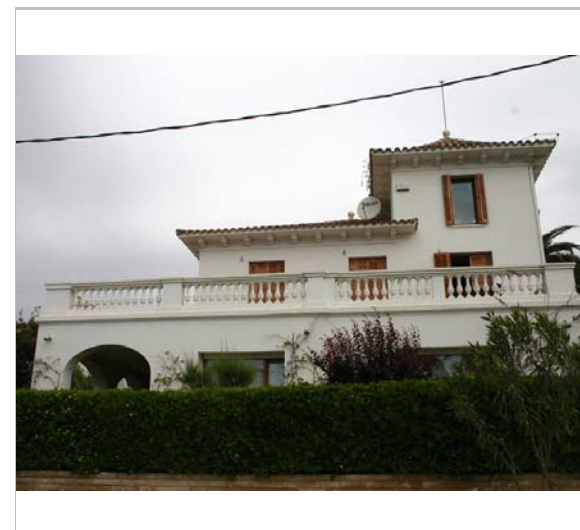
Vista de la casa. 3.5.2006. Diputació de Barcelona
