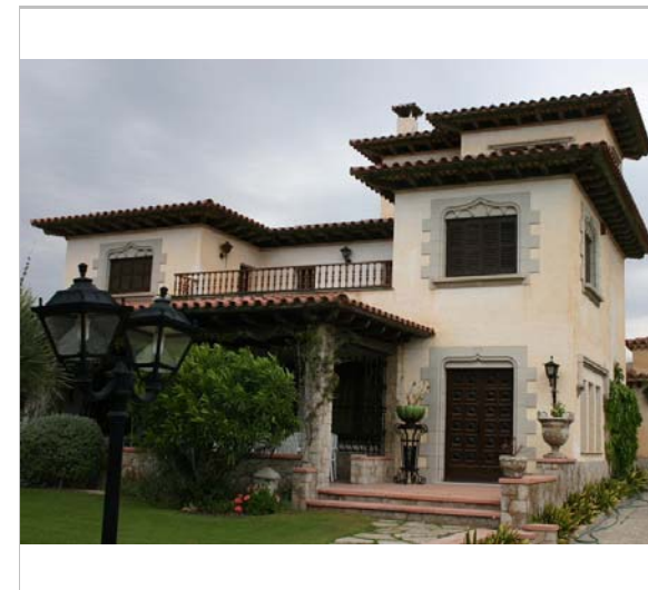
Vista de la casa. 2006. Diputació de Barcelona
