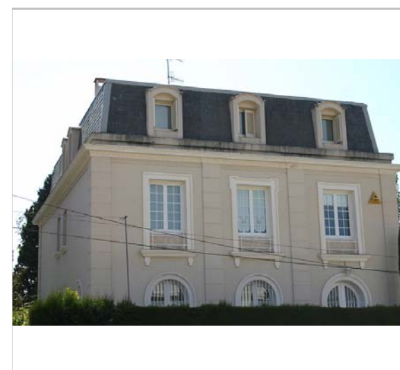
Vista de la casa. 2.5.2006. Diputació de Barcelona
