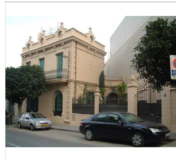
Vista de la casa. 2006. Diputació de Barcelona
