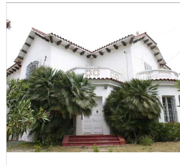
Vista de la casa. 3.5.2006. Diputació de Barcelona
