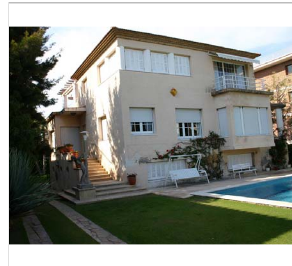
Vista de la casa. 2006. Diputació de Barcelona
