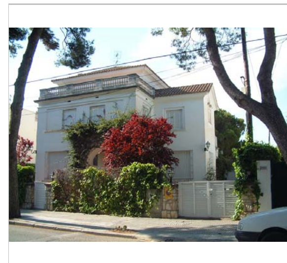
Vista de la casa. 2006. Diputació de Barcelona
