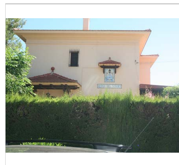
Façana lateral. 23.6.2016. Sixto Pujol
