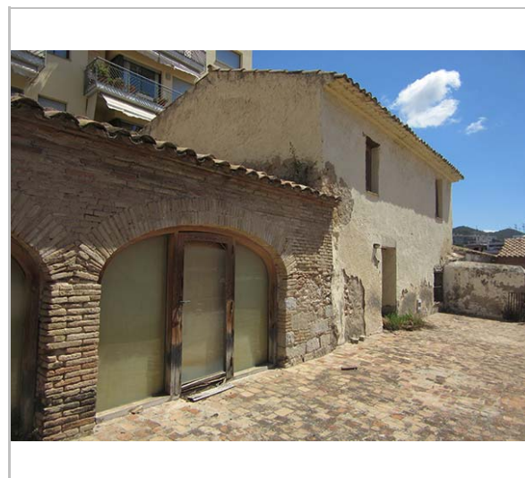
Façana de migdia. 2016 JM. Pujol
