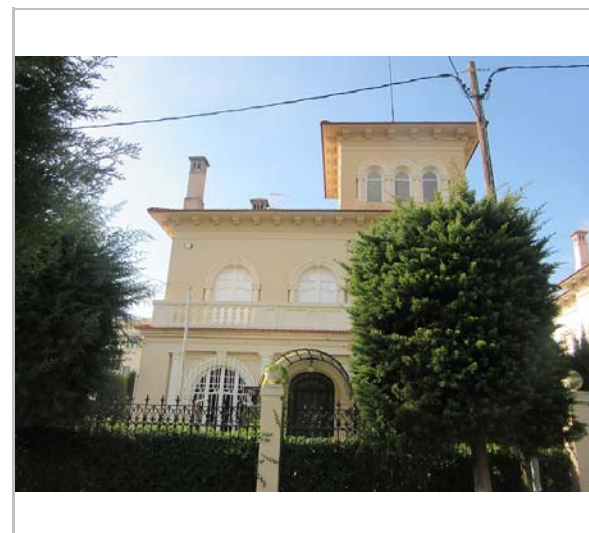
Vista de la casa. 11.12.2015. JM. Pujol
