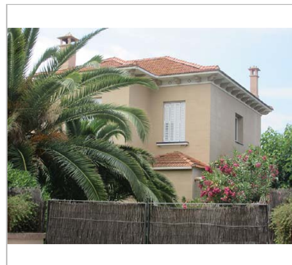
Vista de la casa. 3.7.2016. JM. Pujol
