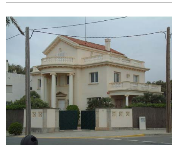
Vista de la casa. 2006. Diputació de Barcelona
