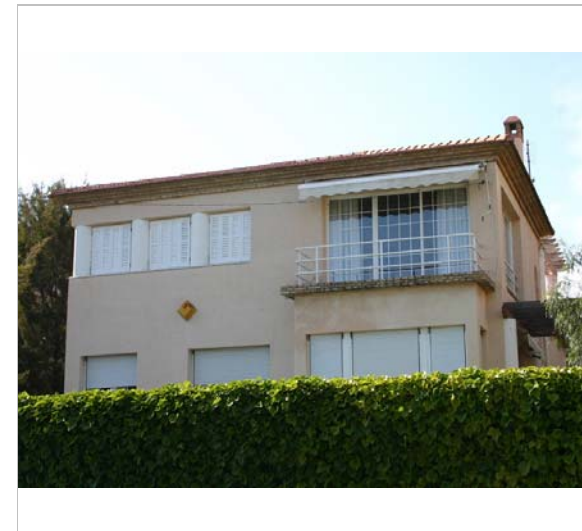
Vista de la casa. 2006. Diputació de Barcelona
