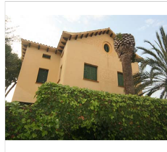
Vista de la casa. 5.12.2015. JM. Pujol
