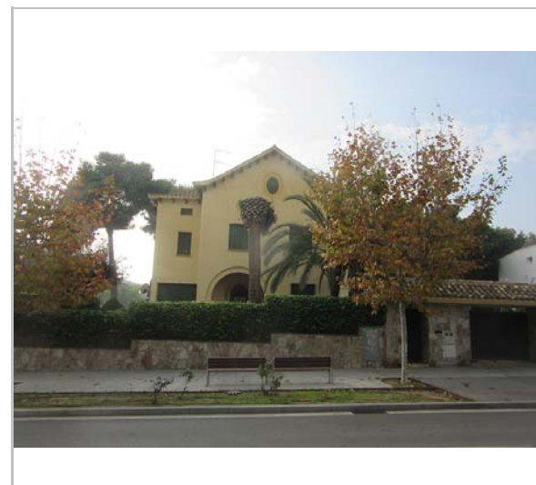
Vista de la casa. 5.12.2015. JM. Pujol
