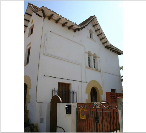
Vista de la casa. 2.5.2006. Diputació de Barcelona
