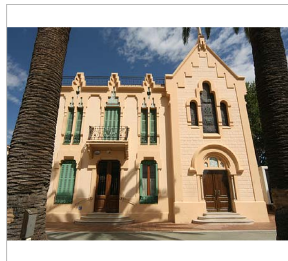
Vista de la casa. 13.8.2014. JM. Pujol
