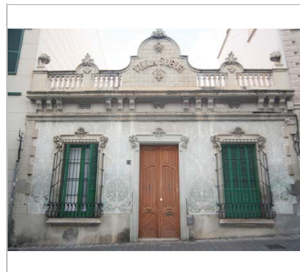
Façana. 9.12.2015. JM. Pujol
