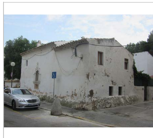
Vista de la casa. 5.12.2015. JM. Pujol
