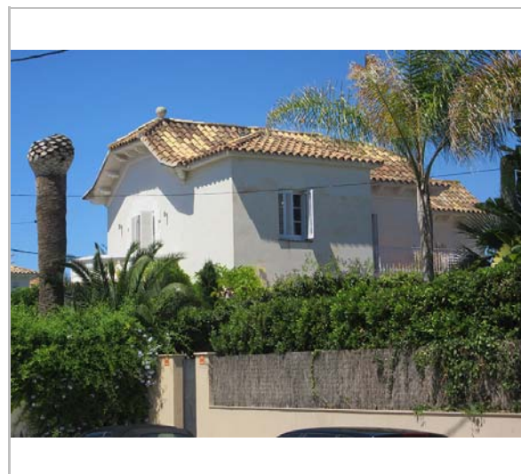
Vista de la casa. 22.6.2016. Sixto Pujol
