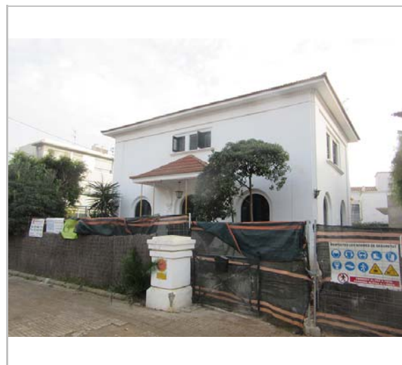
Vista de la casa. 5.12.2015. JM. Pujol
