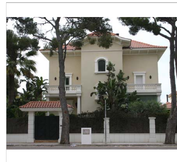
Vista de la casa. 2006. Diputació de Barcelona
