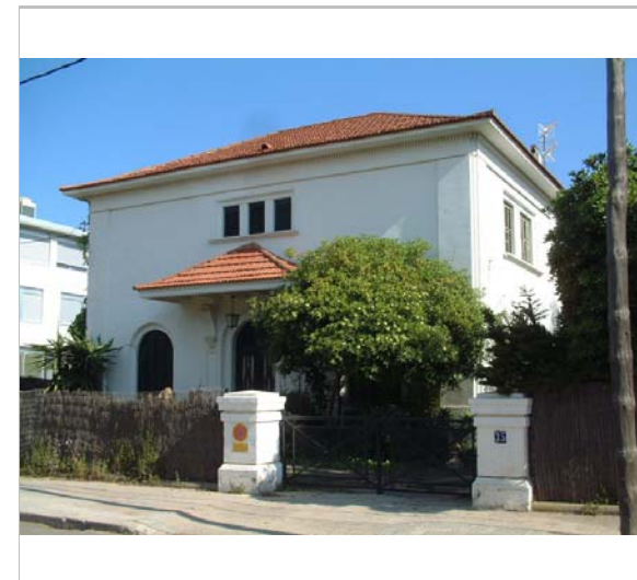
Vista de la casa. 2006. Diputació de Barcelona
