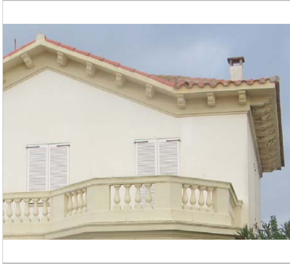
Detall de la façana. 9.12.2015. JM. Pujol
