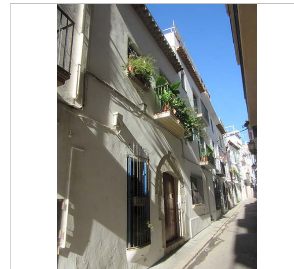
Façana. 17.11.2015. JM. Pujol
