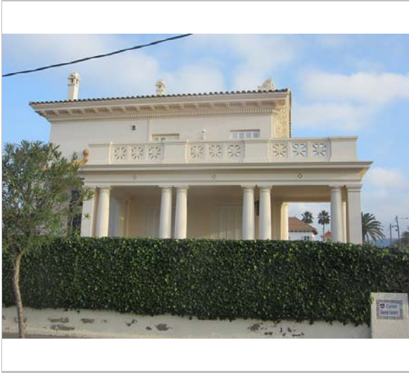
Vista de la façana lateral. 9.12.2015. JM. Pujol
