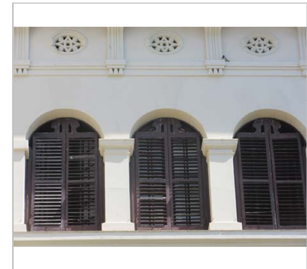
Detall de la façana. 27.6.2016 Sixto Pujol
