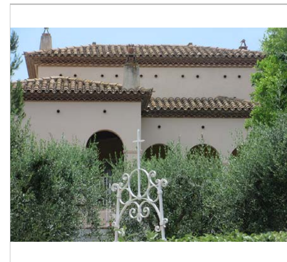
Façana posterior de la casa. 3.7.2016. JM. Pujol
