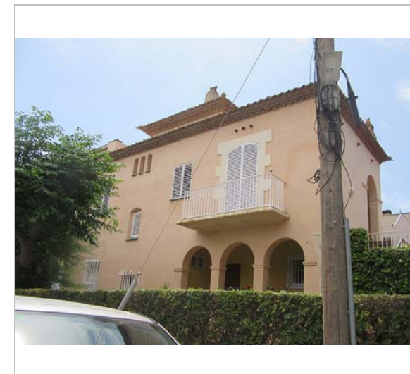
Vista de la façana lateral. 3.7.2016. JM. Pujol
