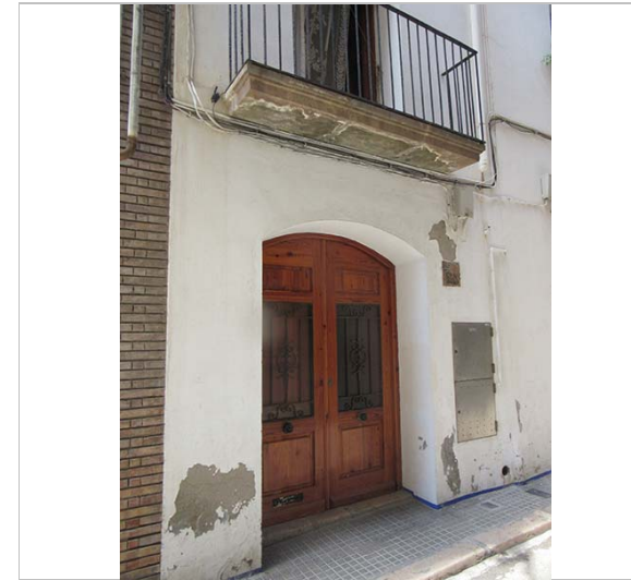
Detall de la façana. 9.6.2016. JM. Pujol
