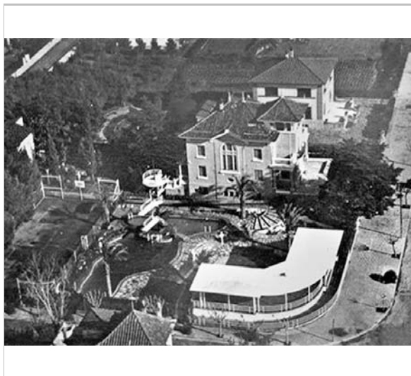
Foto històrica. Vista aèria.
