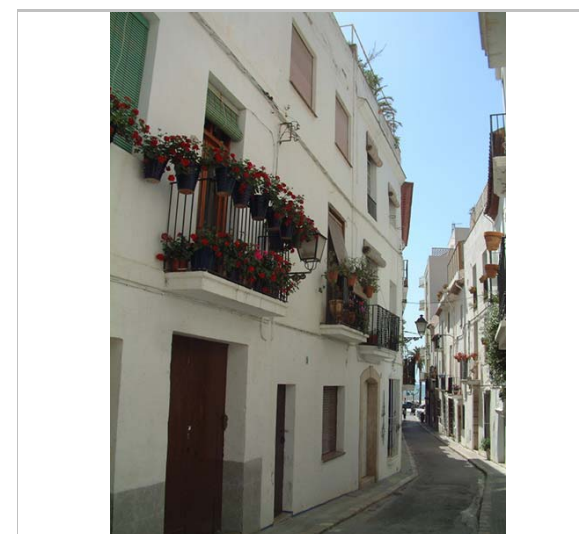
Detall de la façana. 26.4.2006 Diputació de Barcelona
