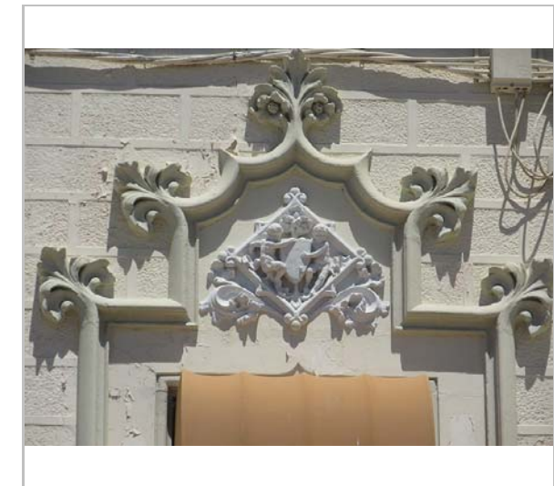
Detall de la façana. 23.6.2016. Sixto Pujol
