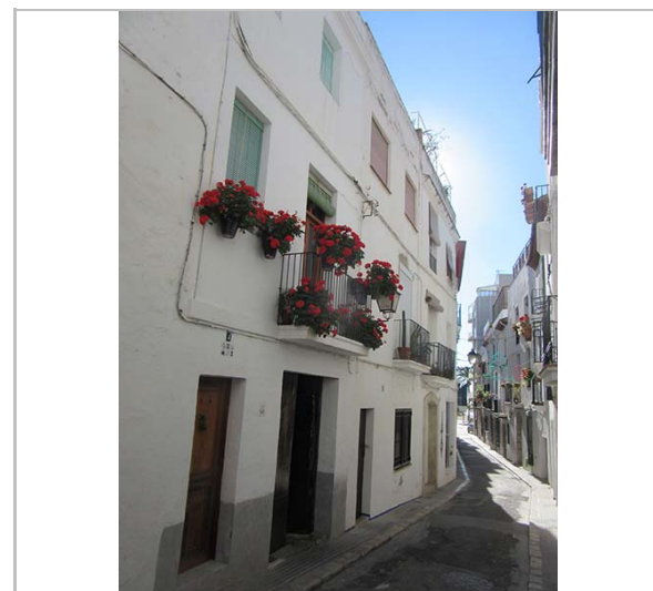
Façana. 17.11.2015. JM. Pujol
