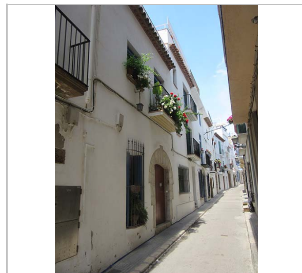
Façana. 9.6.2016 JM. Pujol
