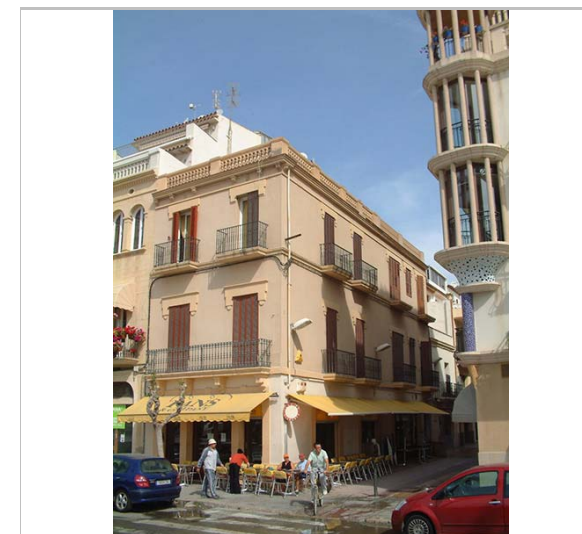
Vista de l'edifici. 3.5.2005. Diputació de Barcelona
