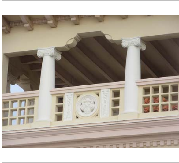
Detall de la galeria porxada. 9.12.2015. JM. Pujol
