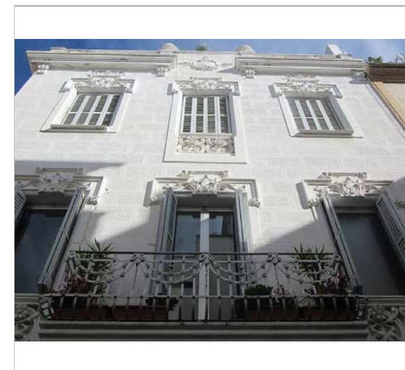
Detall de la façana. 18.1.2016. JM. Pujol
