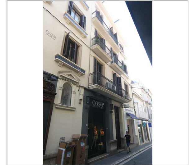
Façana del núm. 3. 3.6.2016. JM. Pujol
