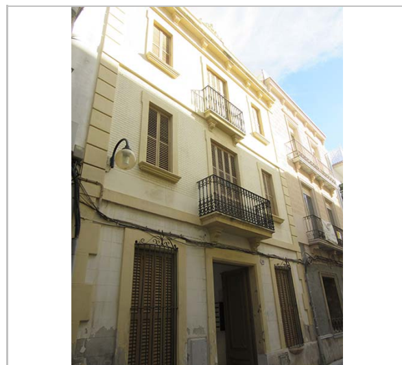
Façana. 18.1.2016. JM. Pujol
