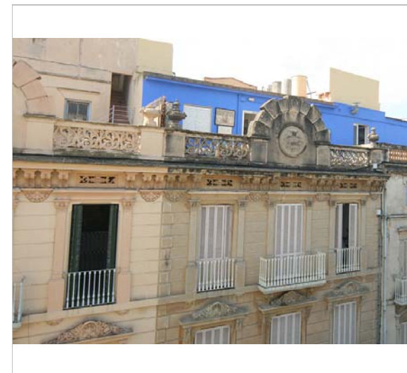
Detall del coronament de les façanes. 5.8.2014. JM. Pujol
