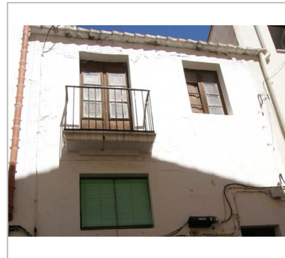
Part superior de l'edifici. 22.6.2016. Foix Marsé
