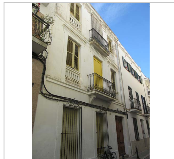
Façana. 18.1.2016. JM. Pujol
