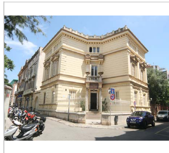
Vista de la casa. 3.6.2016. JM. Pujol
