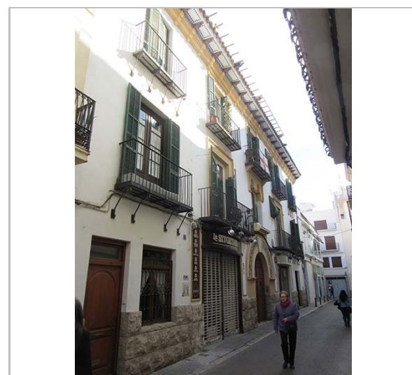
Façana. 18.1.2016. JM. Pujol
