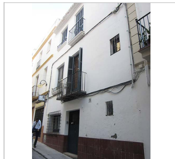
Façana. 28.19.2015. JM. Pujol
