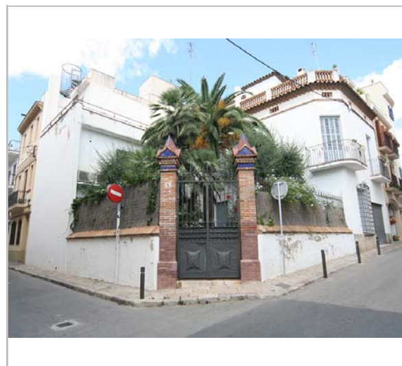
Vista de la casa. 13.8.2014. JM. Pujol
