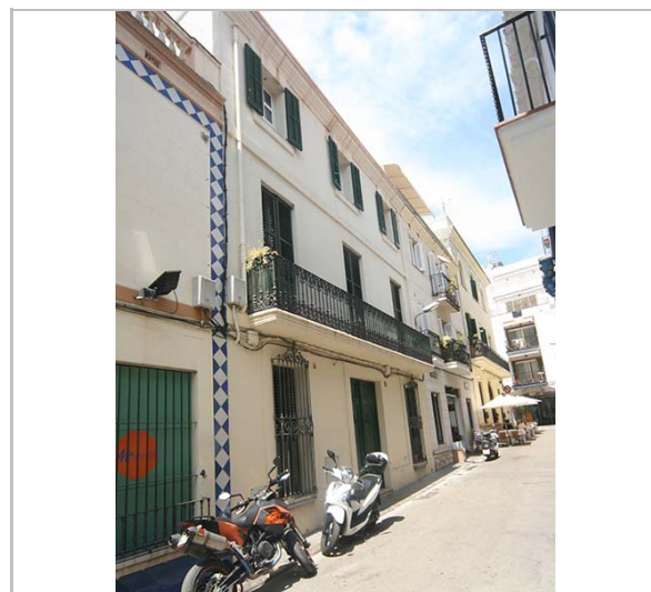
Façana. 3.6.2016. JM. Pujol
