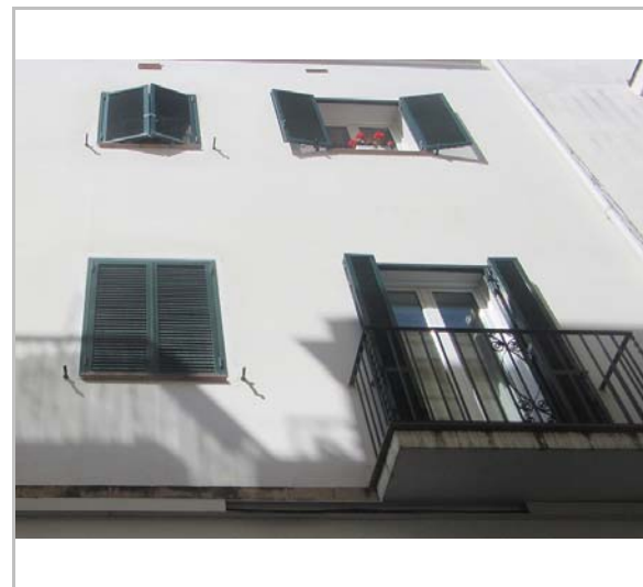
Detall de la façana. 1.7.2016. Sixto Pujol
