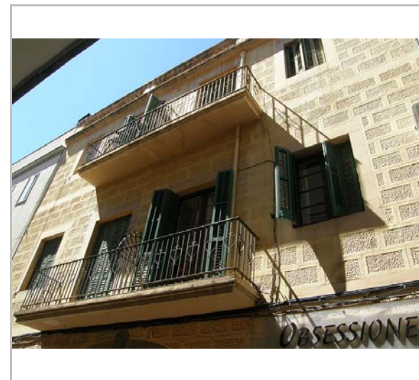
Part superior de l'edifici. 22.6.2016. Foix Marsé
