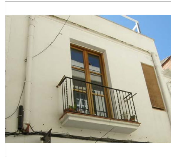
Part superior de l'edifici. 22.6.2016. Foix Marsé
