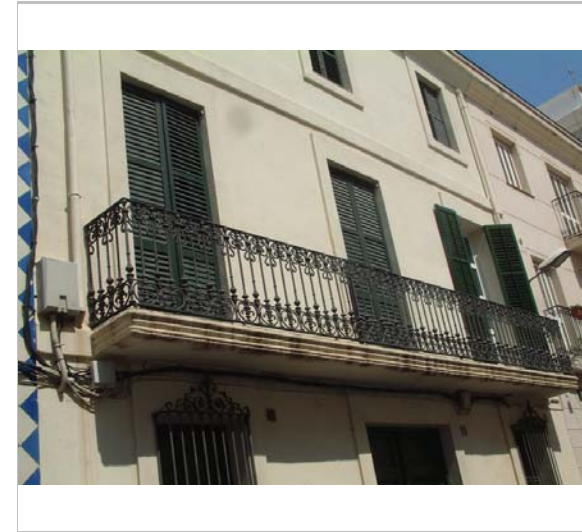
Part superior de l'edifici. 2006. Diputació de Barcelona
