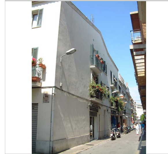
Façana del carrer de Sant Josep. 3.5.2006. Diputació de Barcelona
