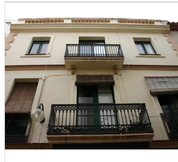
Part superior de l'edifici. 2006. Diputació de Barcelona
