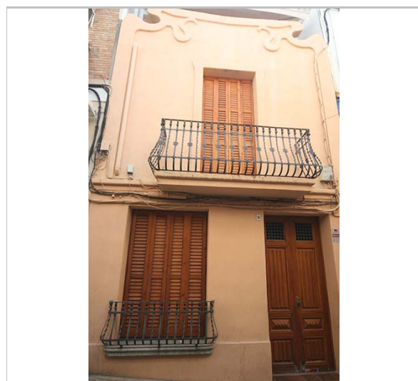
Façana. 16.6.2016. JM. Pujol
