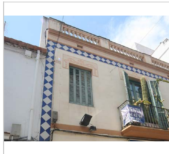
Detall de la façana. 3.6.2016. JM. Pujol
