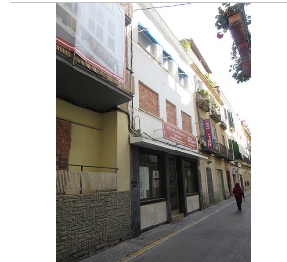
Façana del núm. 20. 18.1.2016. JM. Pujol
