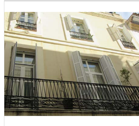
Detall de la façana. 18.1.2016.
