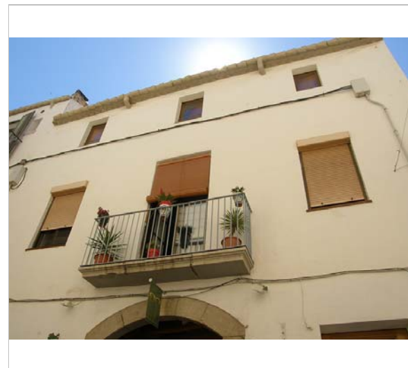
Part superior de l'edifici. 22.6.2016. Foix Marsé
