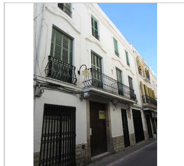
Façana. 18.1.2016. JM. Pujol
