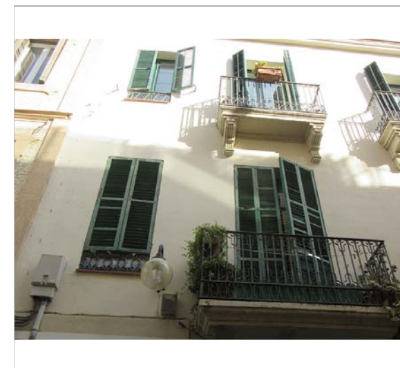
Detall de la façana. 18.1.2016. JM. Pujol
