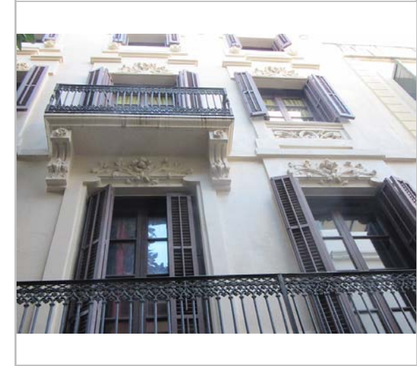
Detall de la façana. 28.10.2015. JM. Pujol
