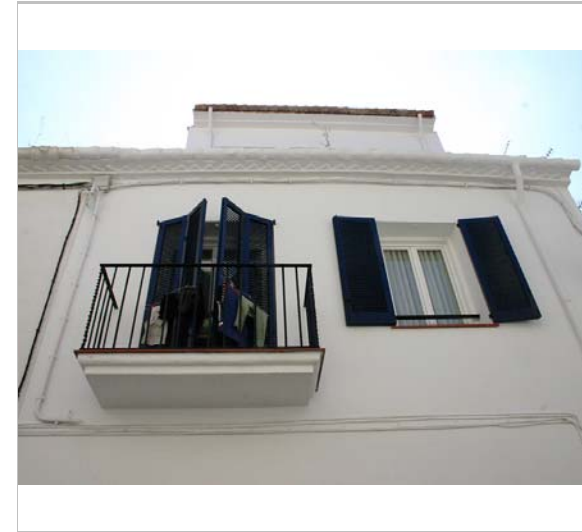
Part superior de l'edifici. 2006. Diputació de Barcelona
