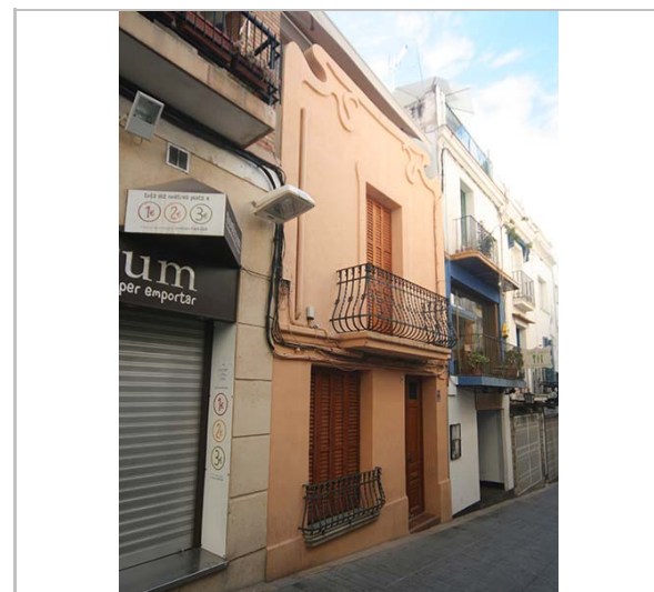
Façana. 16.6.2016. JM. Pujol
