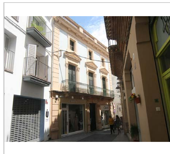
Façana. 3.6.2016. JM. Pujol
