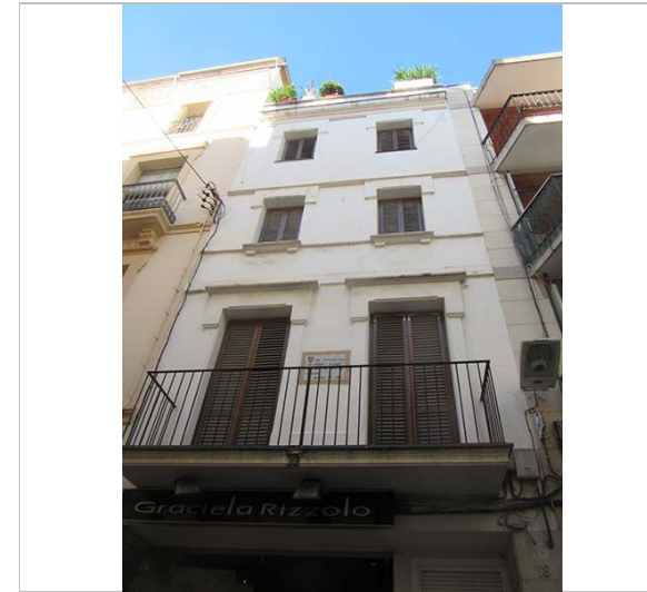
Part superior de la façana. 17.11.2015 JM. Pujol
