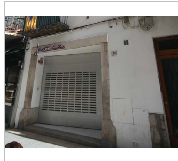
Detall de la façana. 16.6.2016. JM. Pujol
