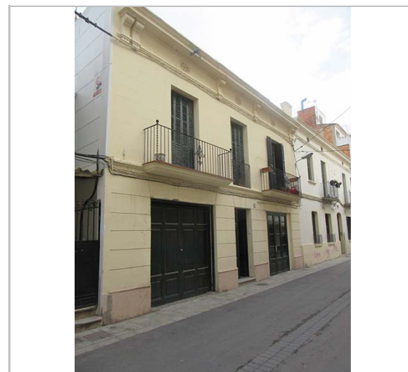
Vista de la casa. 29.2.2016. JM. Pujol
