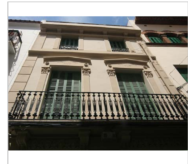
Part superior de la façana. 3.6.2016. JM. Pujol
