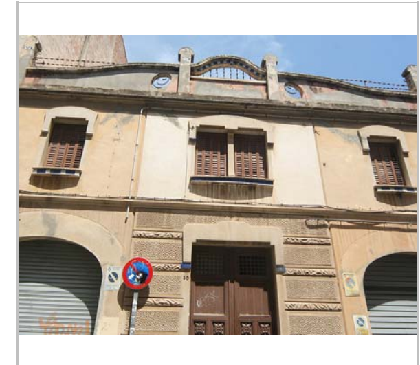
Façana. 3.6.2016. JM. Pujol
