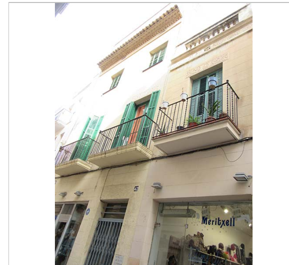
Façana. 29.2.1016. JM. Pujol
