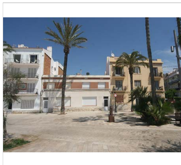
Façana. 3.6.2016. JM. Pujol
