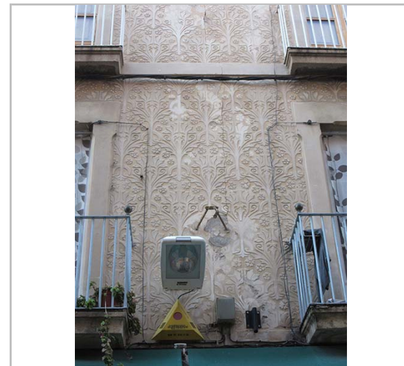
Detall dels esgrafiats de la façana. 22.2.2015. JM. Pujol
