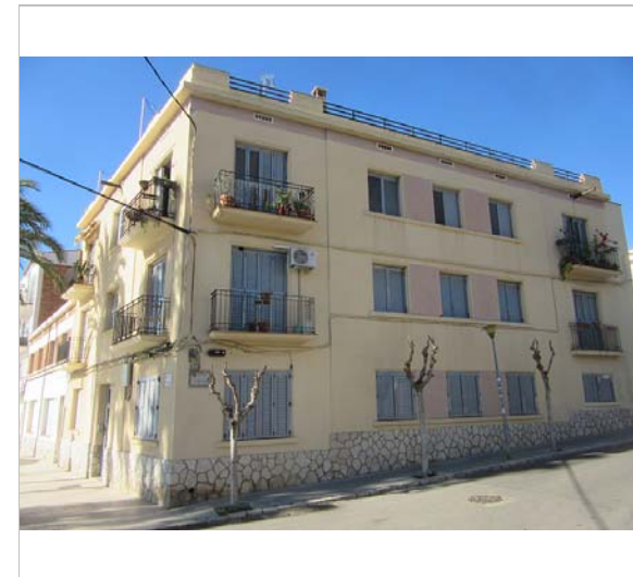
Façana lateral. 17.11.2015. JM. Pujol
