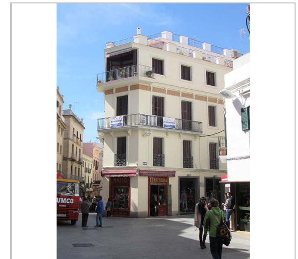
Façana. 26.3.2015. JM. Pujol
