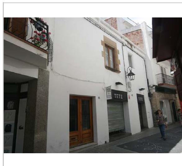
Façana. 3.6.2016. JM. Pujol
