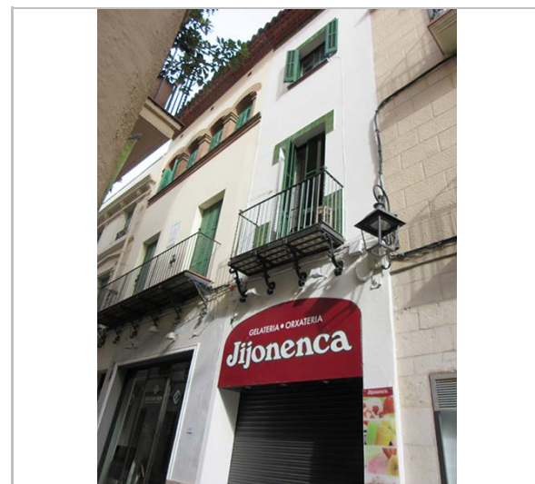
Façana. 29.2.2016 JM. Pujol
