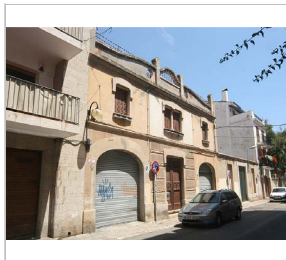
Façana. 3.6.2016. JM. Pujol
