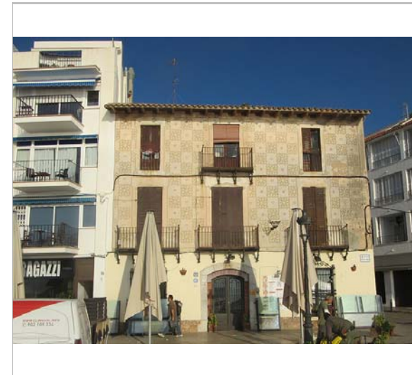
Façana. 21.10.2015. JM. Pujol
