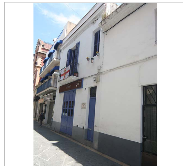
Façana. 3.6.2016. JM. Pujol
