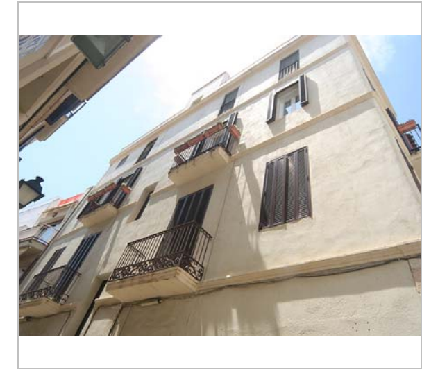
Part superior de la façana. 3.6.2016. JM. Pujol
