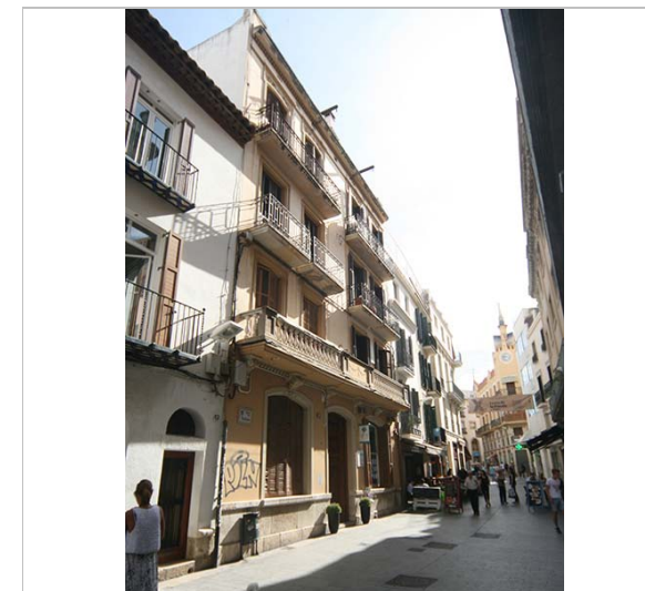
Façana. 16.6.2016. JM. Pujol
