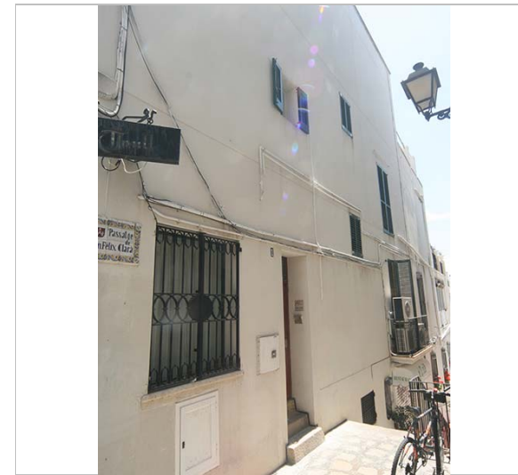
Façana del passatge de Fèlix Clarà. 3.6.2016. JM. Pujol
