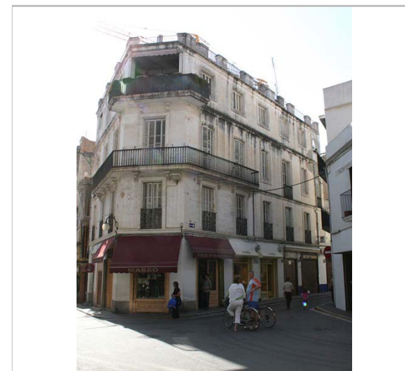
Vista de l'edifici. 2006 Diputació de Barcelona
