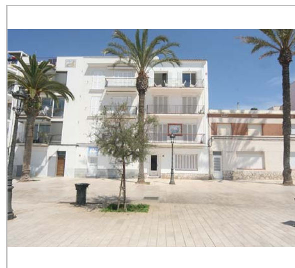
Façana. 3.3.2016. JM. Pujol
