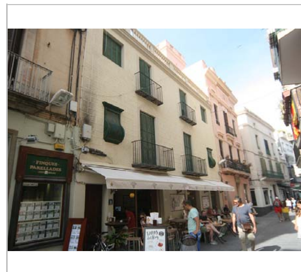
Façana. 16.6.2016 JM. Pujol
