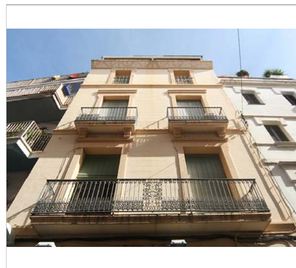
Part superior de la façana. 16.6.2016. JM. Pujol
