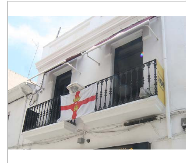
Detall dels balcons. 3.6.2016. JM. Pujol
