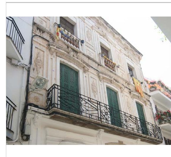
Detall de la façana. 3.6.2016. JM. Pujol
