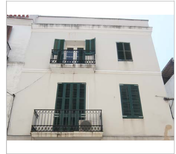
La part superior de l'edifici. 3.6.2016. JM. Pujol
