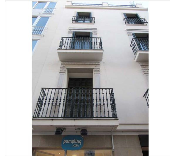
Part superior de la façana. 22.2.2015. JM. Pujol
