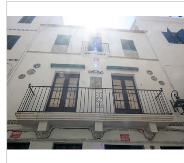
La part superior de l'edifici. 3.6.2016. JM. Pujol
