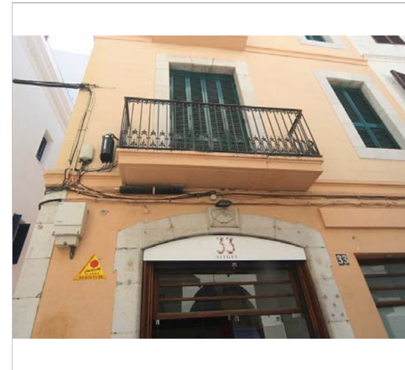
Detall de la façana. 3.6.2016. JM. Pujol
