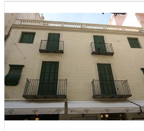
Part superior de la façana. 16.6.2016 JM. Pujol
