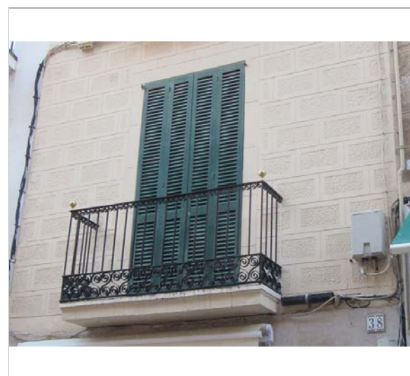
Detall de la façana. 22.2.2015. JM. Pujol
