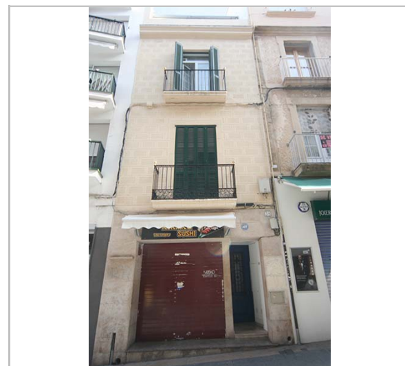
Façana. 16.6.2016. JM. Pujol
