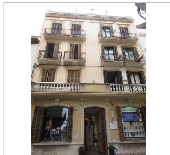
Façana. 27.7.2015 JM. Pujol
