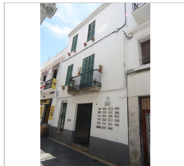
Façana. 3.6.2016. JM. Pujol
