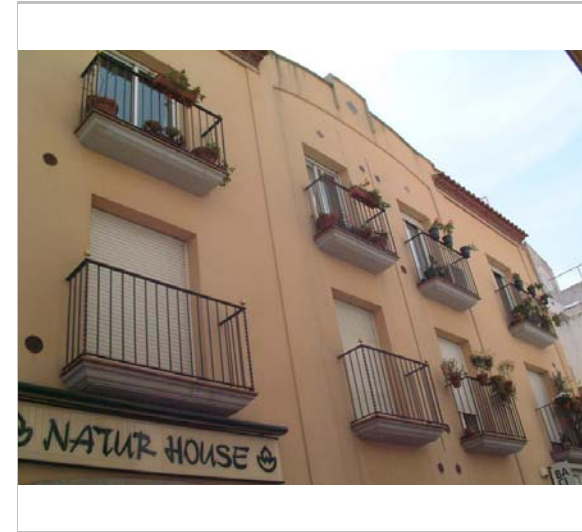
La part superior de la façana. 2006. Diputació de Barcelona
