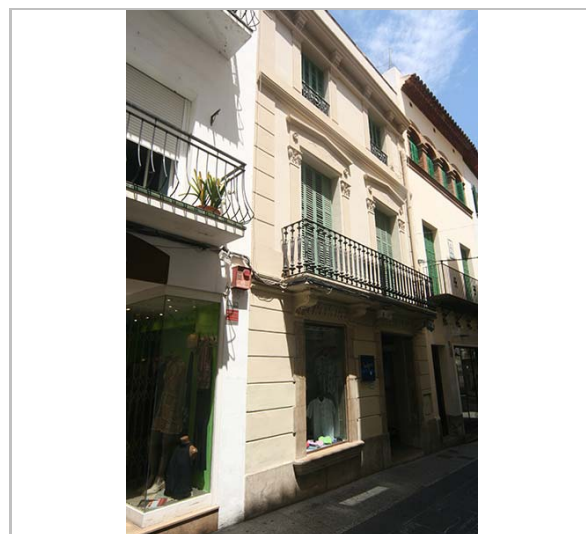
Façana. 3.6.2016. JM. Pujol
