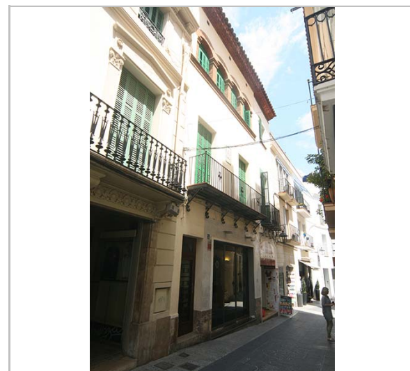
Façana. 3.6.2016 JM. Pujol
