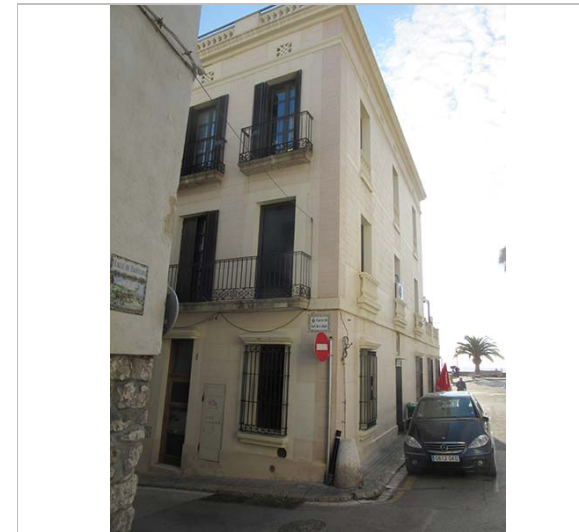
Façana lateral. 2015. JM. Pujol
