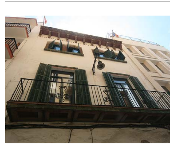
La part superior de l'edifici. 3.6.2016. JM. Pujol
