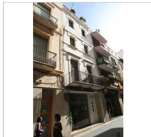
Façana. 16.6.2016. JM. Pujol
