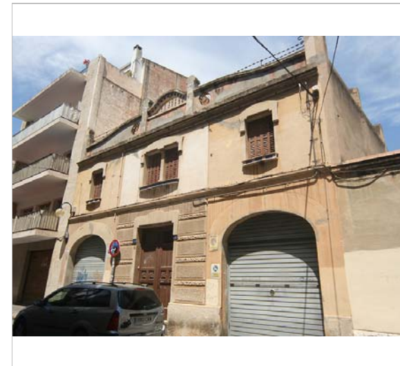
Façana. 3.6.2016. JM. Pujol
