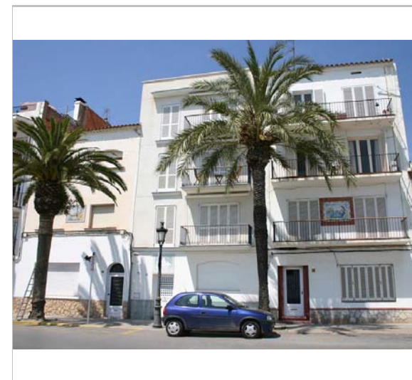
Vista dels tres edificis. 2006. Diputació de Barcelona
