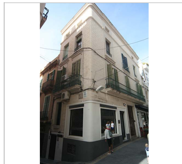
Façana. 16.6.2016. JM. Pujol
