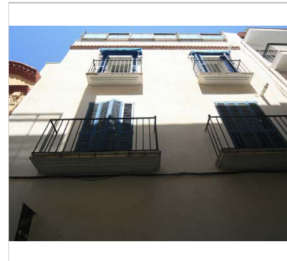
La part superior de l'edifici. 27.6.2016. Sixto Pujol
