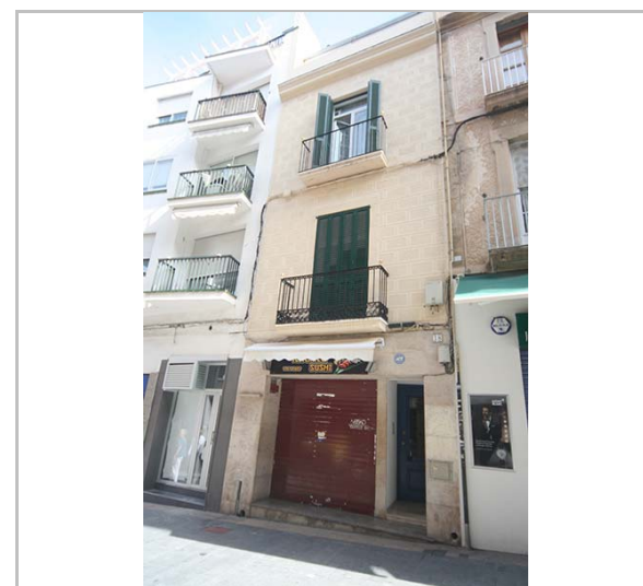
Façana. 16.6.2016. JM. Pujol
