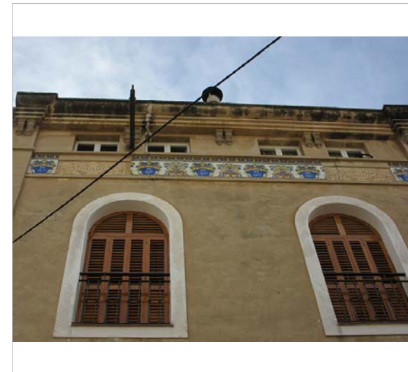
Part superior de la façana. 29.2.2016. JM. Pujol
