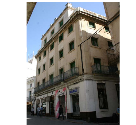
Vista de l'edifici. 25.4.2006. Diputació de Barcelona
