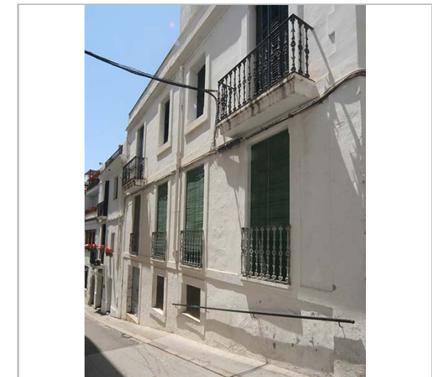
Façana del carrer d'en Tacó. 3.6.2016 JM. Pujol
