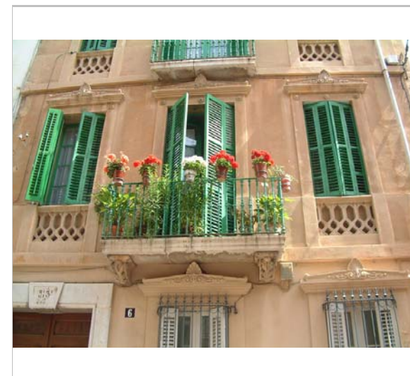
Detall de la façana. 2006 Diputació de Barcelona
