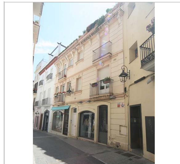
Façana. 3.6.2016. JM. Pujol
