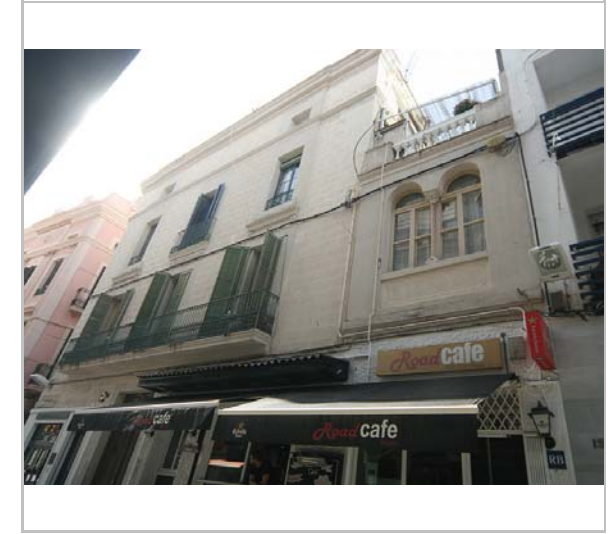
Part superior de l'edifici. 16.6.2016. JM. Pujol
