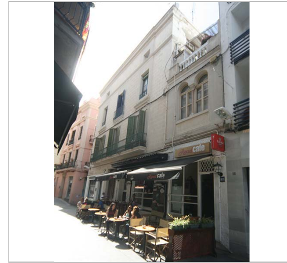
Façana. 16.6.2016. JM. Pujol
