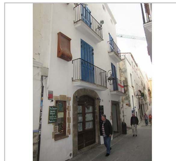
La façana. 28.10.2015. JM. Pujol
