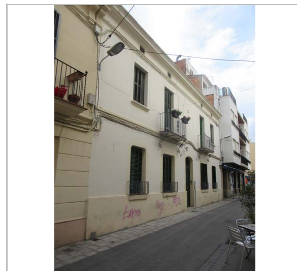
Façana. 29.2.2016. JM. Pujol
