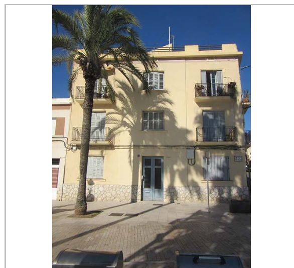
Façana. 17.11.2015. JM. Pujol
