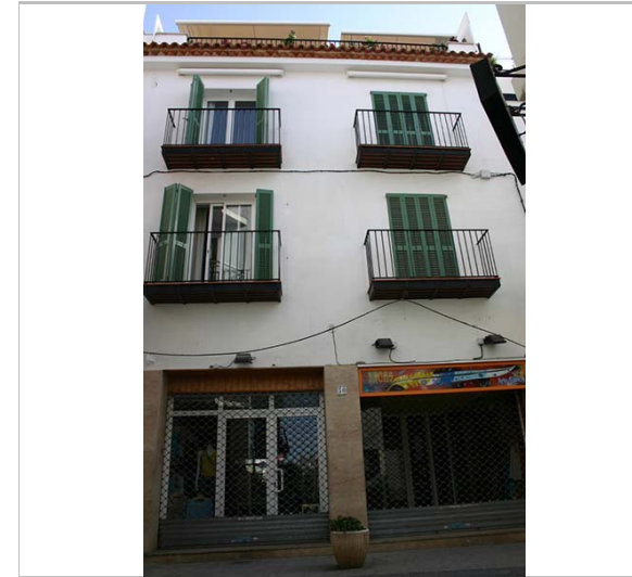
Vista de la façana principal. 25.4.2006. Diputació de Barcelona
