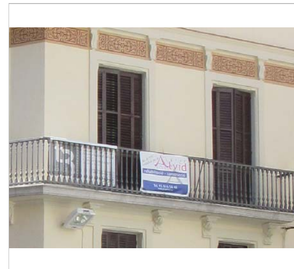
Detall de la façana. 26.3.2015. JM. Pujol
