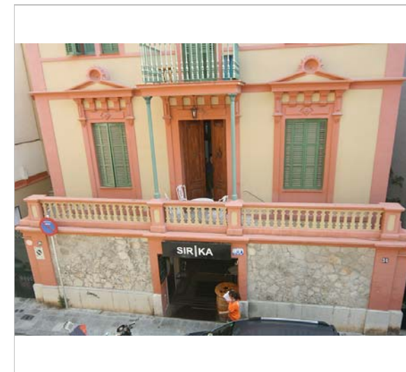
Detall de la façana. 5.8.2014. JM. Pujol
