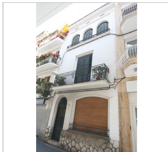
Façana. 3.6.2016. JM. Pujol
