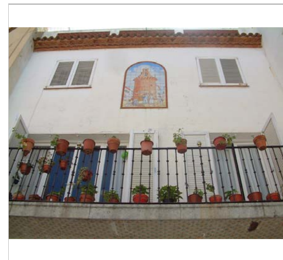
Detall de la façana. 2006. Diputació de Barcelona
