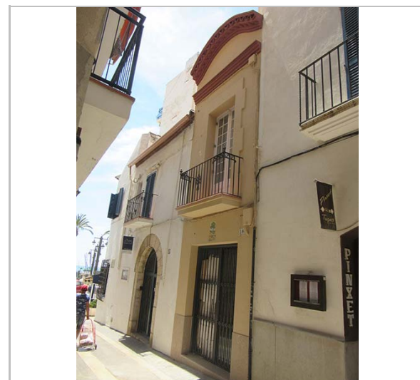
Façana. 9.6.2016. JM. Pujol
