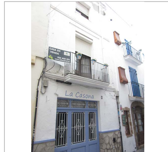
Façana. 28.10.2015 JM. Pujol
