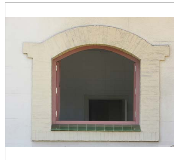
Detall de la façana. 1.7.2016. Sixto Pujol
