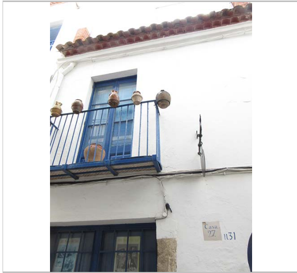
Detall de la façana. 29.2.2016 JM. Pujol
