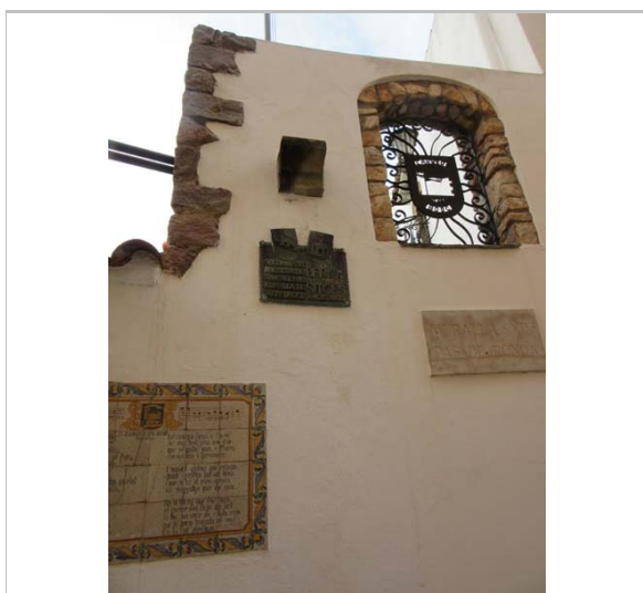
Detall de les plaques i plafons. 29.2.2016
