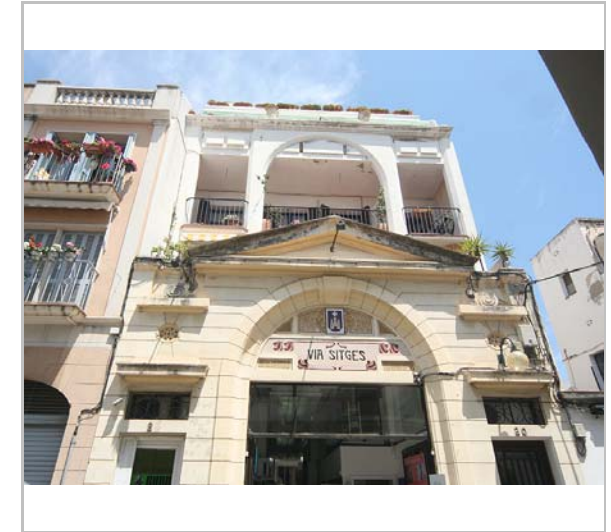
Detall de la façana. 3.6.2016. JM. Pujol
