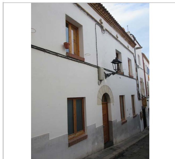
Façana. 29.2.2016 JM. Pujol
