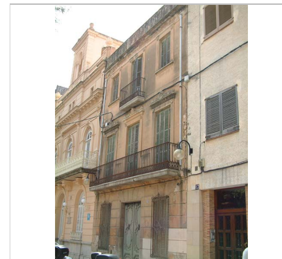
Vista de la façana. 2006. Diputació de Barcelona
