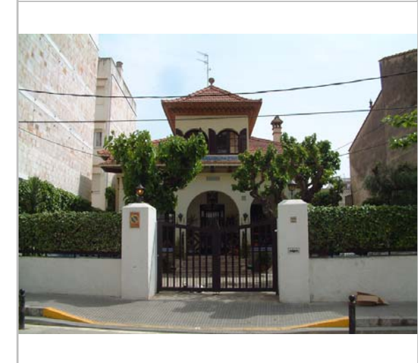
Vista de l'edifici. 2006. Diputació de Barcelona
