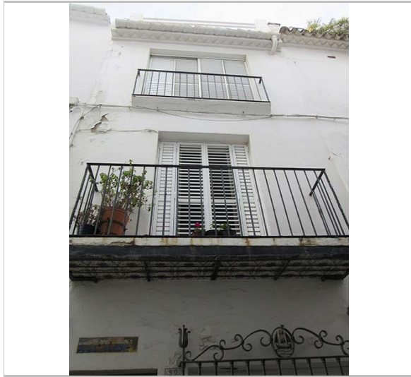
Detall de la façana. 29.2.2016. JM. Pujol
