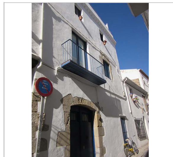
Façana. 17.11.2015 JM. Pujol
