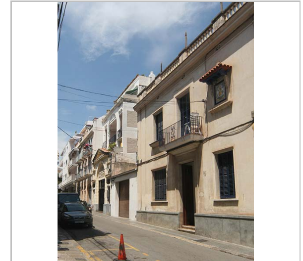
Façana del carrer de Francesc Gumà. 3.6.2016 JM. Pujol
