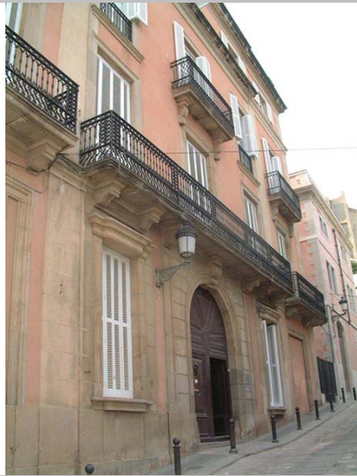
Façana de la Davallada. 2006.
