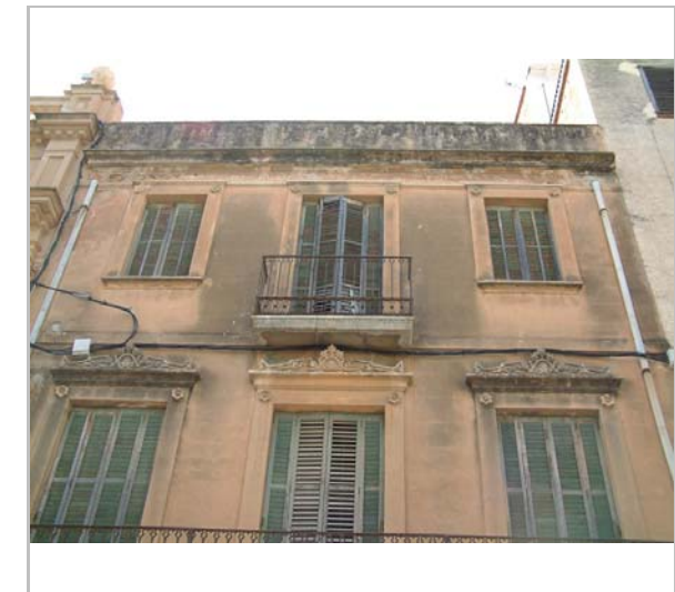
Detall de la façana. 2006. Diputació de Barcelona
