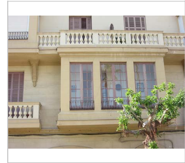
Detall de la façana. 1.7.2016. Sixto Pujol
