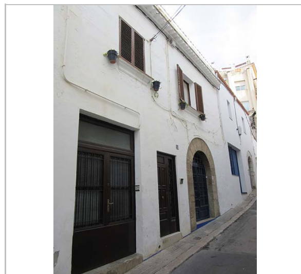
Façana. 29.2.2016 JM. Pujol
