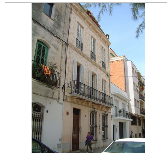
Detall de la façana. 2006. Diputació de Barcelona
