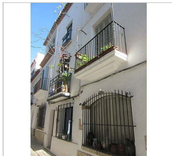
Façana. 17.11.2015. JM. Pujol
