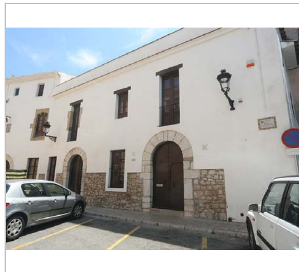
Façana principal. 3.6.2016. JM. Pujol
