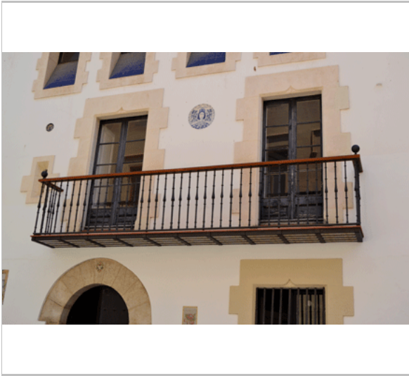
El balcó restaurat. 2014. Ajuntament de Sitges
