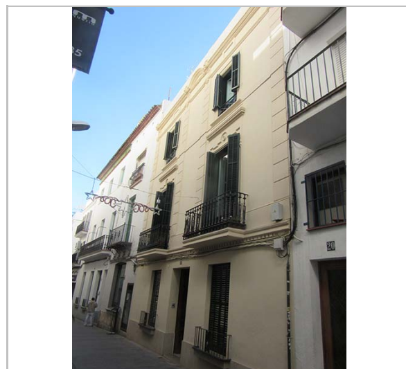
Façana. 17.11.2015. JM. Pujol
