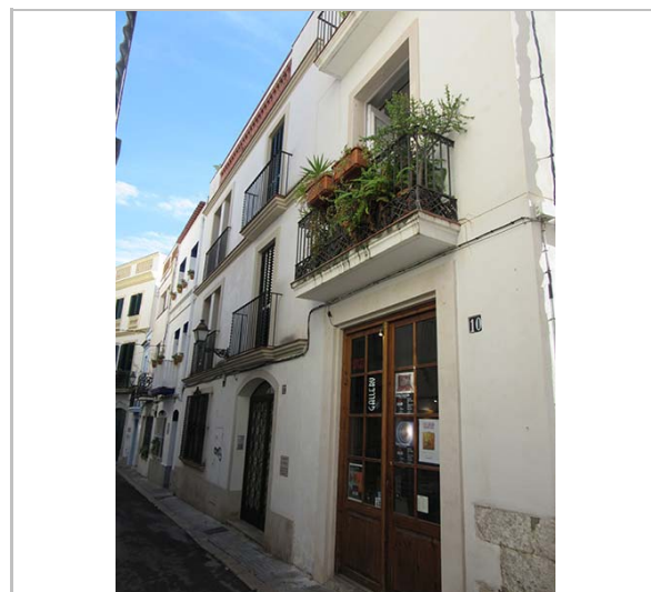
Façana principal. 2.1.2016. JM. Pujol
