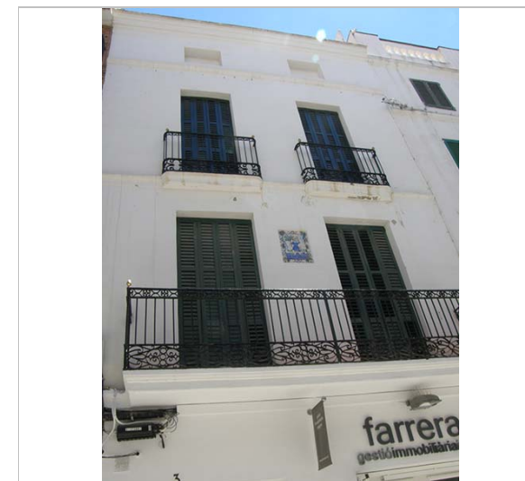
Part superior de l'edifici. 22.6.2016. Foix Marsé
