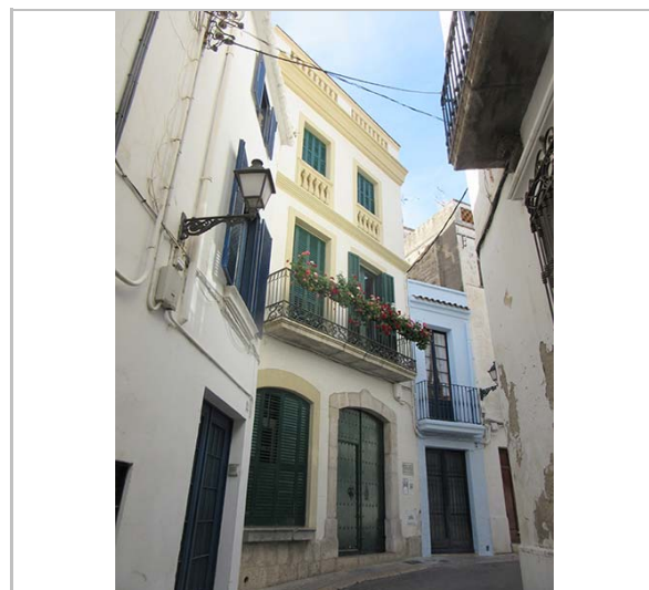
Façana. 16.6.2016. JM. Pujol
