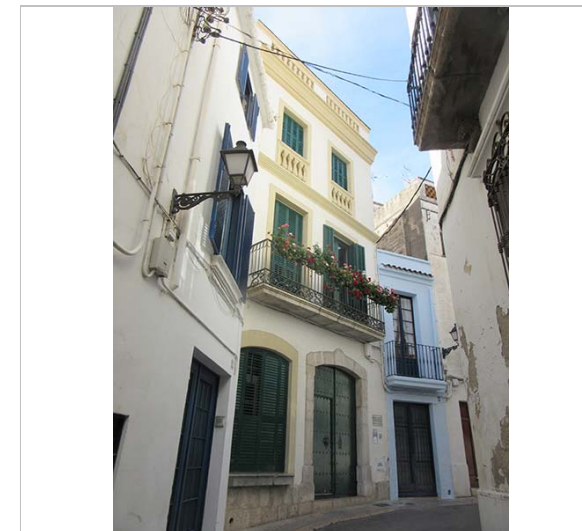
A l'esquerra, façana de la casa. 16.6.016. JM. Pujol
