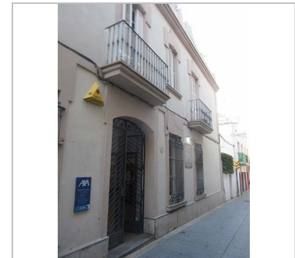
Façana. 17.11.2015 JM. Pujol
