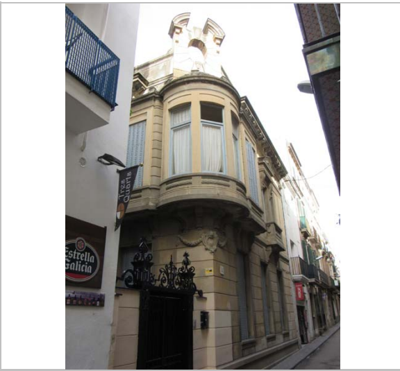
Façana. 29.2.2016. JM. Pujol
