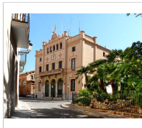
Façana principal. 2014. Sixto Pujol
