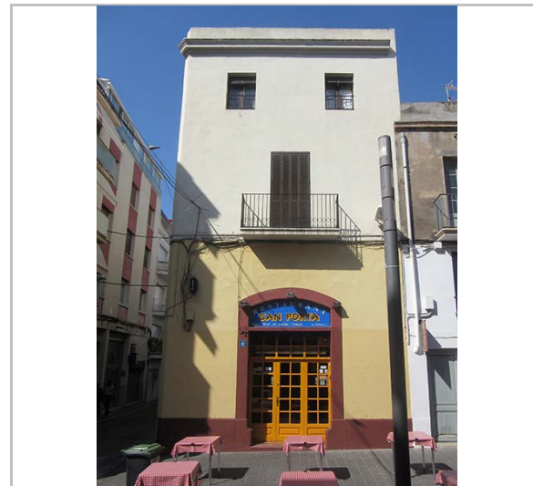
Façana principal. 1.7.2016. Sixto Pujol
