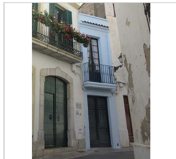
Façana. 16.6.2016. JM. Pujol
