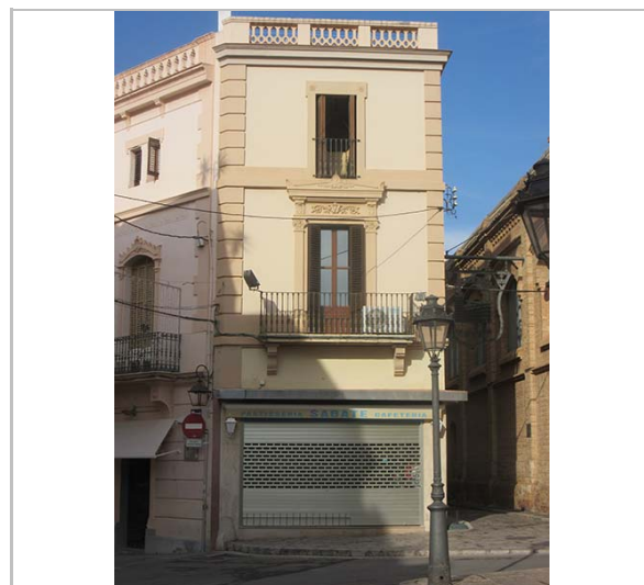
Façana principal. 2.12.2015. JM. Pujol
