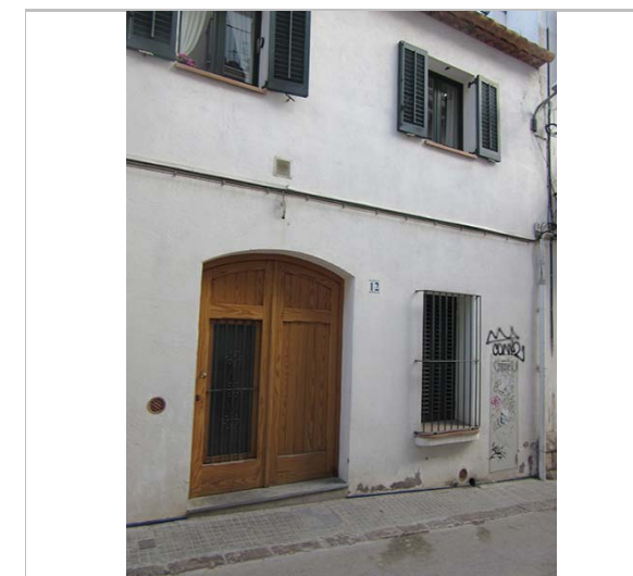
Façana del núm 12. 2.1.2016
