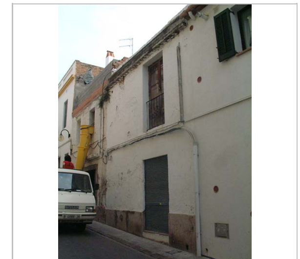
Façana del núm. 14. 2006.
