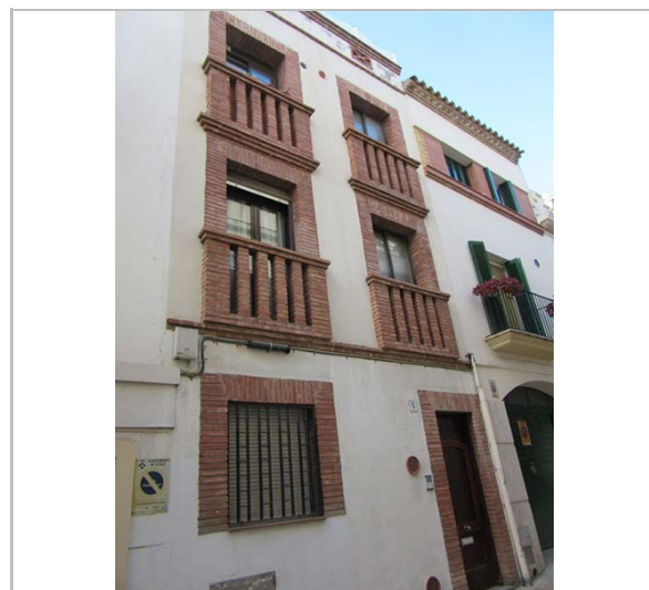
Façana. 2.1.2016. JM. Pujol
