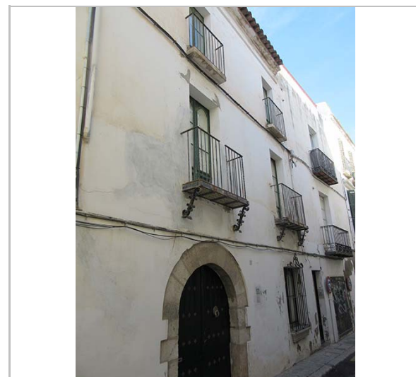
Façana. 2.1.2016. JM. Pujol
