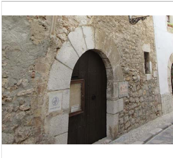
Vista de detall dels baixos. 29.2.2016. JM. Pujol
