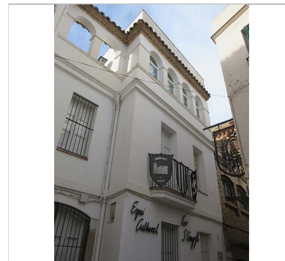
Detall de la façana. 29.2.2016. JM. Pujol
