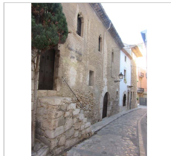
Façana. 17.11.2015. JM. Pujol
