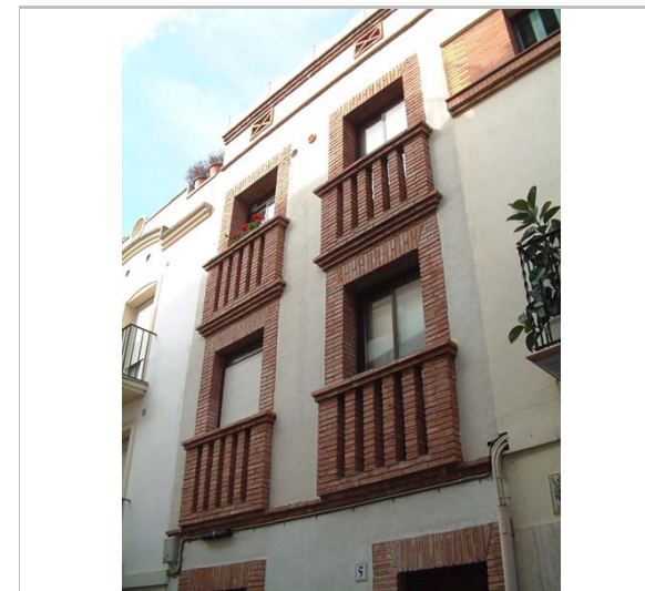
Detall dels balcons. 2006. Diputació de Barcelona
