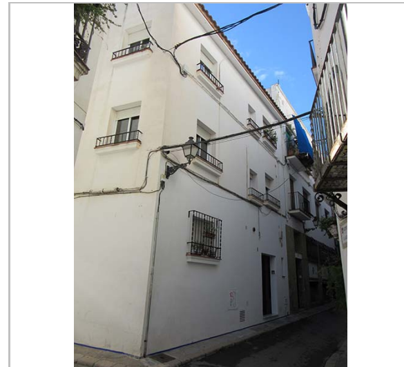
Façana principal. 2.1.2016. JM. Pujol
