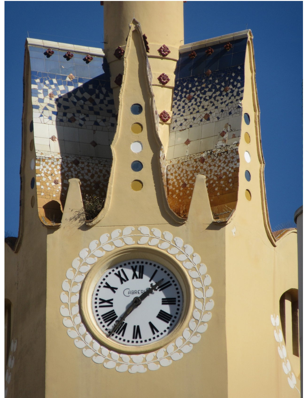
Casa Bartomeu Carbonell i Mussons. Detall del coronament i rellotge. Arquitecte Ignasi Mas i Morell
