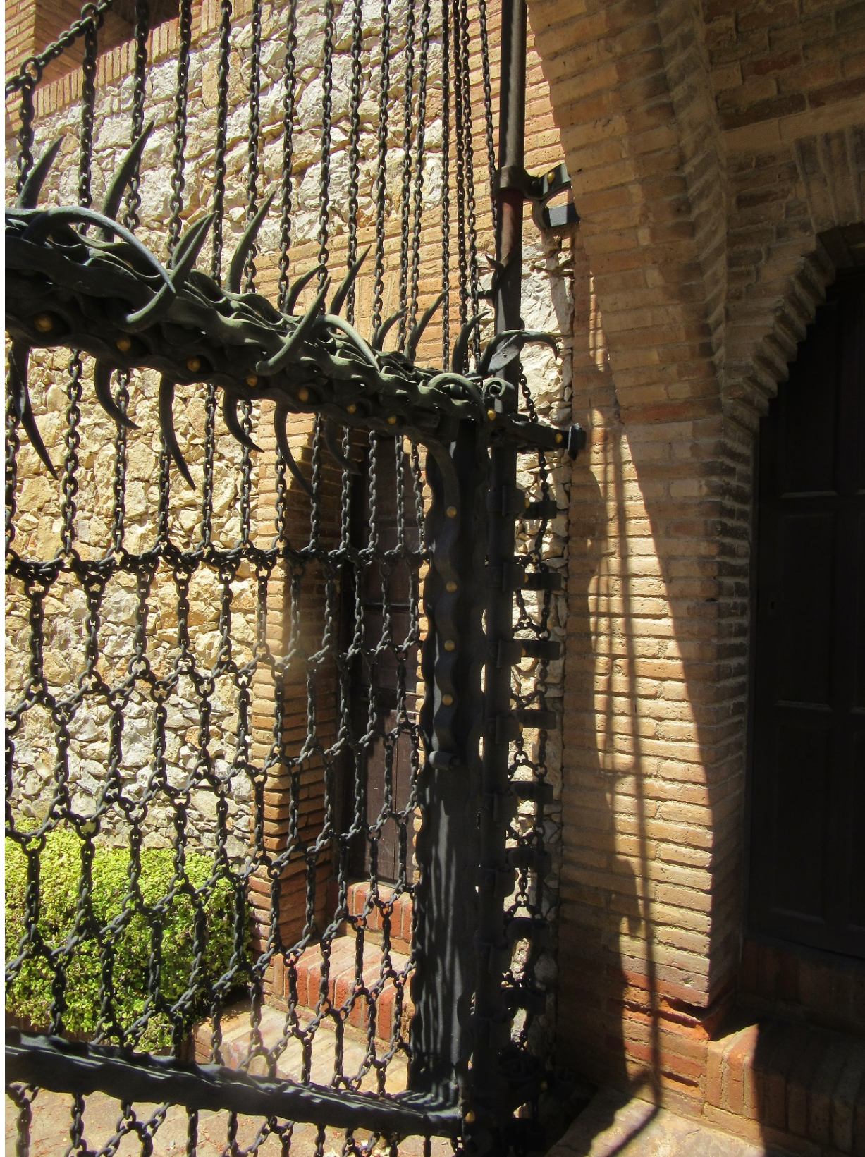
Portal del Cellar Güell Garraf . Arquitectes Antoni Gaudi Cornet i Francesc Berenguer
