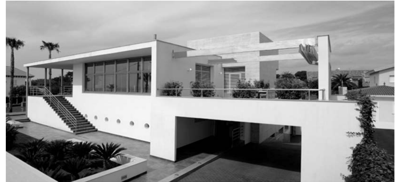
Casa Casabó –Casa Barco. Arq. Esteve Marco Cortina -1934
