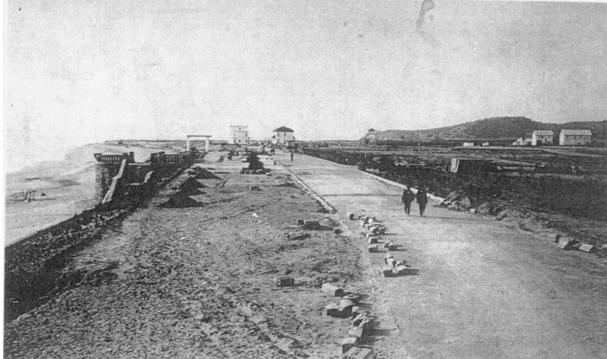
Construcció del Passeig Marítim (1922)
