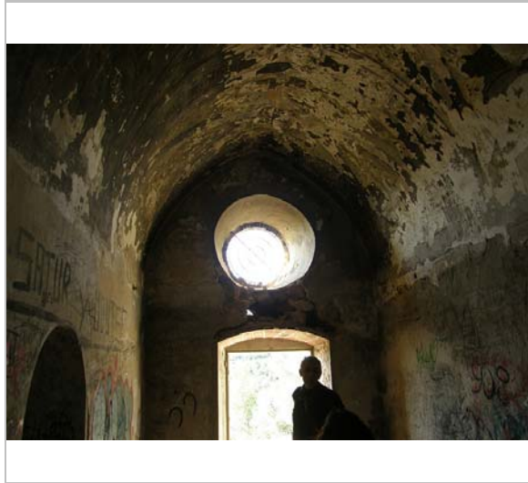
Vista interior. 26.11.2013. Jaume Marsé Ferrer
