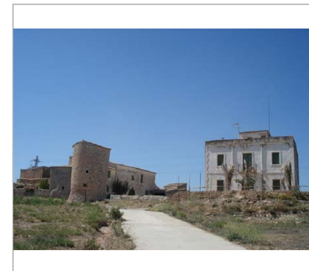
Vista de l'emplaçament. 23.5.2006. Diputació de Barcelona
