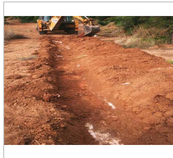
Excavació amb seguiment arqueològic. A. Vidal.
