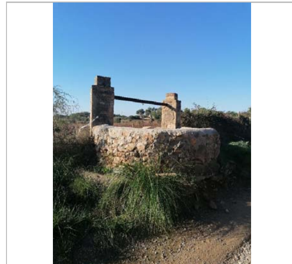
Vista del pou. 2020. Esteve Mestres Roca
