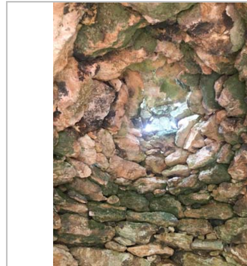
Vista de del sostre. 2020. Drac Verd de Sitges
