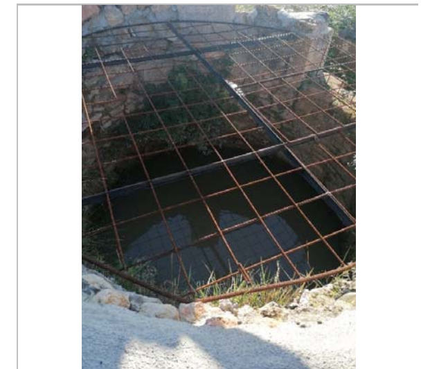
Vista del pou. 2020. Esteve Mestres Roca
