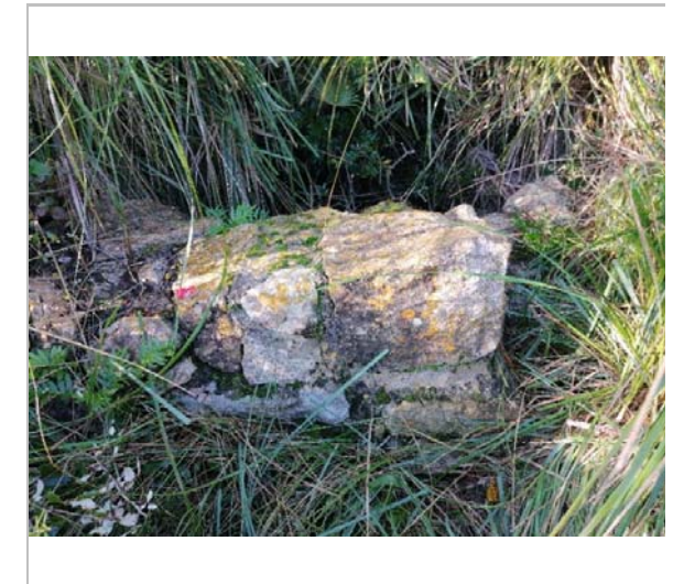
Vista del pou. 2020. Esteve Mestres Roca
