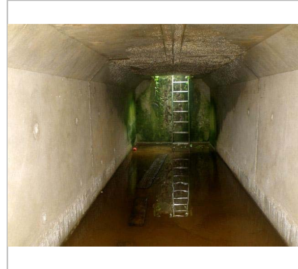
El túnel per sota l'autopista. 2013. espeleoindex
