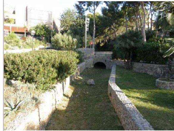
Canalització de la part final. 6.1.2015 Jaume Marsé
