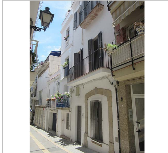
Vista del carrer Nou. 9.6.2016. JM. Pujol
