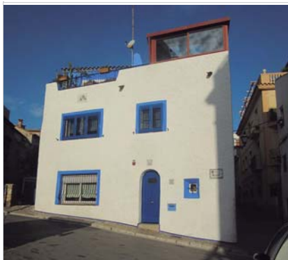
Vista de la casa. 21.10.2015 JM. Pujol
