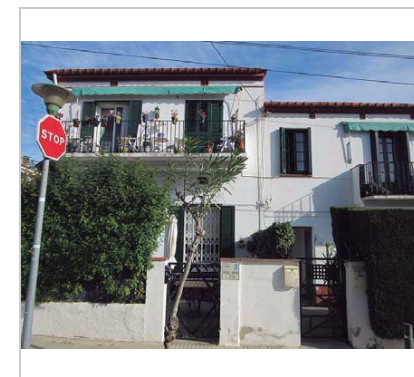
Vista de la casa. 2.1.2016 JM. Pujol
