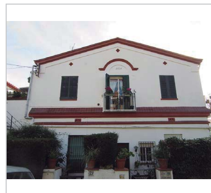
Vista de la casa. 2.1.2016 JM. Pujol
