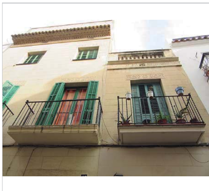
Vista superior de l'edifici. 29.2.2016 JM. Pujol
