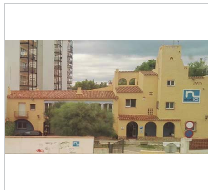
Façana Nord. 29.9.2016. JM. Pujol
