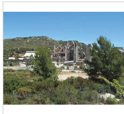
Vista de la fàbrica. 23.5.2014 Jaume Marsé
