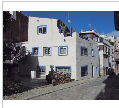
Vista de la casa. 3.3.2015 JM. Pujol
