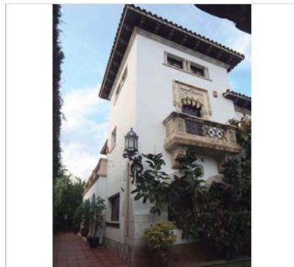
Vista de la Casa. 12.5.2016. JM. Pujol
