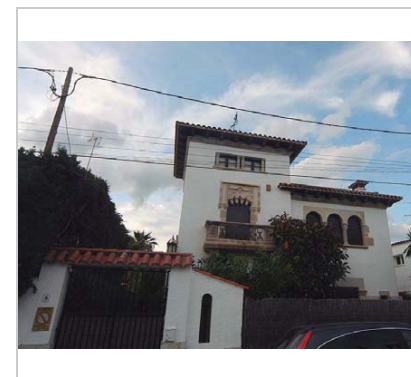
Vista de la Casa. 12.5.2016. JM. Pujol
