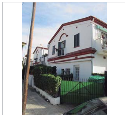
Vista de la casa. 2.1.2016 JM. Pujol
