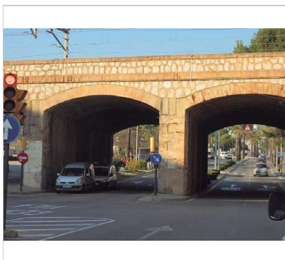
Vista el pont, banda sud. 14.1.2015 JM. Pujol
