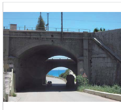
Viaducte de Vallcarca. 30.5.2016. JM. Pujol
