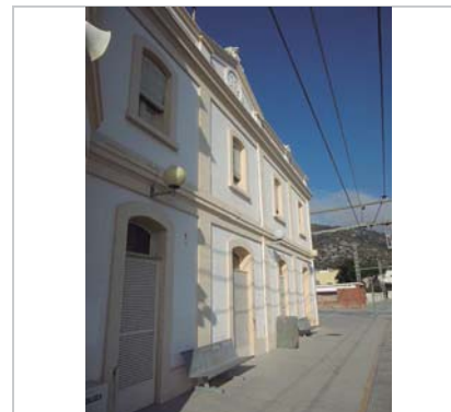
Detall de la façana. 26.1.2016.
