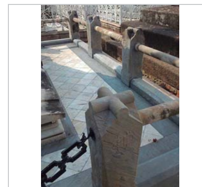
Detall del tancament. 29.9.2015. JM. Pujol
