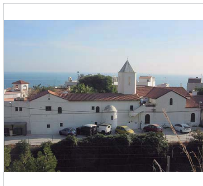
Façana nord. 26.1.2016 JM. Pujol
