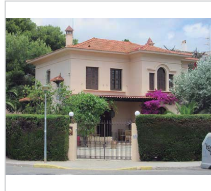
Vista de la casa. 3.7.2016. JM. Pujol
