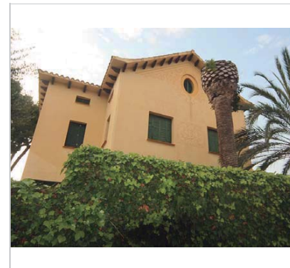
Vista de la casa. 5.12.2015. JM. Pujol
