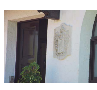
Detall de la façana. 23.6.2016. Sixto Pujol
