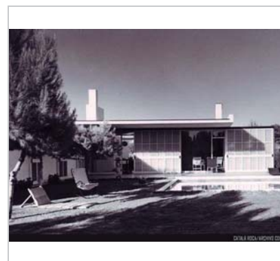
Vista de la casa. Català Roca. Arxiu Coderch.
