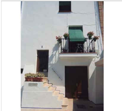
Detall de la façana. 27.6.2016. Sixto Pujol
