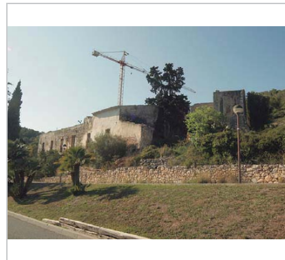
Vista general. 15.5.2016. JM. Pujol
