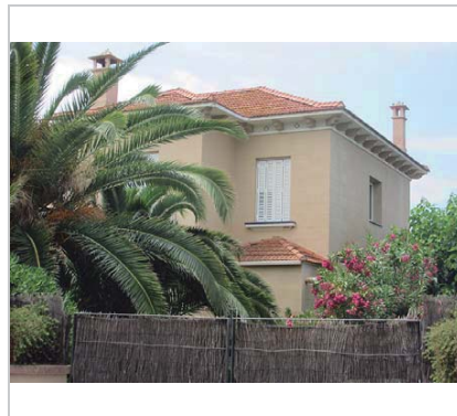
Vista de la casa. 3.7.2016. JM. Pujol
