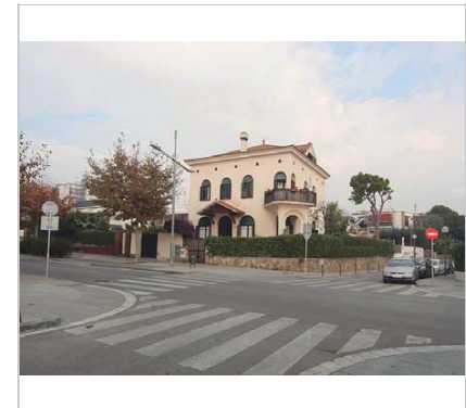
Vista de la casa. 5.12.2015. JM. Pujol
