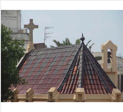
Coberta de la capella. 27.7.2015. JM. Pujol
