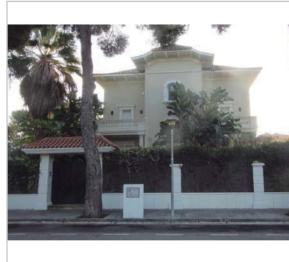
Vista de la casa. 9.12.2015. JM. Pujol
