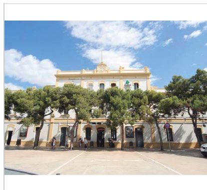
Vista de l'estació. 13.8.2014. JM. Pujol
