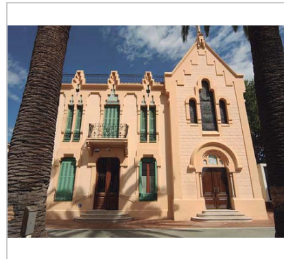
Vista de la casa. 13.8.2014. JM. Pujol
