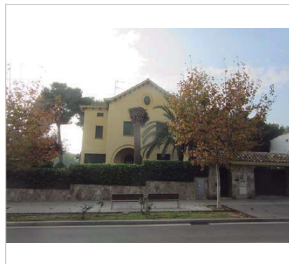
Vista de la casa. 5.12.2015. JM. Pujol
