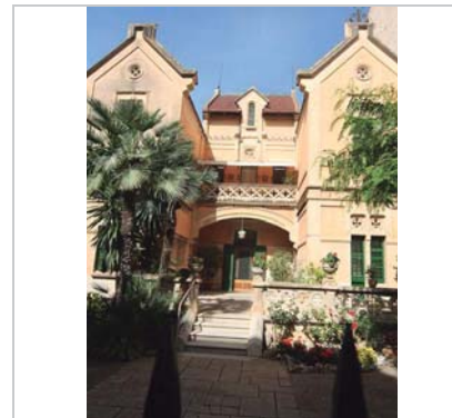
Vista de la casa. 16.6.2016. JM. Pujol
