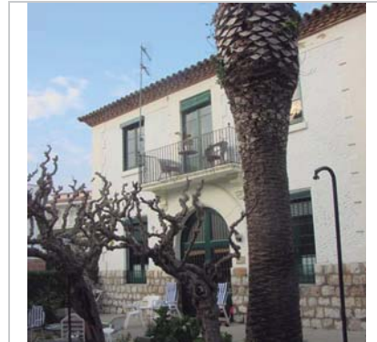
Vista de la casa. 2015. JM. Pujol
