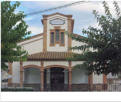
Vista de la façana principal. 28.10.2015. JM. Pujol
