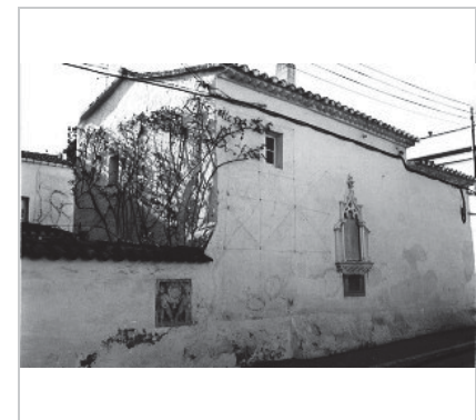
Façana amb la capella. 1991. PEC. Ajuntament de Sitges
