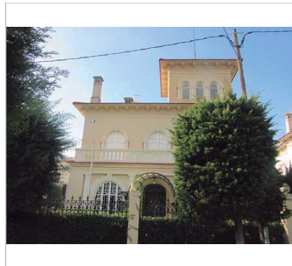
Vista de la casa. 11.12.2015. JM. Pujol
