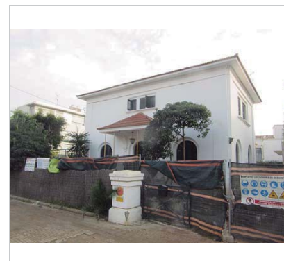
Vista de la casa. 5.12.2015. JM. Pujol
