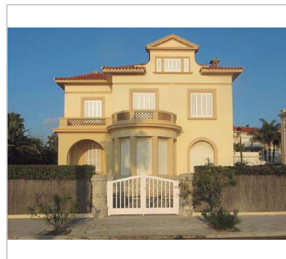
Vista de la casa. 9.12.2015. JM. Pujol
