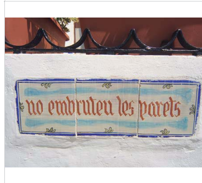
Detall de la façana. 27.6.2016. Sixto Pujol
