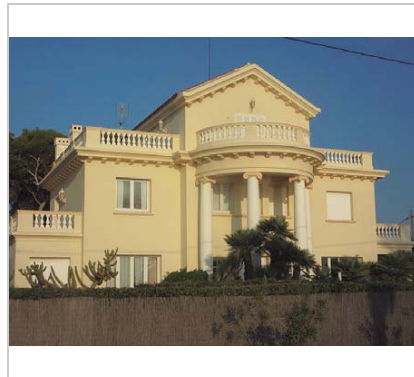
Vista de la casa. 9.12.2015. JM. Pujol
