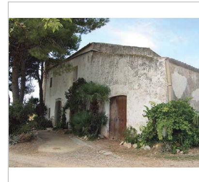
Edifici annex a la Torre. 30.8.2013 Jaume Marsé
