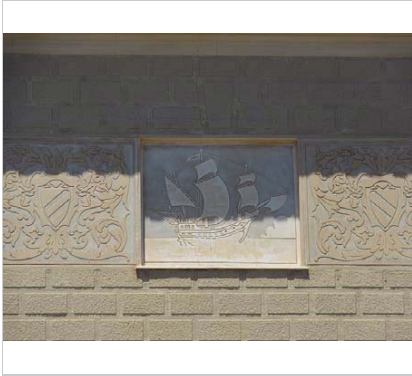
Detall de la façana. 22.6.2016. Sixto Pujol
