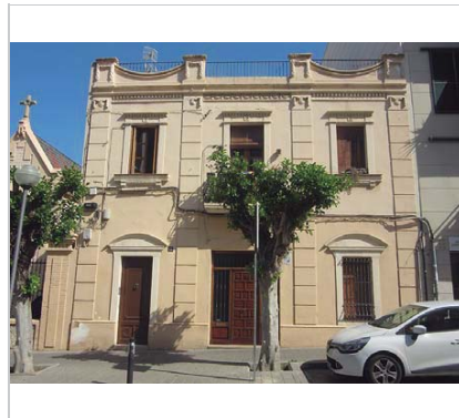
Façana principal. 1.7.2016. Sixto Pujol
