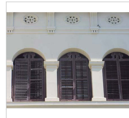
Detall de la façana. 27.6.2016 Sixto Pujol
