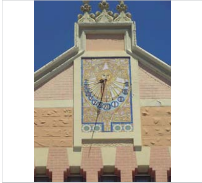
Detall de la façana. 23.6.2016.
