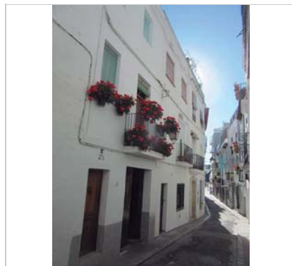
Façana. 17.11.2015. JM. Pujol
