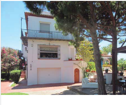
Vista lateral de la casa. 22.6.2016. Sixto Pujol
