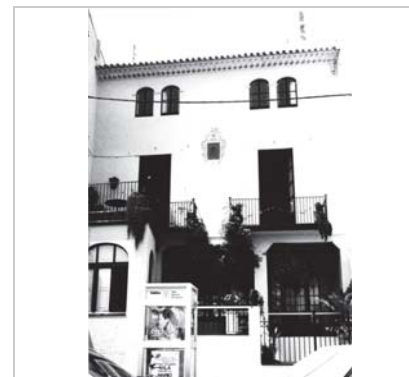
Vista general de la casa. 1991 Isabel Coll Mirabent
