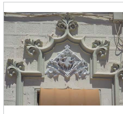
Detall de la façana. 23.6.2016. Sixto Pujol
