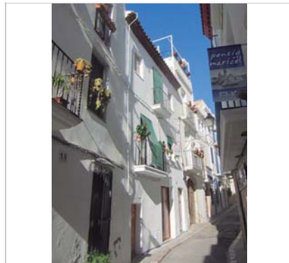
Façana. 17.11.2015. JM. Pujol
