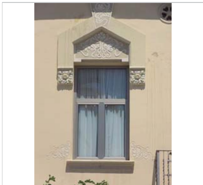
Detall de la façana. 23.6.2016.
