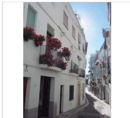
Façana. 17.11.2015 JM. Pujol
