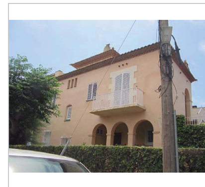
Vista de la façana lateral. 3.7.2016. JM. Pujol
