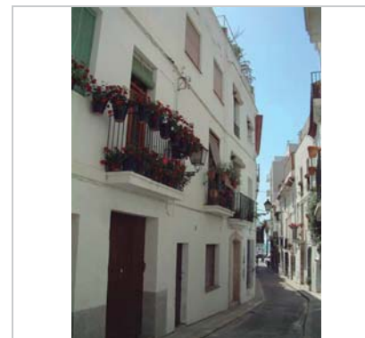
Detall de la façana. 26.4.2006 Diputació de Barcelona
