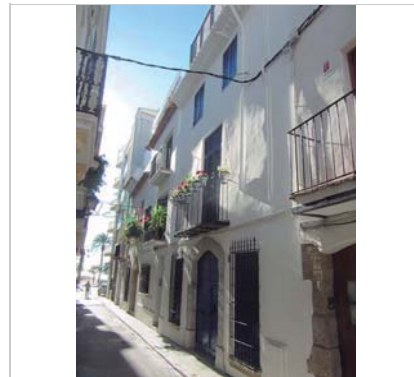
Façana. 17.11.2015. JM. Pujol
