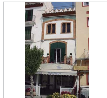
Detall de la façana. 3.5.2006. Diputació de Barcelona
