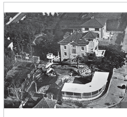
Foto històrica. Vista aèria.
