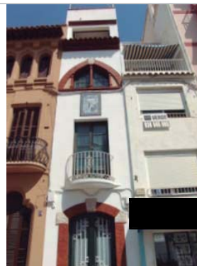
Detall de la façana. 22.8.2012. Ajuntament de Sitges
