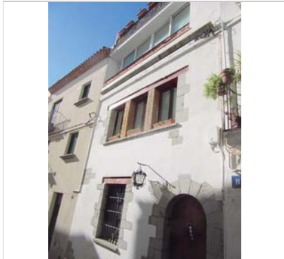
Detall de la façana. 17.11.2015. JM. Pujol
