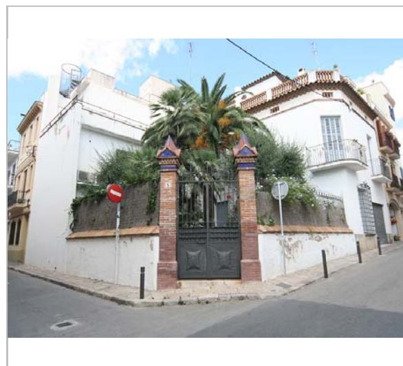
Vista de la casa. 13.8.2014. JM. Pujol
