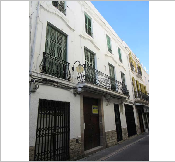
Façana. 18.1.2016. JM. Pujol
