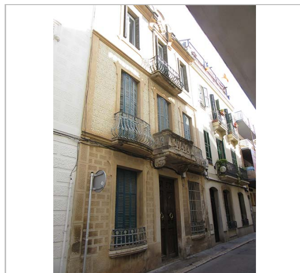
Façana. 18.1.2016. JM. Pujol
