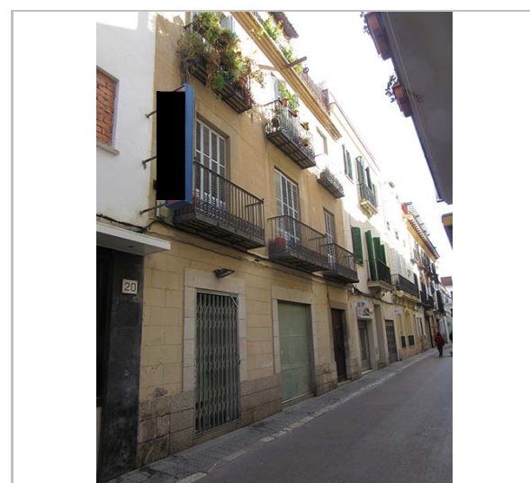
Façana del núm.18. 18.1.2016. JM. Pujol
