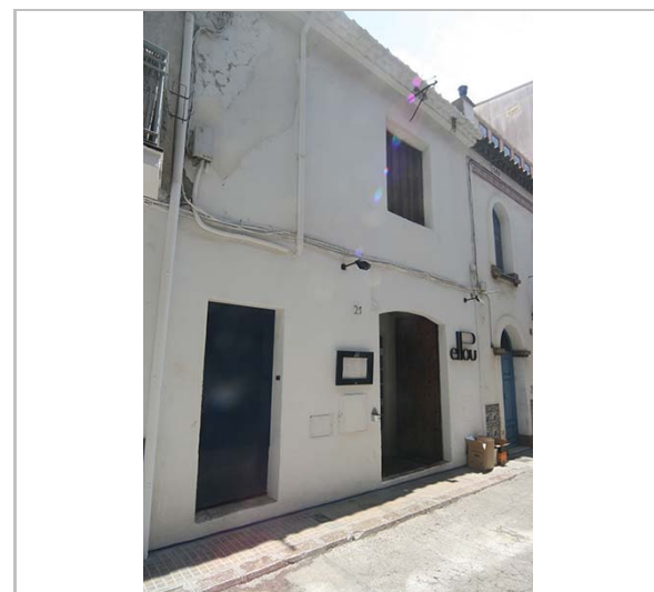
Façana. 3.6.2016. JM. Pujol
