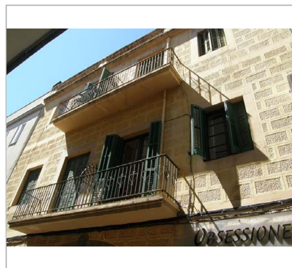
Part superior de l'edifici. 22.6.2016. Foix Marsé
