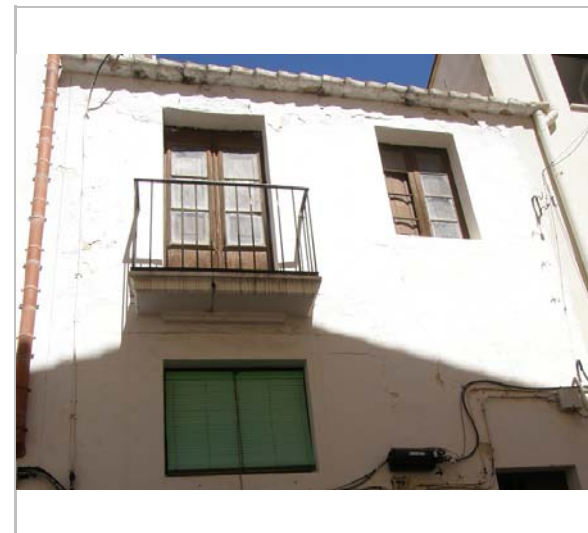
Part superior de l'edifici. 22.6.2016. Foix Marsé
