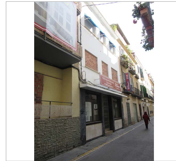
Façana del núm. 20. 18.1.2016. JM. Pujol
