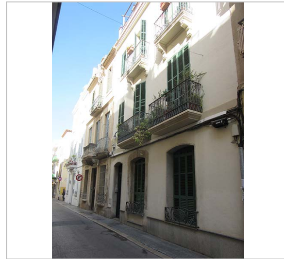
Façana. 18.1.2016. JM. Pujol
