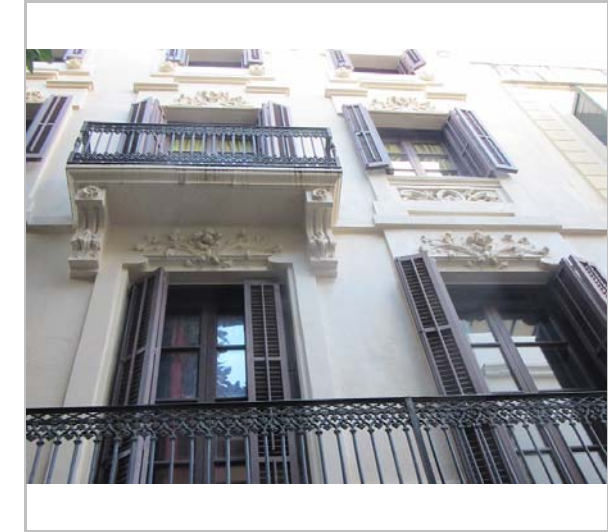
Detall de la façana. 28.10.2015. JM. Pujol
