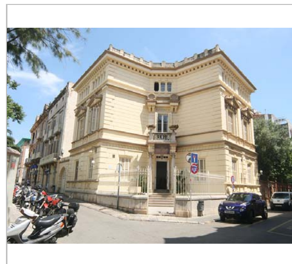
Vista de la casa. 3.6.2016. JM. Pujol
