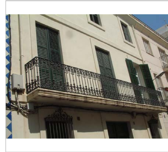
Part superior de l'edifici. 2006. Diputació de Barcelona
