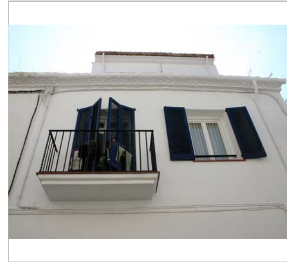
Part superior de l'edifici. 2006. Diputació de Barcelona
