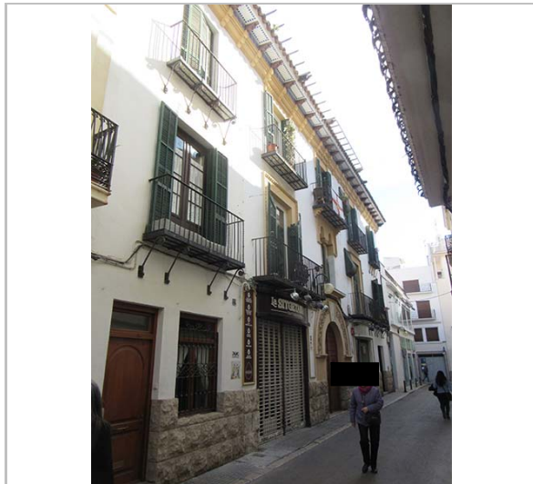
Façana. 18.1.2016. JM. Pujol
