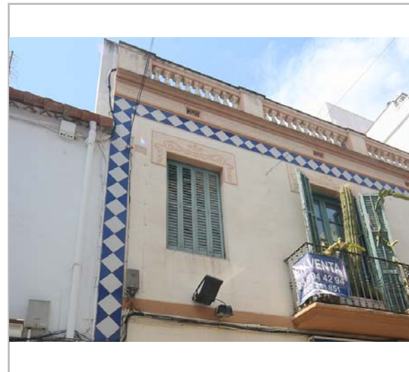
Detall de la façana. 3.6.2016. JM. Pujol
