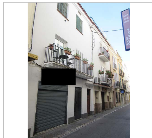
Façana. 18.1.2016. JM. Pujol
