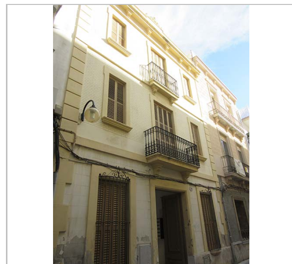
Façana. 18.1.2016. JM. Pujol
