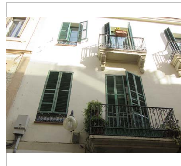
Detall de la façana. 18.1.2016. JM. Pujol
