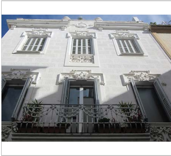
Detall de la façana. 18.1.2016. JM. Pujol
