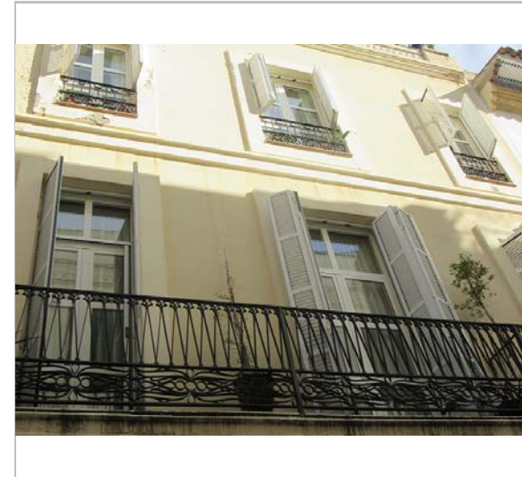
Detall de la façana. 18.1.2016. JM. Pujol
