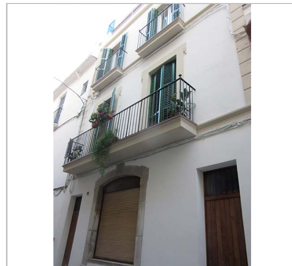
Façana. 28.10.2015. JM. Pujol
