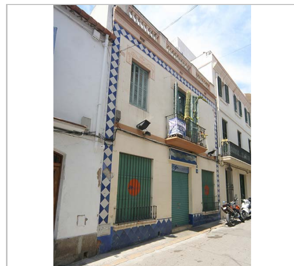
Façana. 3.6.2016. JM. Pujol
