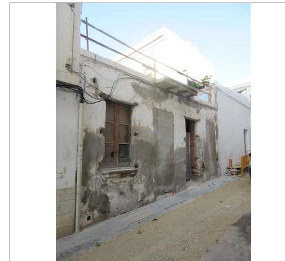
La casa a mig enderrocar. 21.10.2015 JM. Pujol
