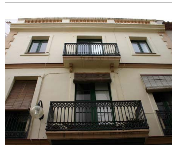
Part superior de l'edifici. 2006. Diputació de Barcelona
