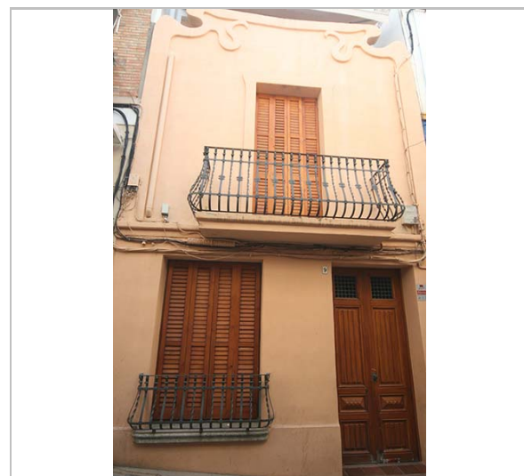
Façana. 16.6.2016. JM. Pujol
