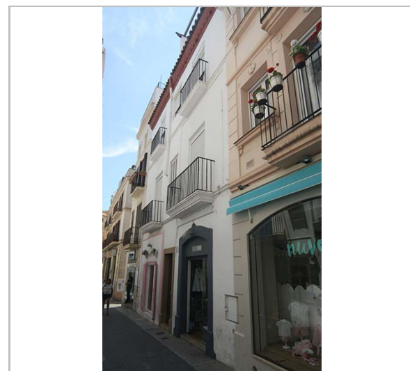
Façana. 3.6.2016. JM. Pujol
