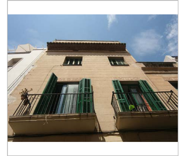
Detall de la part superior de la façana. 3.6.2016. JM. Pujol
