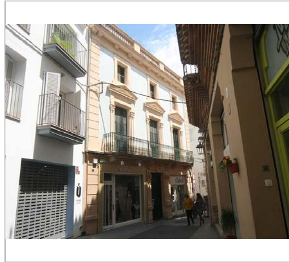
Façana. 3.6.2016. JM. Pujol
