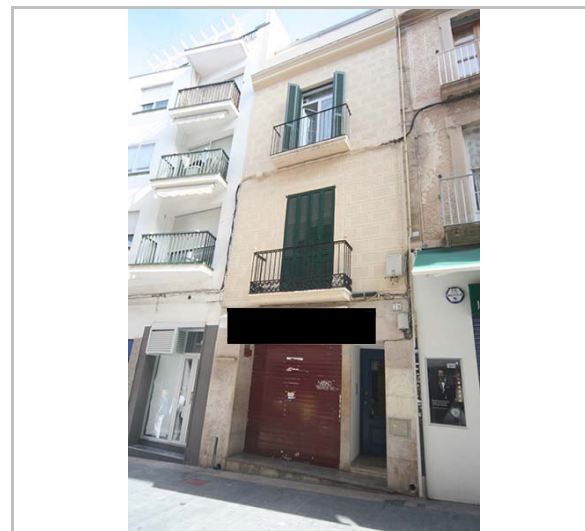
Façana. 16.6.2016. JM. Pujol
