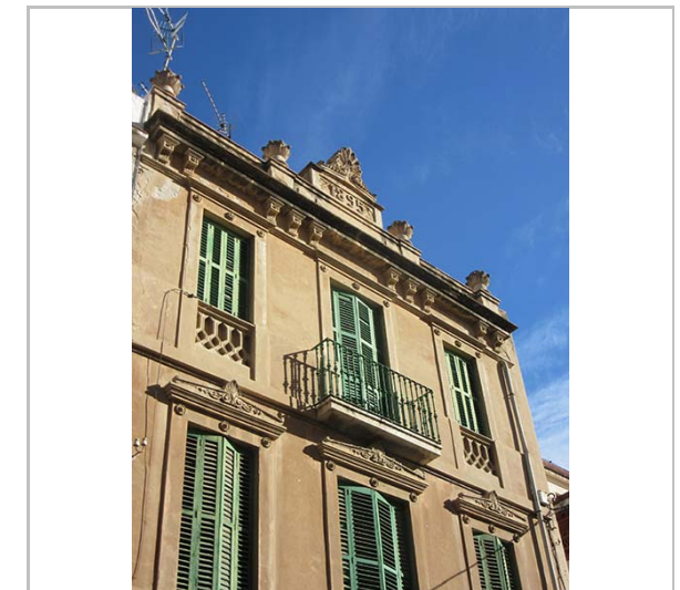
Detall de la façana. 18.1.2016. Ajuntament de Sitges
