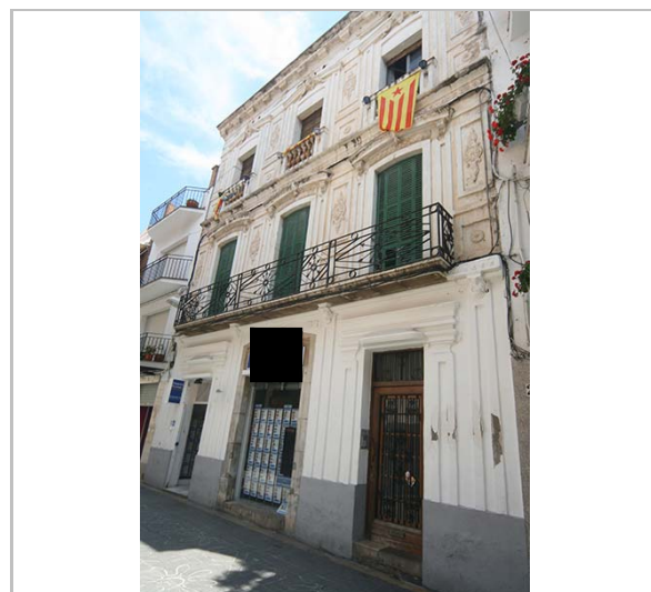
Vista de la façana. 3.6.2016. JM. Pujol
