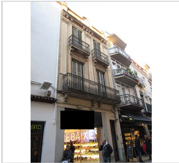
Façana. 22.2.2015. JM. Pujol
