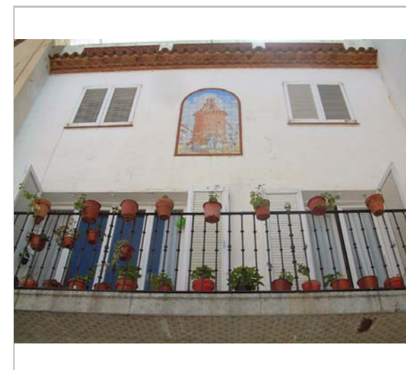
Detall de la façana. 2006. Diputació de Barcelona
