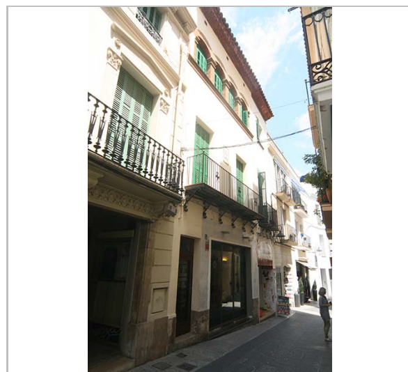
Façana. 3.6.2016 JM. Pujol
