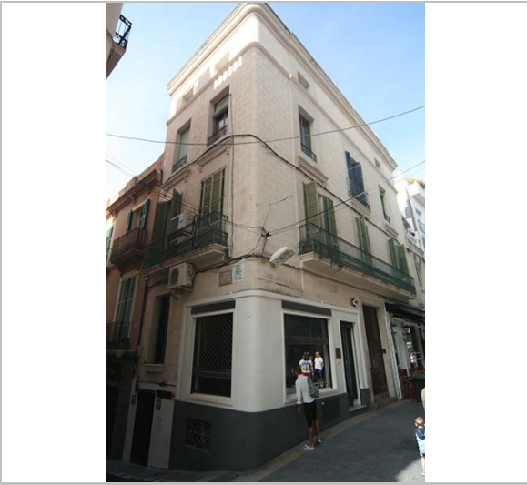
Façana. 16.6.2016. JM. Pujol
