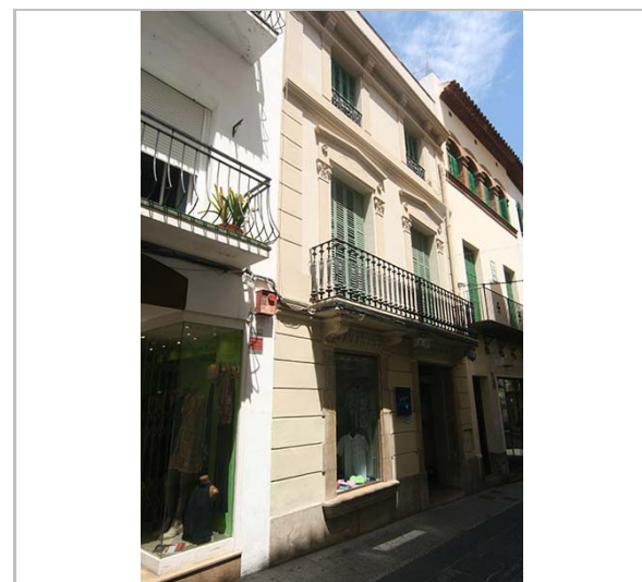
Façana. 3.6.2016. JM. Pujol
