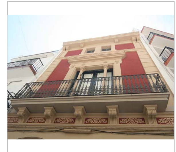
La part superior de l'edifici. 3.6.2016. JM. Pujol
