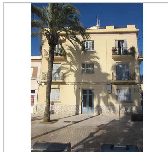
Façana. 17.11.2015. JM. Pujol
