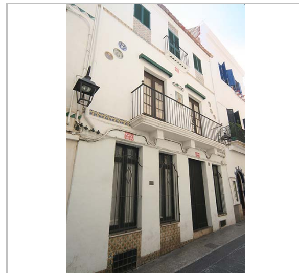
Façana. 3.6.2016. JM. Pujol
