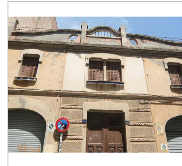
Façana. 3.6.2016. JM. Pujol
