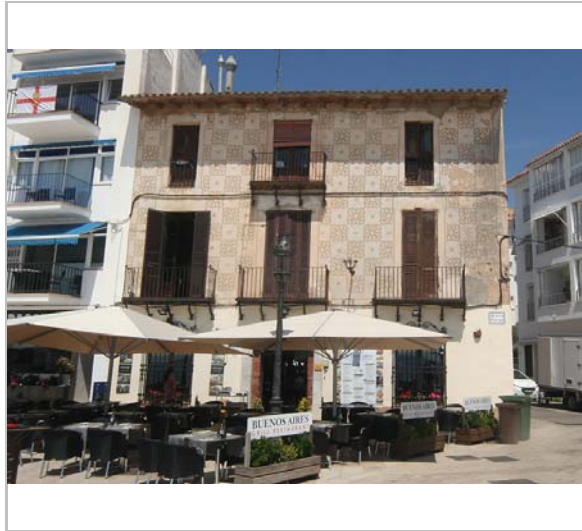
Façana. 3.6.2016. JM. Pujol
