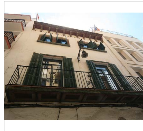
La part superior de l'edifici. 3.6.2016. JM. Pujol
