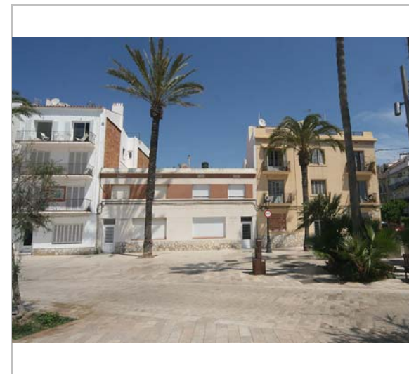
Vista de conjunt. 3.6.2016. JM. Pujol
