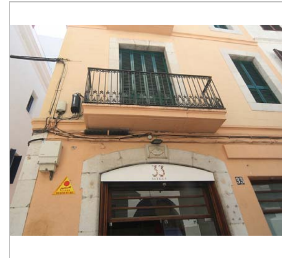
Detall de la façana. 3.6.2016. JM. Pujol
