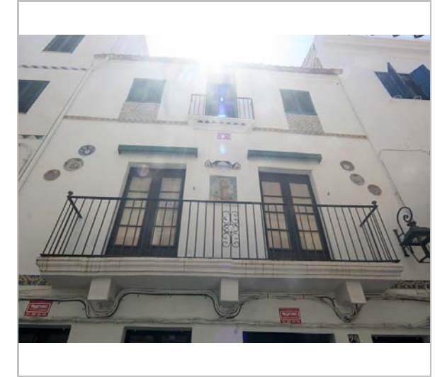
La part superior de l'edifici. 3.6.2016. JM. Pujol
