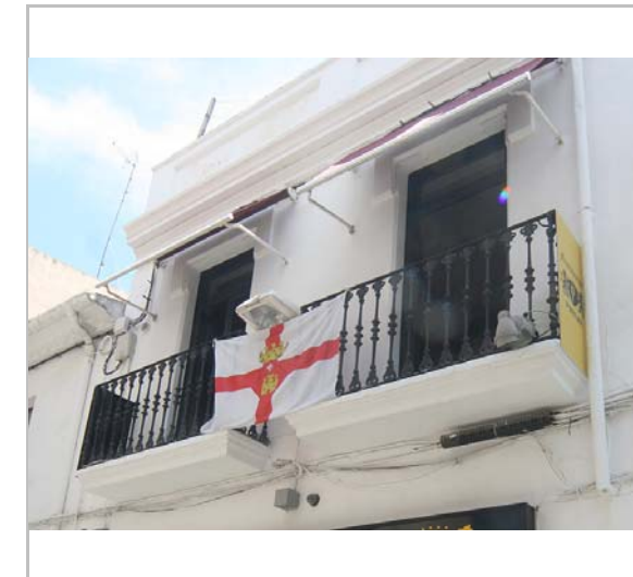
Detall dels balcons. 3.6.2016. JM. Pujol
