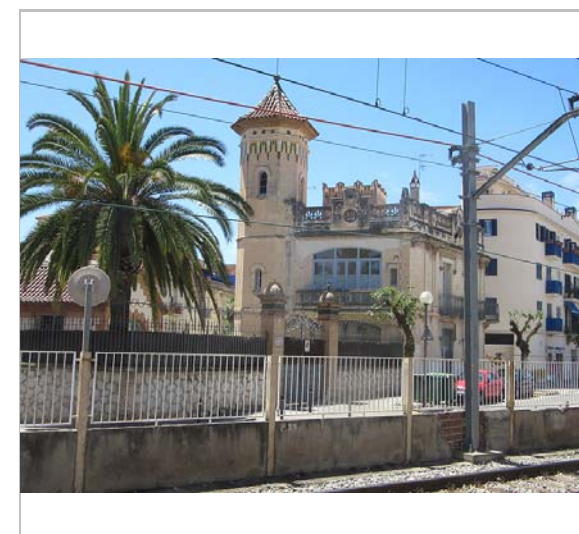
Vista de la casa. 22.5.2016. JM. Pujol
