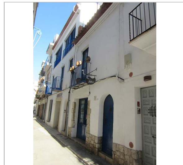
Façana. 17.11.2015. JM. Pujol
