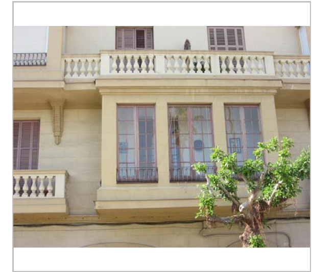
Detall de la façana. 1.7.2016. Sixto Pujol
