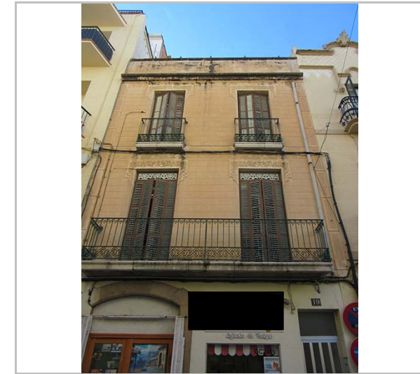
Façana. 2016. JM. Pujol
