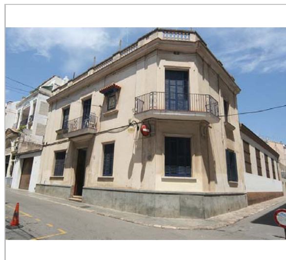
Vista de la casa. 3.6.2016. JM. Pujol
