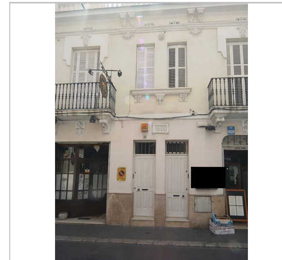
Façana. 3.6.2016. JM. Pujol
