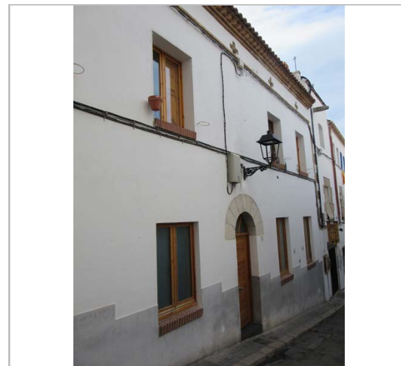
Façana. 29.2.2016 JM. Pujol
