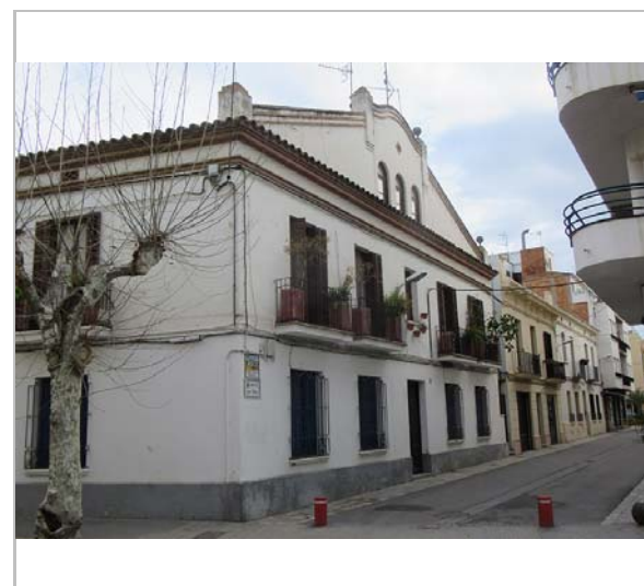
Façana principal. 29.2.2016. JM. Pujol
