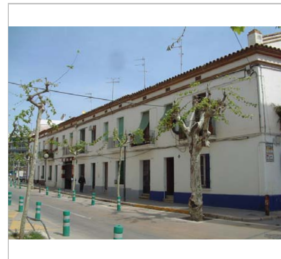
Façana lateral. 2006. Diputació de Barcelona
