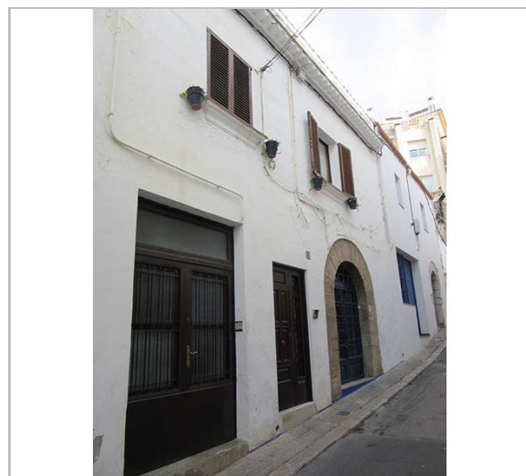
Façana. 29.2.2016 JM. Pujol
