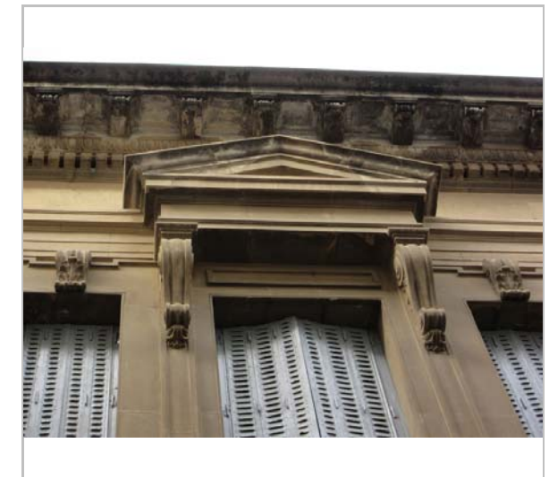
Detall de la façana. 29.2.2016. JM. Pujol
