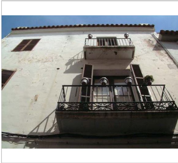
Balcons. 2006. Diputació de Barcelona
