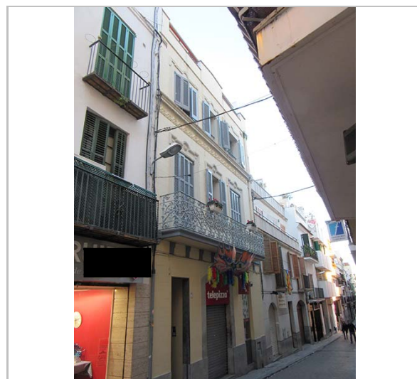
Façana. 22.2.2015. JM. Pujol
