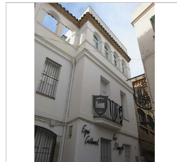
Detall de la façana. 29.2.2016. JM. Pujol
