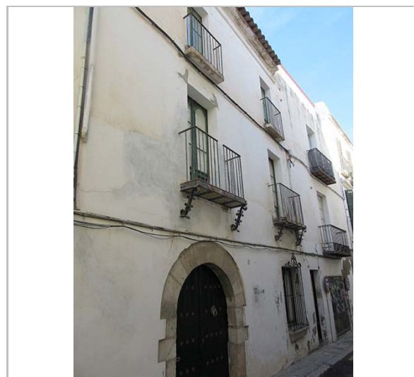
Façana. 2.1.2016. JM. Pujol
