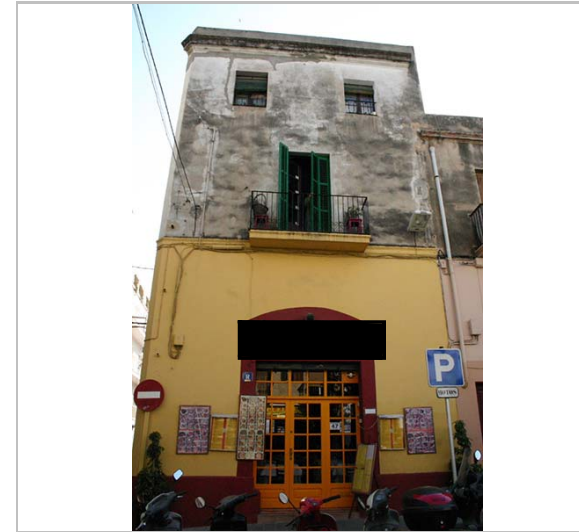
Façana principal. 2006. Diputació de Barcelona
