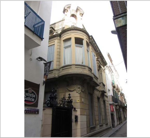
Façana. 29.2.2016. JM. Pujol
