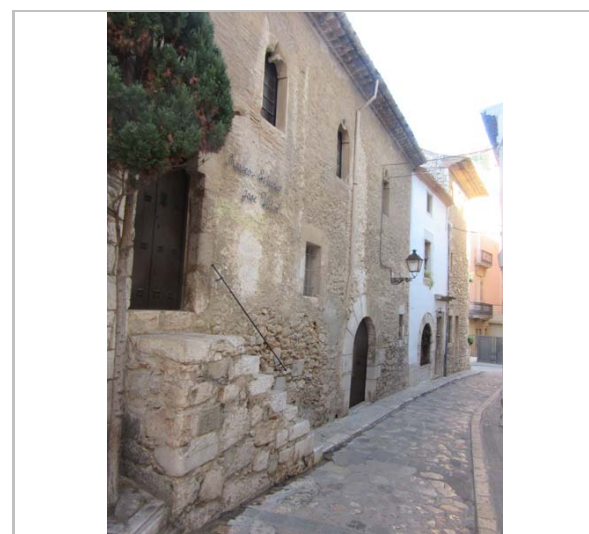
Façana. 17.11.2015. JM. Pujol
