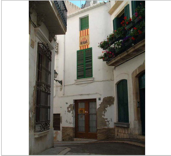
Façana principal. 19.4.2006. Diputació de Barcelona
