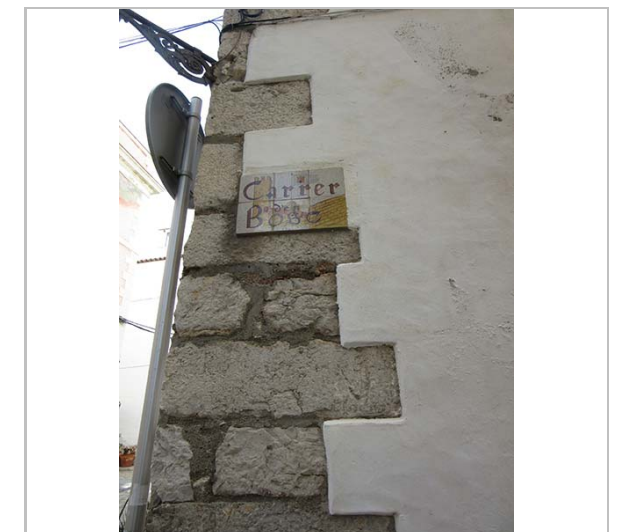
Carreus de pedra de la cantonada. 29.2.2016 JM. Pujol
