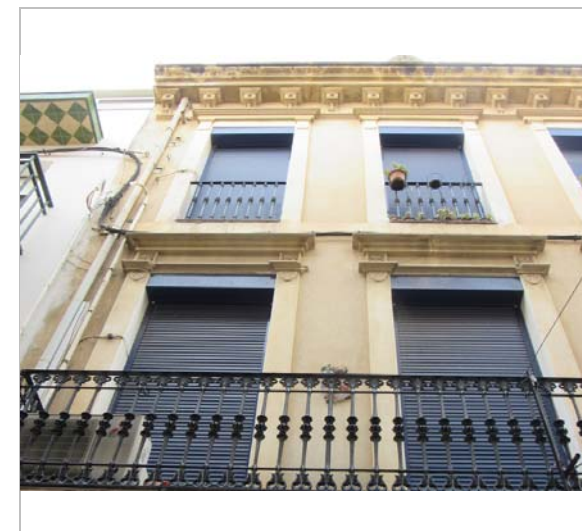
Detall de la façana. 29.2.2016. JM. Pujol
