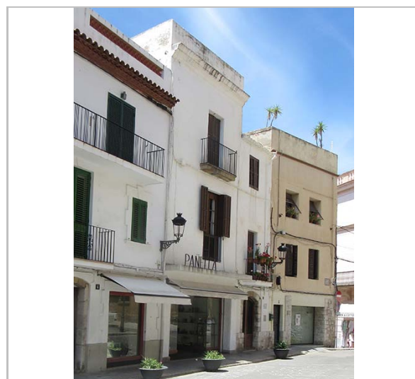
Les façanes. 9.6.2016. JM. Pujol
