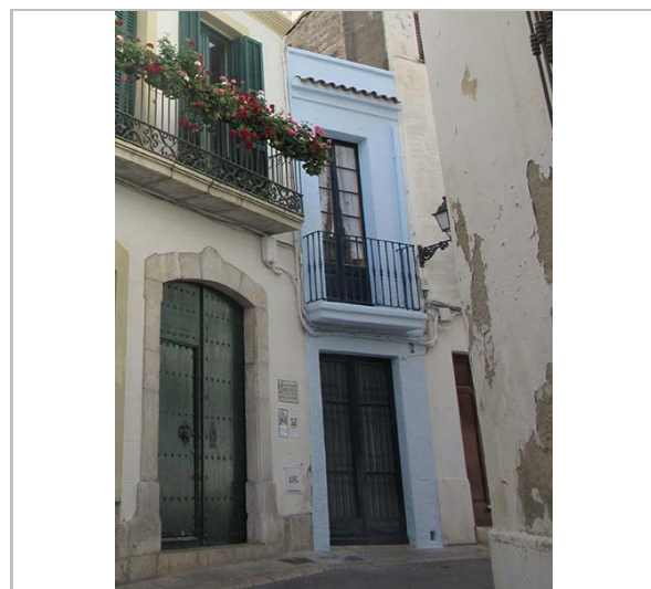
Façana. 16.6.2016. JM. Pujol
