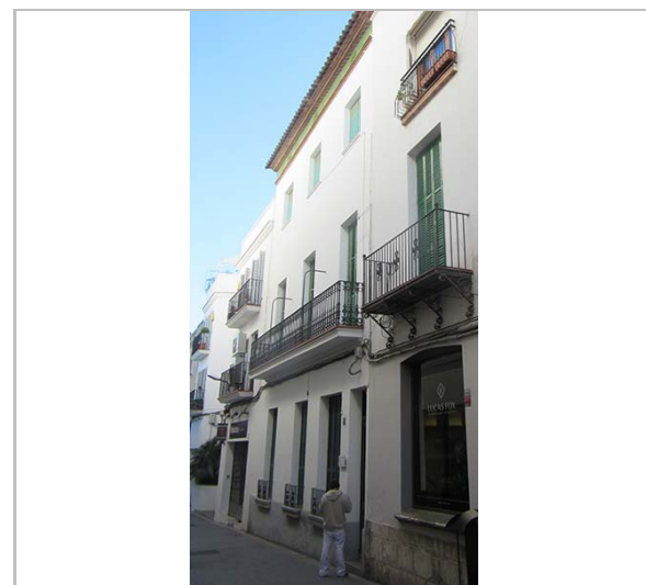
Façana. 17.11.2015. JM. Pujol
