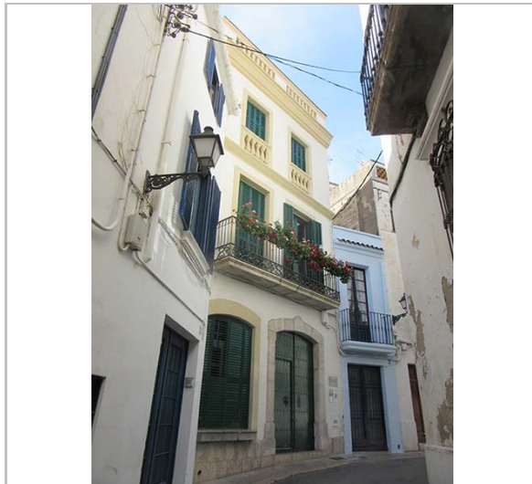
Façana. 16.6.2016. JM. Pujol
