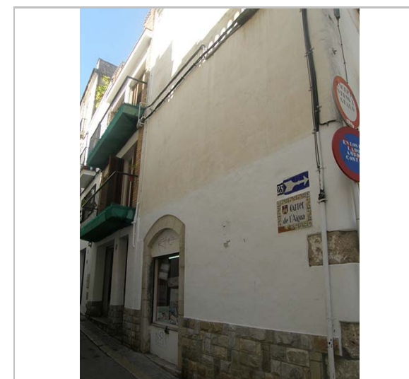
Imatge de l'edifici. 27.6.2016. Foix Marsé
