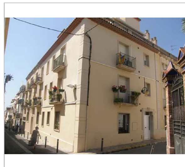
Imatge de l'edifici. 27.6.2016. Foix Marsé
