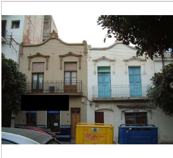
Façanes. 2006. Diputació de Barcelona
