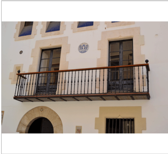
El balcó restaurat. 2014. Ajuntament de Sitges
