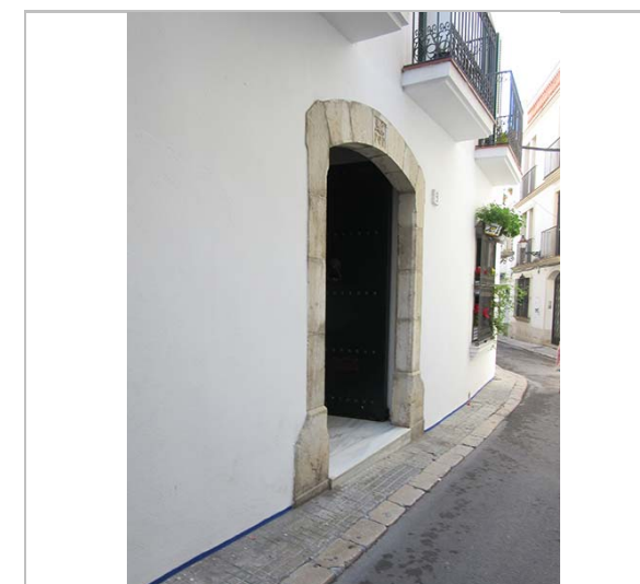
La part baixa de l'edifici. 2.1.2016 JM. Pujol
