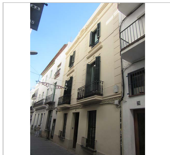
Façana. 17.11.2015. JM. Pujol
