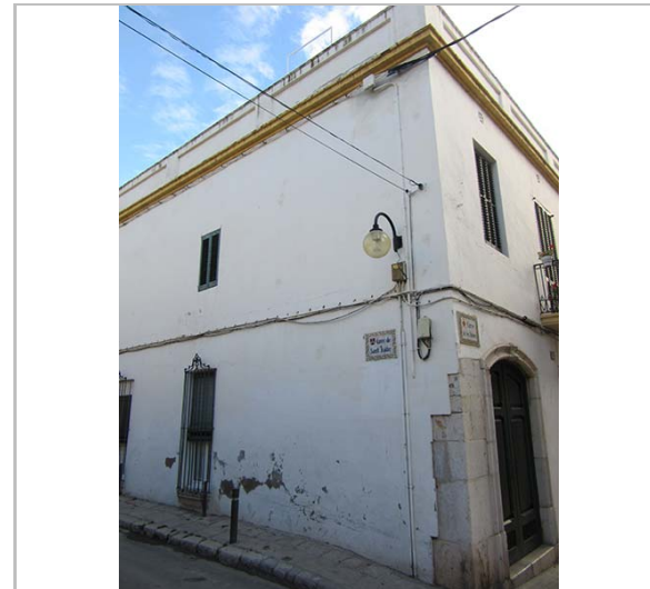
Imatge de l'edifici. 1.1.2016 JM. Pujol
