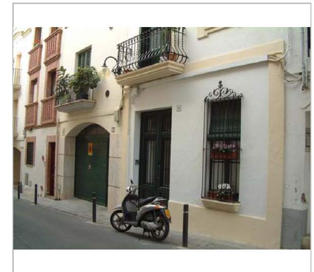
Façanes. 2006. Diputació de Barcelona
