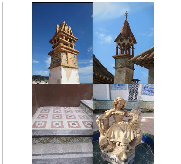
Detalls interiors i exteriors. 2015. JM. Pujol
