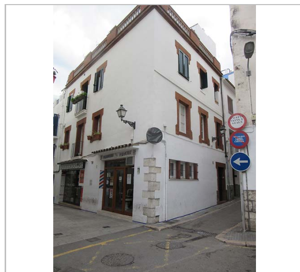
Imatge de l'edifici. 28.10.2015. JM. Pujol
