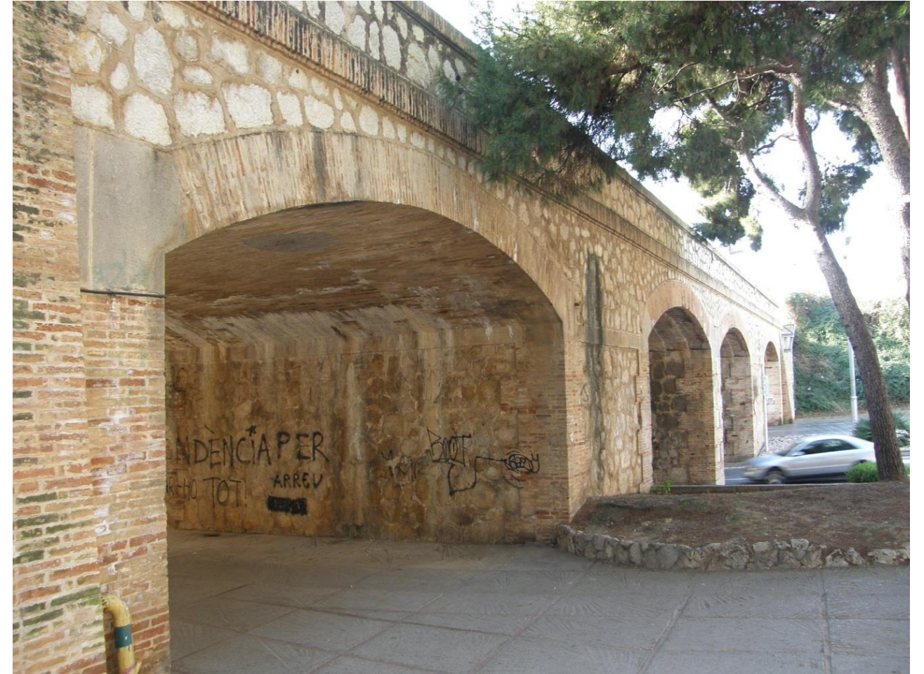
El pont ferroviari de Can Perico fa aprox. 50 m de llarg i 20 m d'ample i suporta quatre línies fèrries, salvant un desnivell de 4,30 m.
