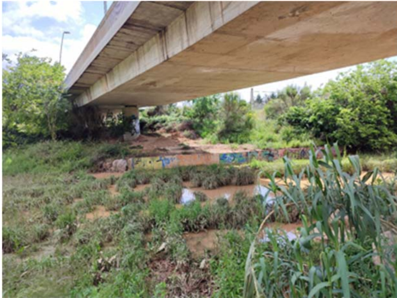
Vista del pas de la riera sota del pont
