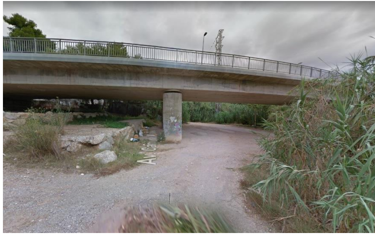
Figura 7. Imatge de la fitxa del pont del passeig de la riera de Ribes (PSE 011E0009), vista dels dos ulls del marge dret des d'aigua avall
