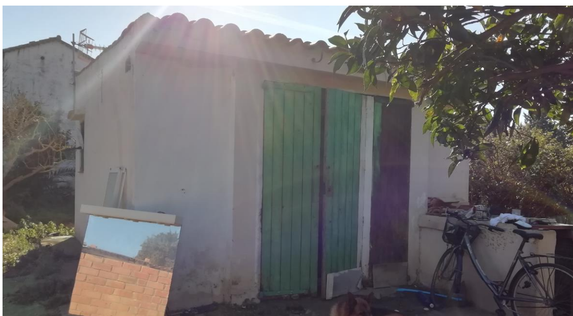
Imatge de la part davantera de la edificació (façana nord)
