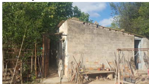
Vista posterior de la zona d'estables. Caseta de WC
