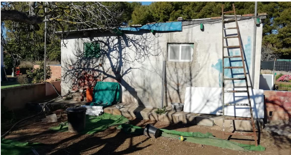
Imatge de la part posterior de la edificació (façana sud)
