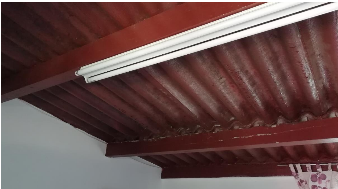
Imatge de l'interior. S'observa el sostre mb les biguetes la coberta de fibrociment.
