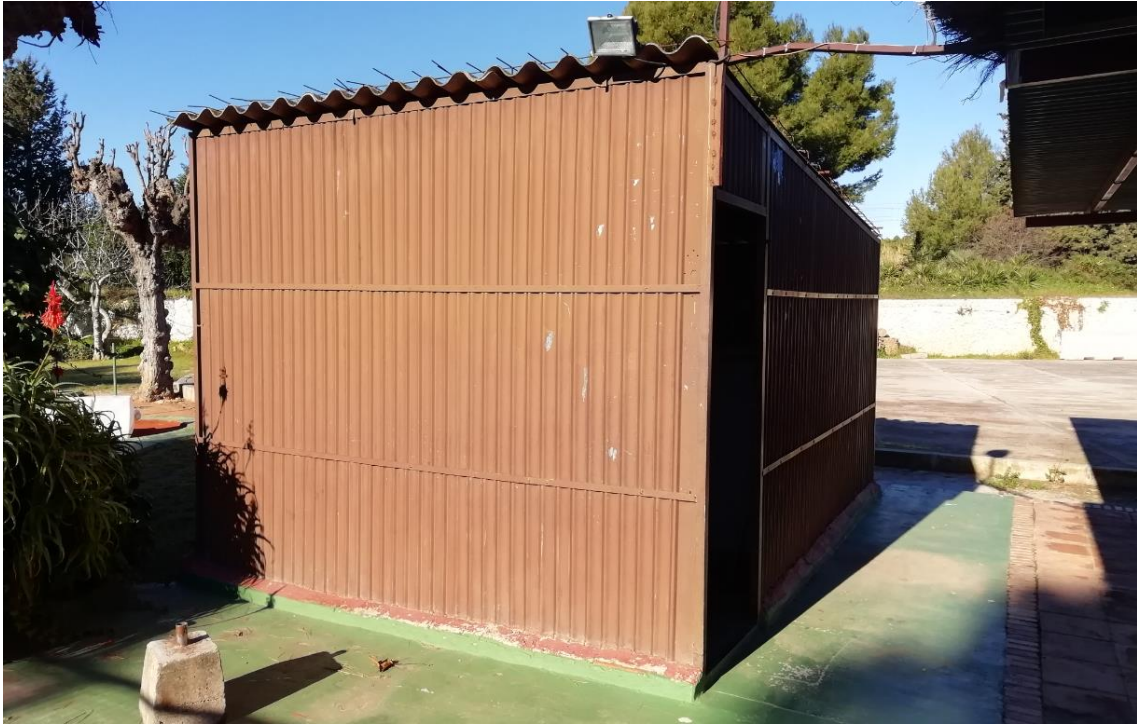
Fotografia de la construcció 3 "Magatzem de Xapa".
