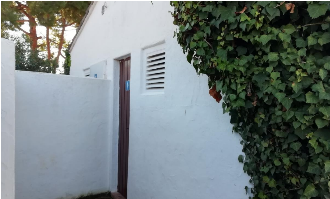
Fotografia de la construcció 2 "Edifici Aseos".
