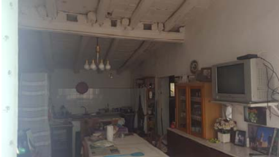
Zona d'estables habilitada com a caseta
