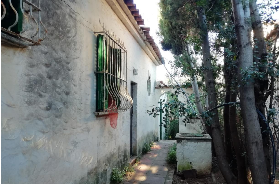
Fotografia d'una de les façanes laterals de l'habitatge.
