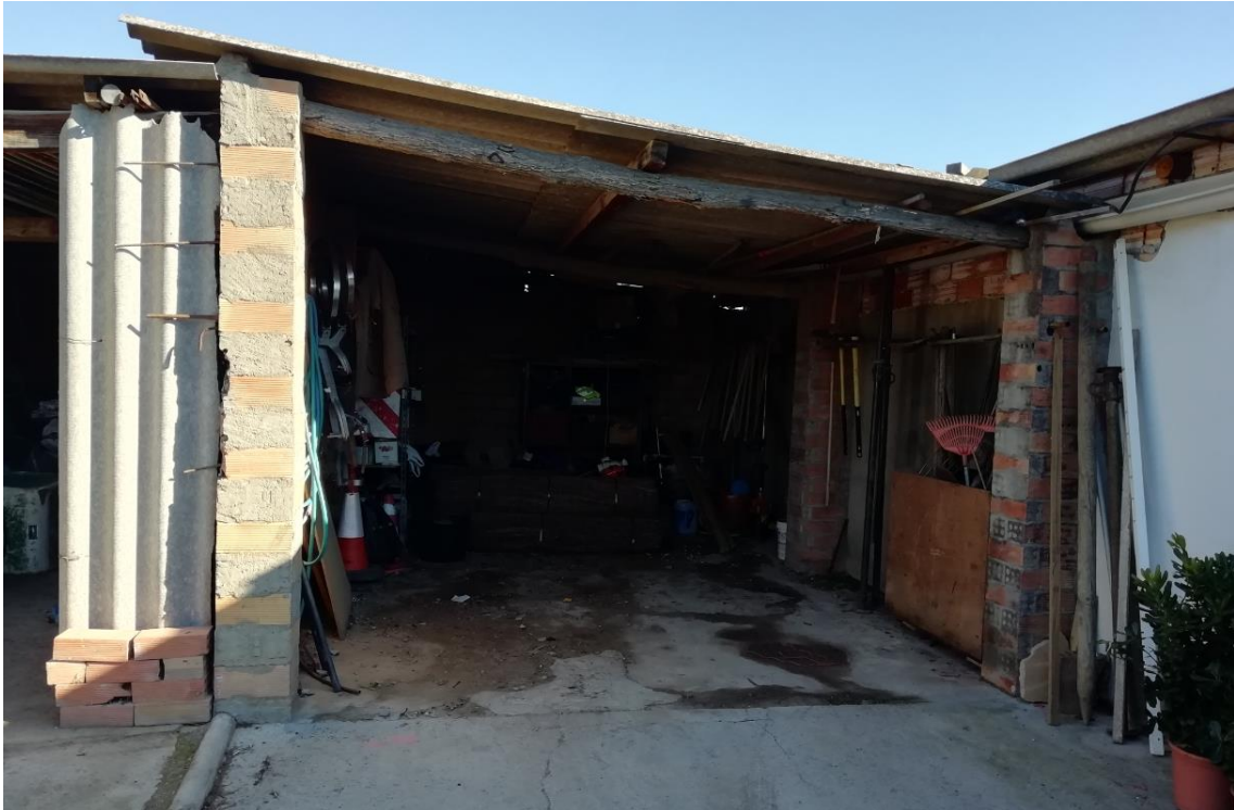
Fotografia de la construcció 3 , el cobert adossat número 2, situat al nord-est del coberta principal.
