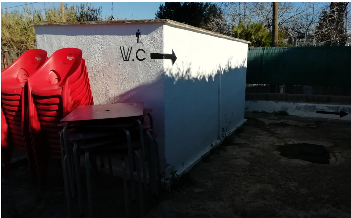
Fotografia de la construcció 4 "Magatzem d'obra".
