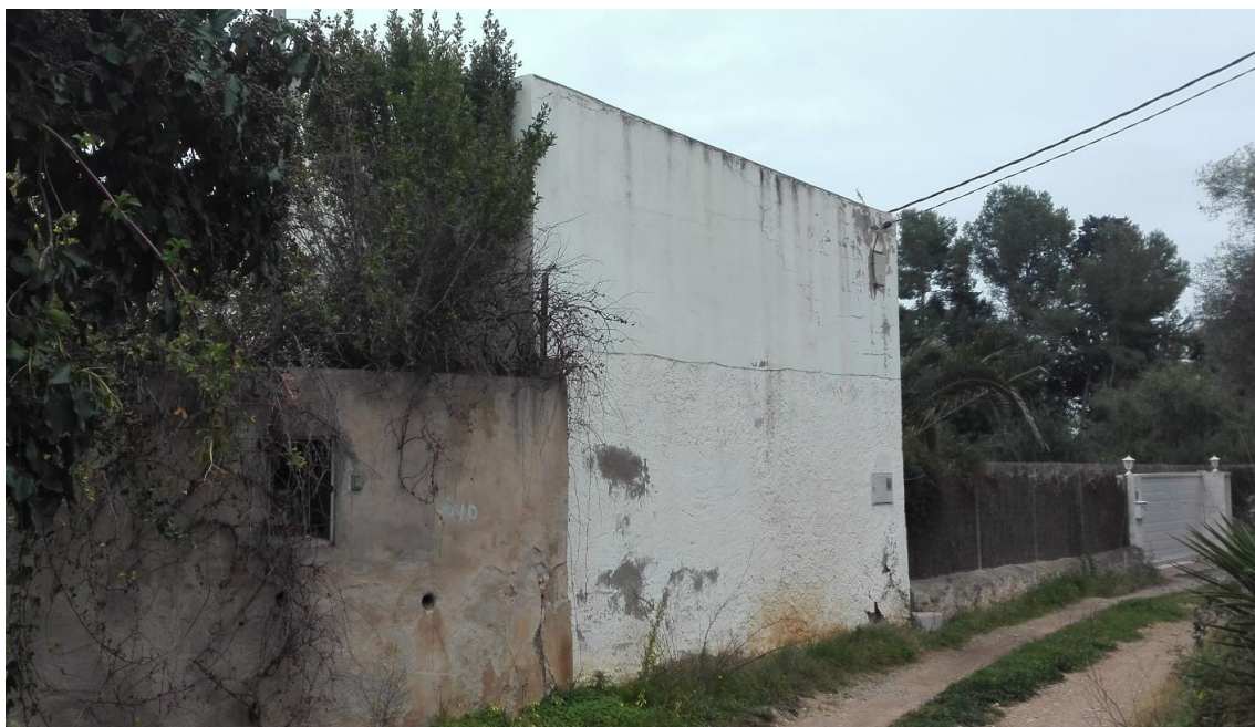
Vista de la façana exterior (construcció blanca) i de la tanca en segon terme. Imatge presa des del nord.
