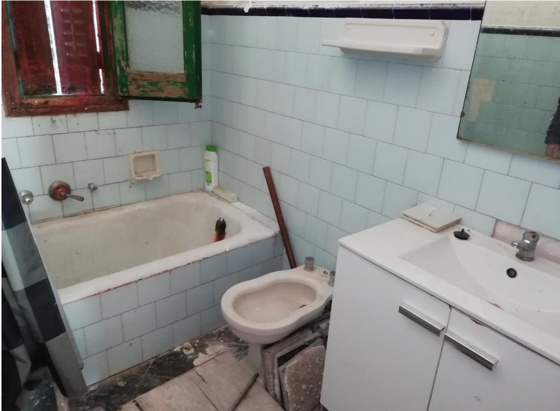
Fotografia d'un dels banys.
