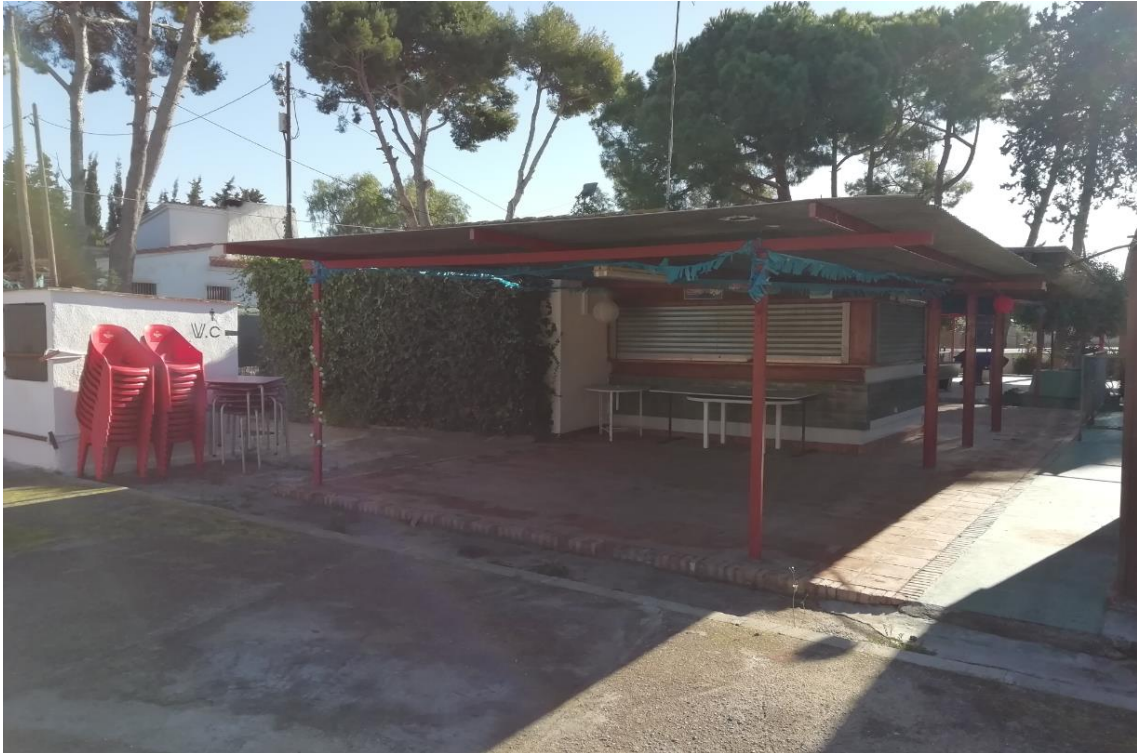
Fotografia de la construcció 5 "Cobert adossat al bar".
