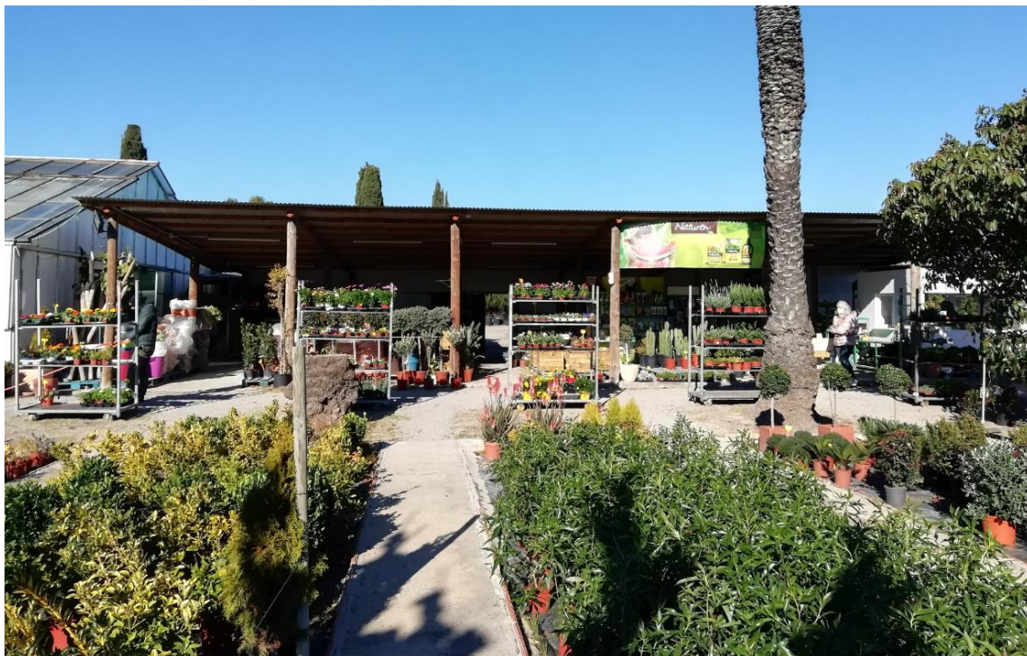
Fotografia de la construcció 1, cobert principal. En primer terme s'observen les jardineres fetes "in situ" i els passos pavimentats.
