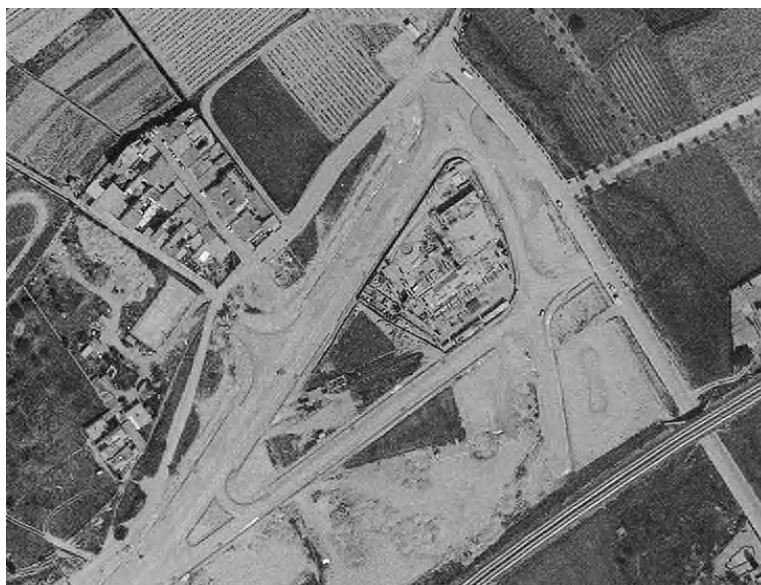
Imatge de les obres d'urbanització que es realitzaven a l'àmbit (1994)
