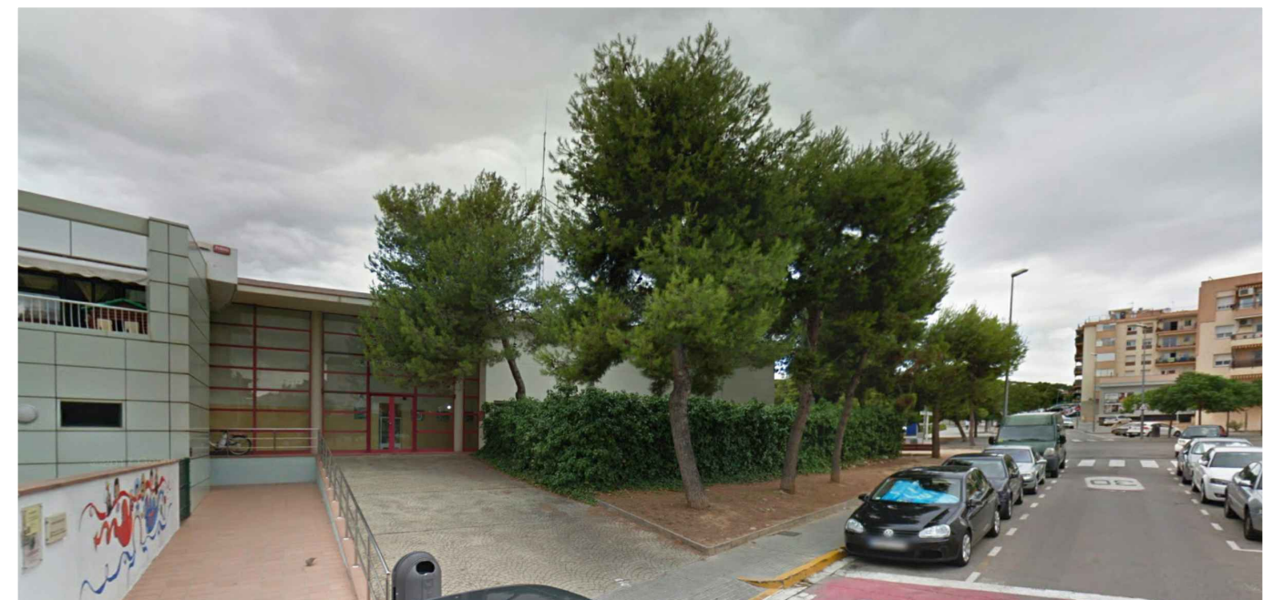
2. Entrada principal del Parc de Bombers, vista des del Carrer Samuel Barrachina.
