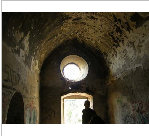
Vista interior. 26.11.2013. Jaume Marsé Ferrer
