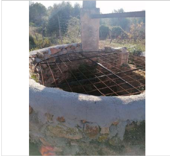
Vista del pou. 2020. Esteve Mestres Roca
