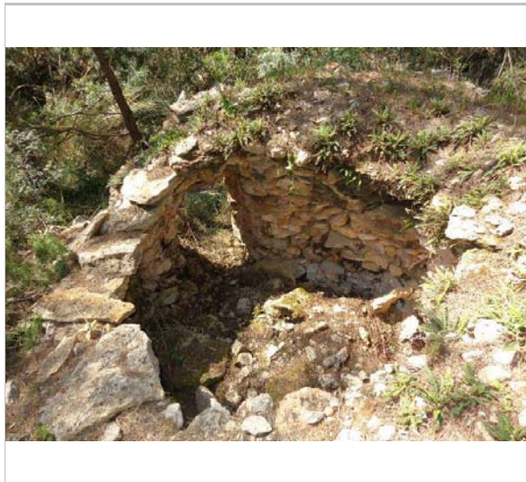
Vista de la barraca. 14.4.2014 Pau Tena
