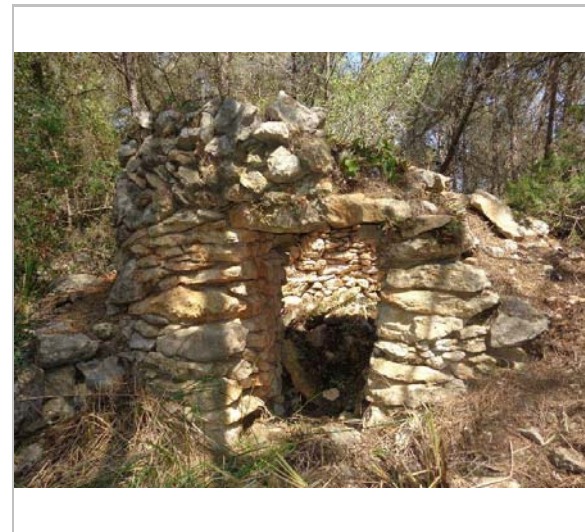
Vista de la barraca. 14.4.2014 Pau Tena
