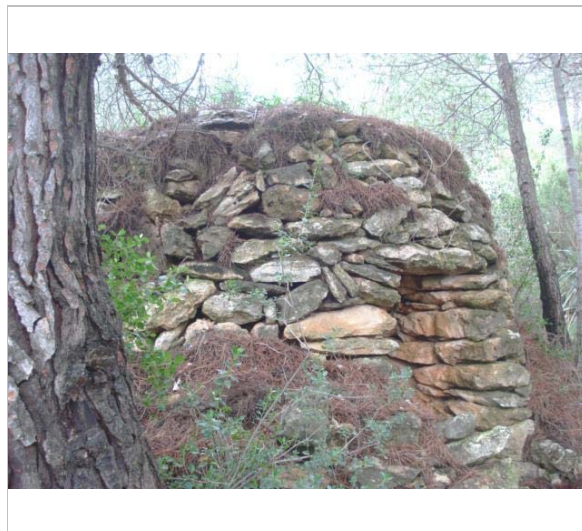
Vista lateral de la barraca. 23.2.2013 Isabel Balcells
