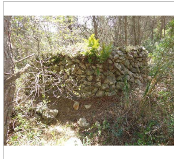
Vista de la barraca. 14.4.2014 Pau Tena
