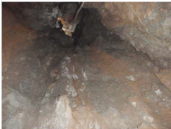
Vista de l'interior. 2012. Joan Montoya
