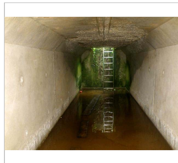
El túnel per sota l'autopista. 2013. espeleoindex
