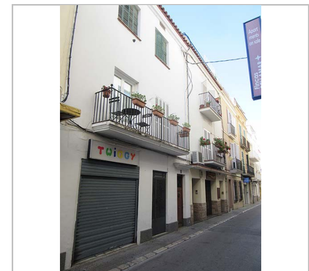
Vista del carrer de Sant Bartomeu. 18.1.2016. JM. Pujol
