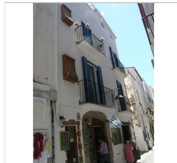
Vista al carrer Major. 22.6.2016. JM. Pujol
