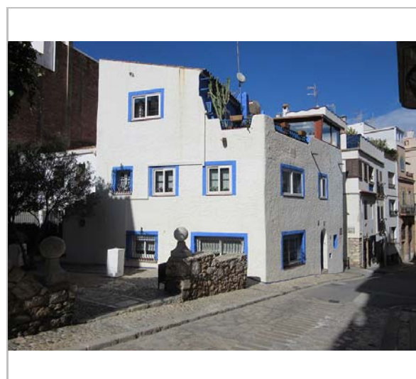
Vista de la casa. 3.3.2015 JM. Pujol
