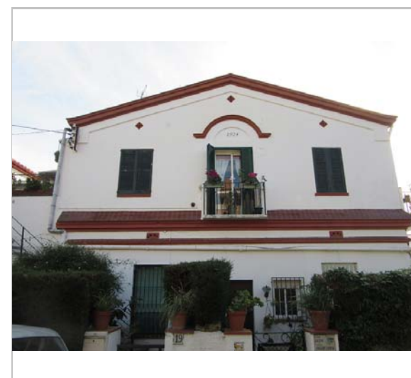
Vista de la casa. 2.1.2016 JM. Pujol
