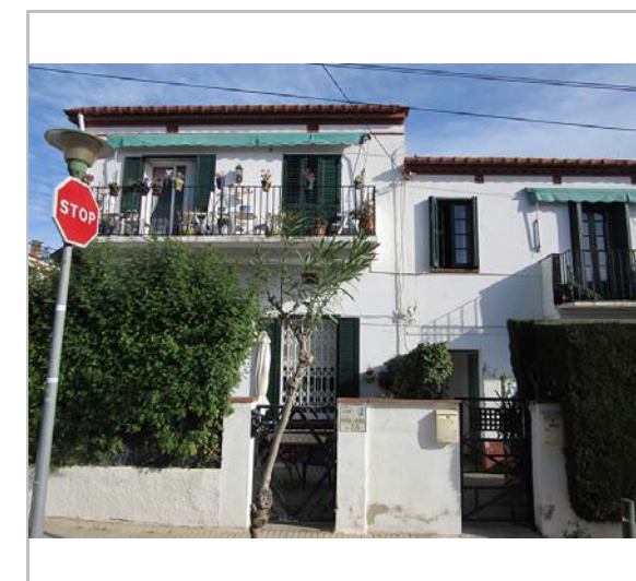
Vista de la casa. 2.1.2016 JM. Pujol
