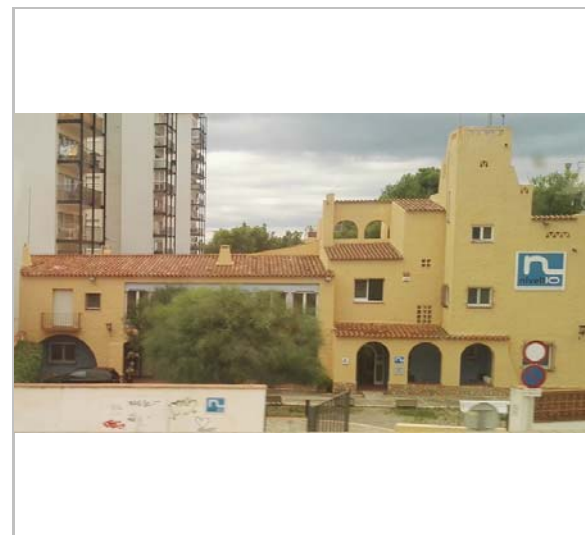
Façana Nord. 29.9.2016. JM. Pujol
