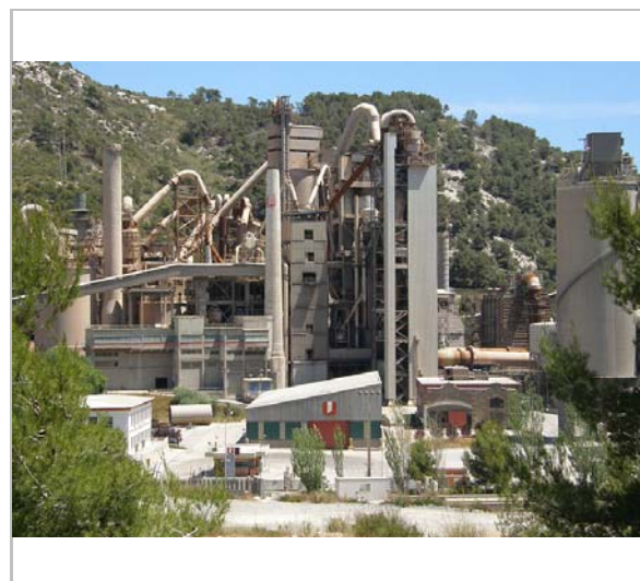
Vista de la fàbrica. 23.5.2014 Jaume Marsé
