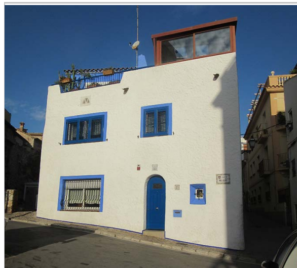
Vista de la casa. 21.10.2015 JM. Pujol
