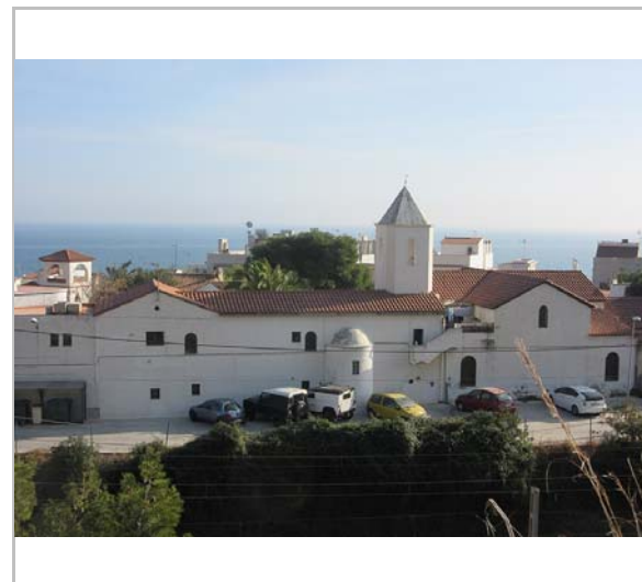
Façana nord. 26.1.2016 JM. Pujol
