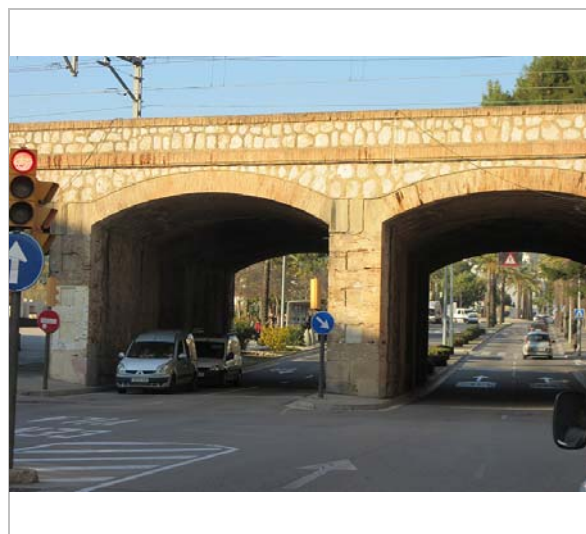
Vista el pont, banda sud. 14.1.2015 JM. Pujol
