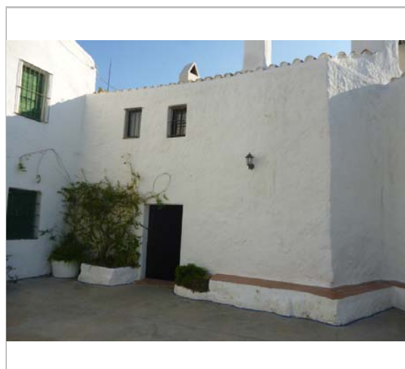
Vista de l'entrada. 26.11.2013 Sixto Pujol
