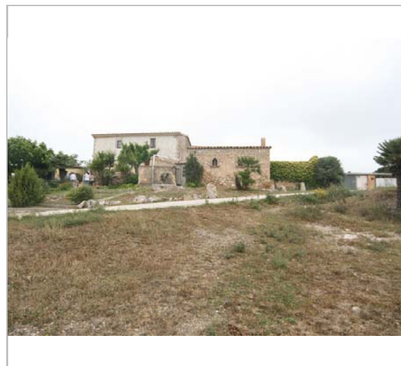
Façana Principal. 17.7.2014. Sixto Pujol
