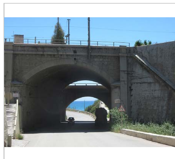
Viaducte de Vallcarca. 30.5.2016. JM. Pujol
