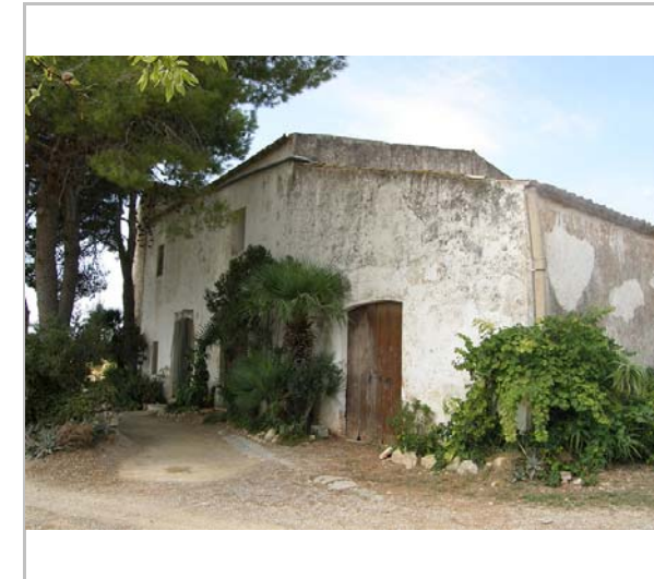
Edifici annex a la Torre. 30.8.2013 Jaume Marsé
