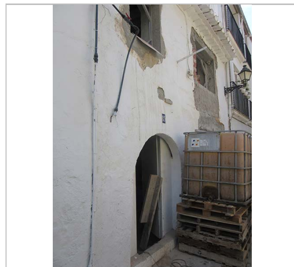
El núm. 15, en obres. 1.7.2016. Sixto Pujol
