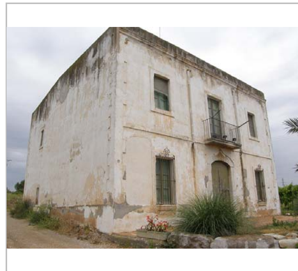
Edifici aïllat de Ca l'Amell. 30.5.2014. Jaume Marsé
