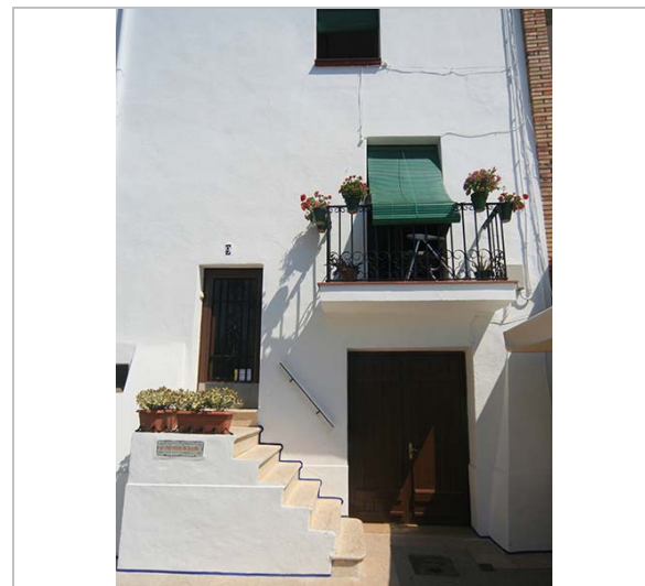
Detall de la façana. 27.6.2016. Sixto Pujol
