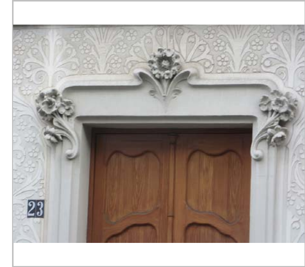
Detall de la façana. 9.12.2015. JM. Pujol
