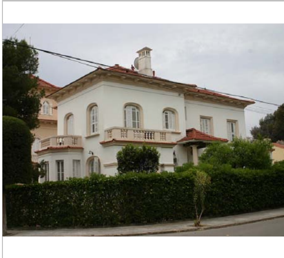
Façana principal. 2006. Diputació de Barcelona
