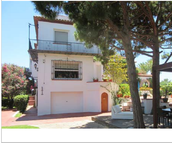
Vista lateral de la casa. 22.6.2016. Sixto Pujol
