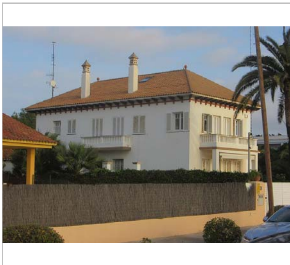
Vista de la casa. 9.12.2015. JM. Pujol
