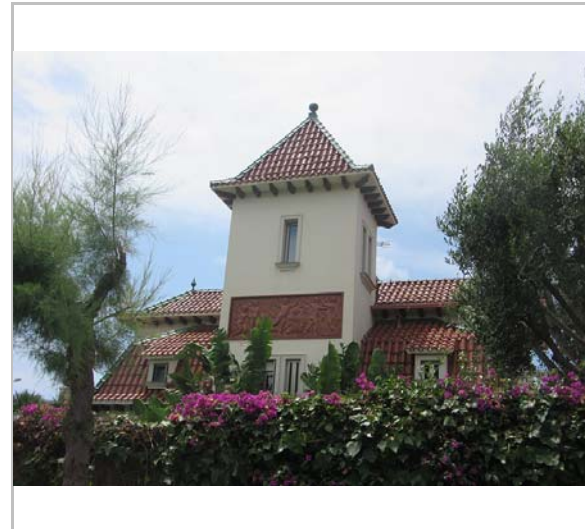
Vista de la casa. 3.7.2016. JM. Pujol
