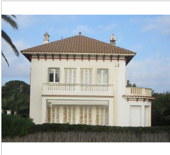
Façana principal. 9.12.2015. JM. Pujol
