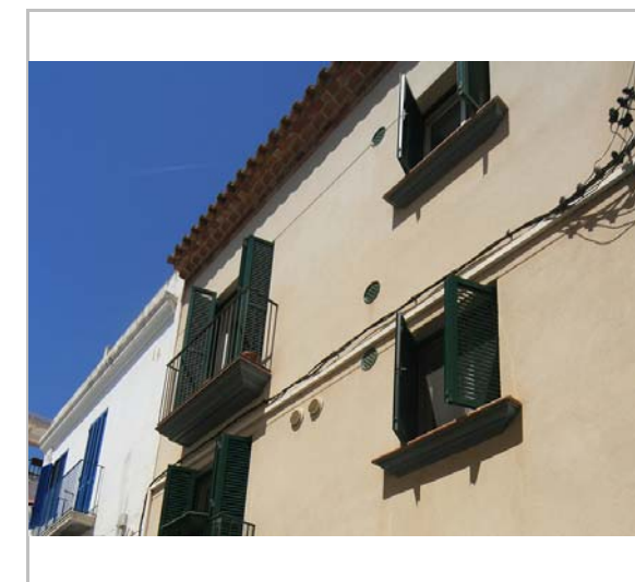
Detall de la façana. 27.6.2016. Sixto Pujol
