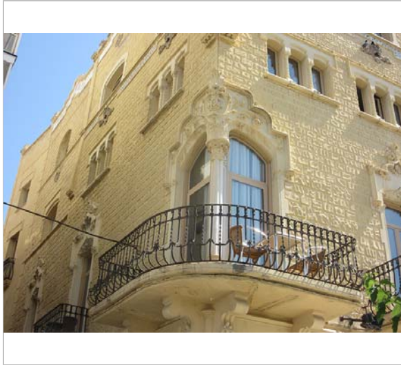
Detall de la façana. 27.6.2016. Sixto Pujol
