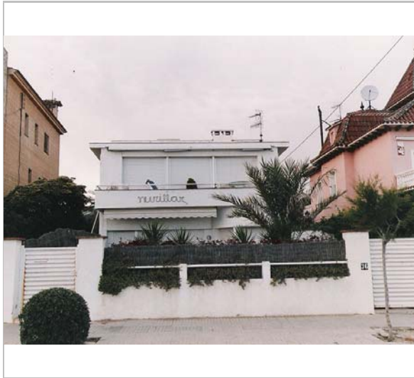
Vista de la construcció original. Criticart
