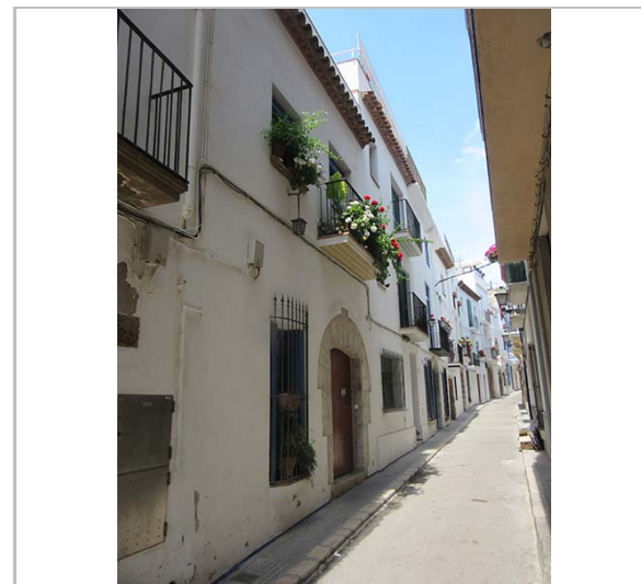
Façana. 9.6.2016 JM. Pujol
