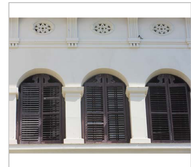
Detall de la façana. 27.6.2016 Sixto Pujol
