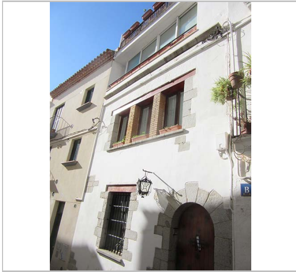
Detall de la façana. 17.11.2015. JM. Pujol
