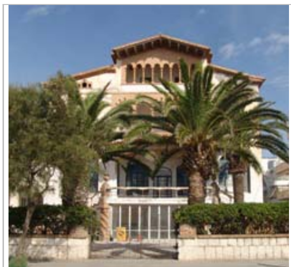
Façana principal. 2014. JM. Pujol
