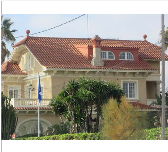
Vista de la casa. 11.12.2015. JM. Pujol
