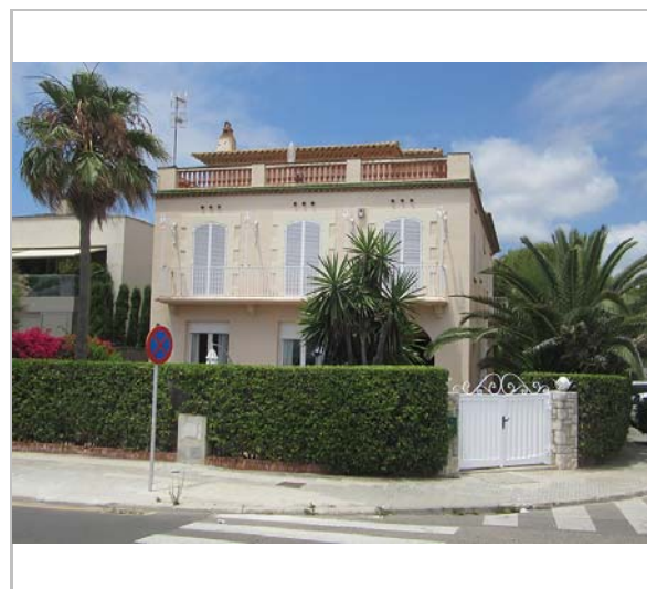
Vista de la casa. 3.7.2016. JM. Pujol
