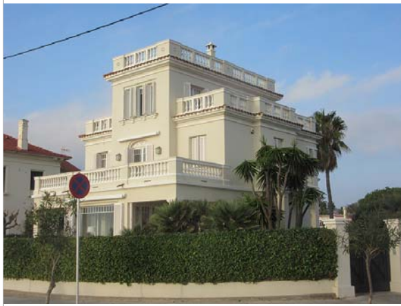
Vista de la casa. 9.12.2015. JM. Pujol
