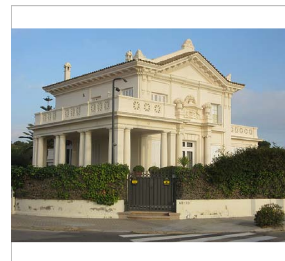
Vista de la casa. 9.12.2015. JM. Pujol
