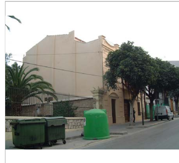
Façana lateral. 19.4.2006. Diputació de Barcelona
