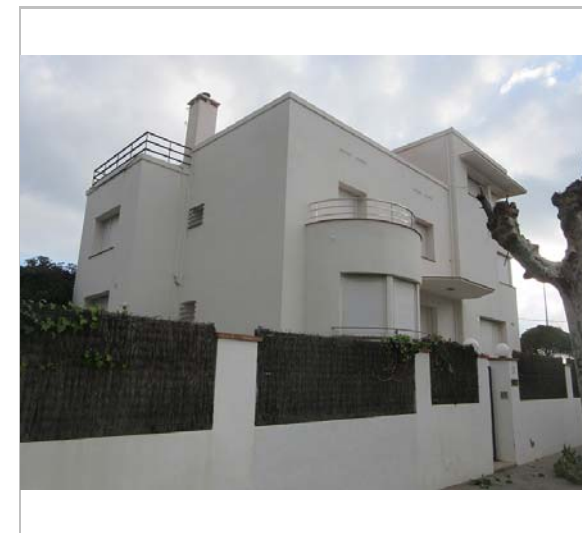
Vista de la casa. 9.12.2015. JM. Pujol
