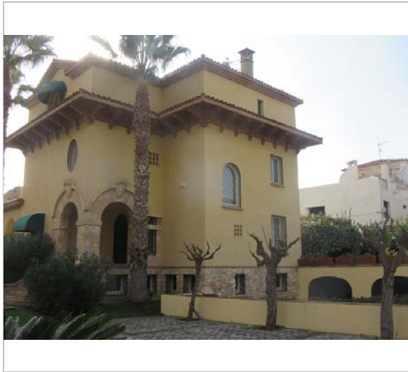
Vista de la casa. 11.12.2015. JM. Pujol
