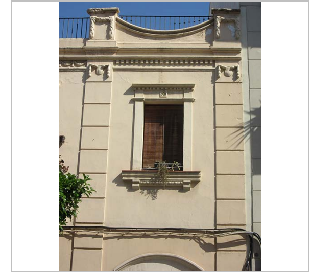
Detall de la façana. 1.7.2016. Sixto Pujol
