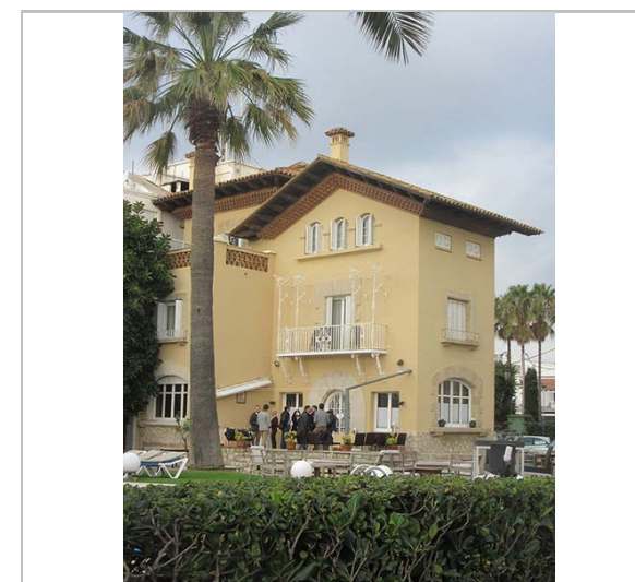
Vista de la casa. 9.12.2015. JM. Pujol
