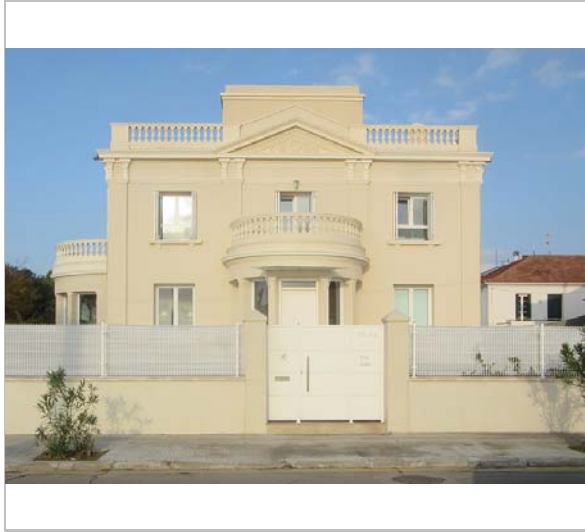
Façana principal. 9.12.2015. JM. Pujol
