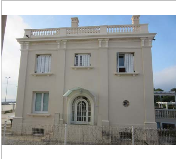
Façana lateral. 9.12.2015. JM. Pujol
