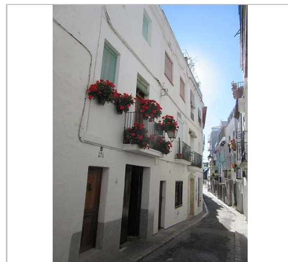
Façana. 17.11.2015. JM. Pujol
