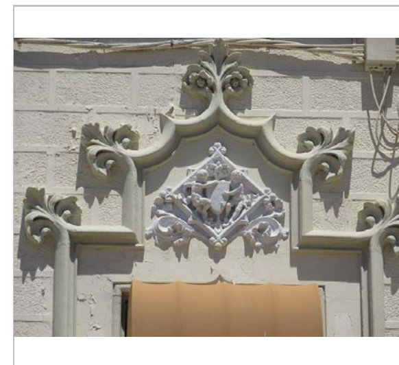
Detall de la façana. 23.6.2016. Sixto Pujol
