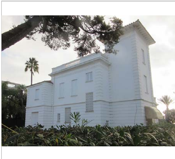
Vista de la casa. 9.12.2015. JM. Pujol
