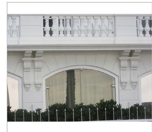
Detall de la façana principal. 9.12.2015. Diputació de Barcelona
