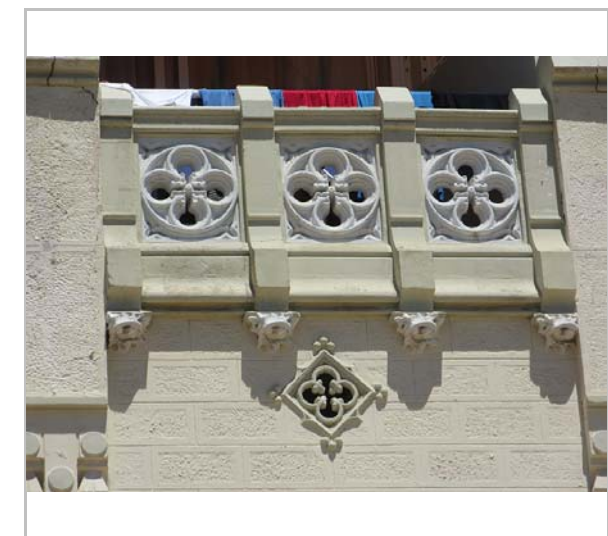
Detall de la façana. 23.6.2016. Sixto Pujol
