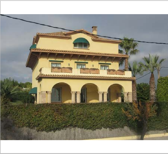
Vista de la casa. 11.12.2015. JM. Pujol
