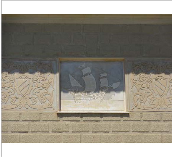
Detall de la façana. 22.6.2016. Sixto Pujol
