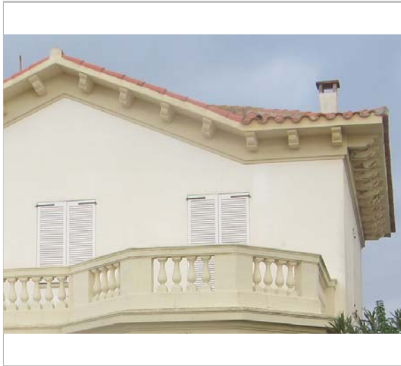
Detall de la façana. 9.12.2015. JM. Pujol
