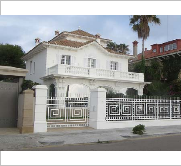
Vista de la casa. 9.12.2015. JM. Pujol
