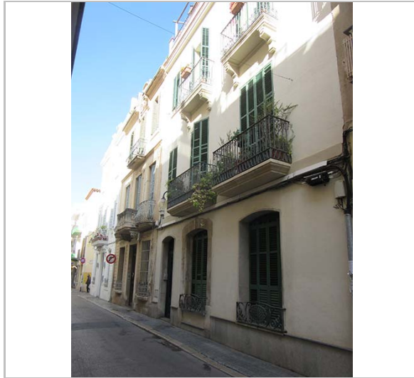
Façana. 18.1.2016. JM. Pujol
