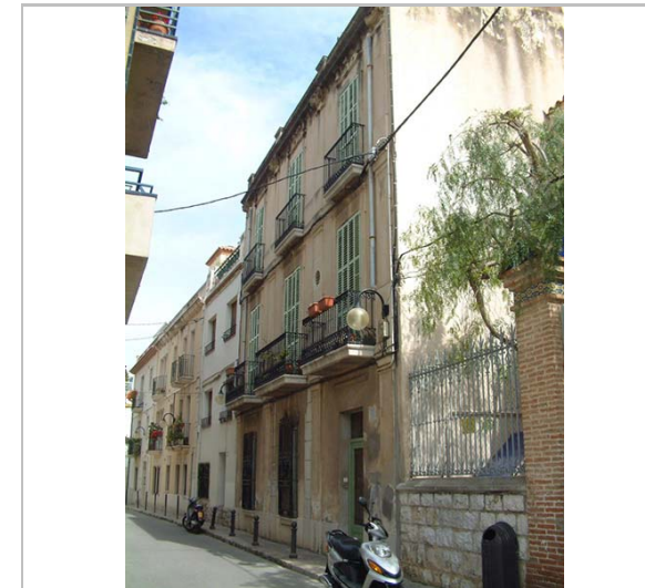
Vista de la façana. 24.4.2006. Diputació de Barcelona
