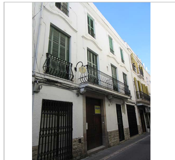
Façana. 18.1.2016. JM. Pujol
