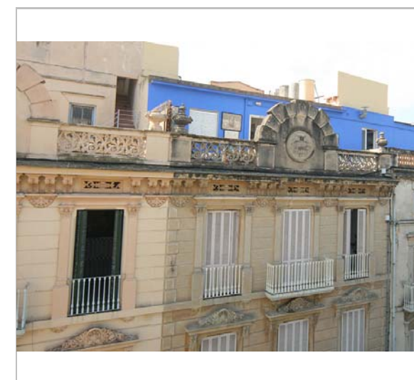
Detall del coronament de les façanes. 5.8.2014.
