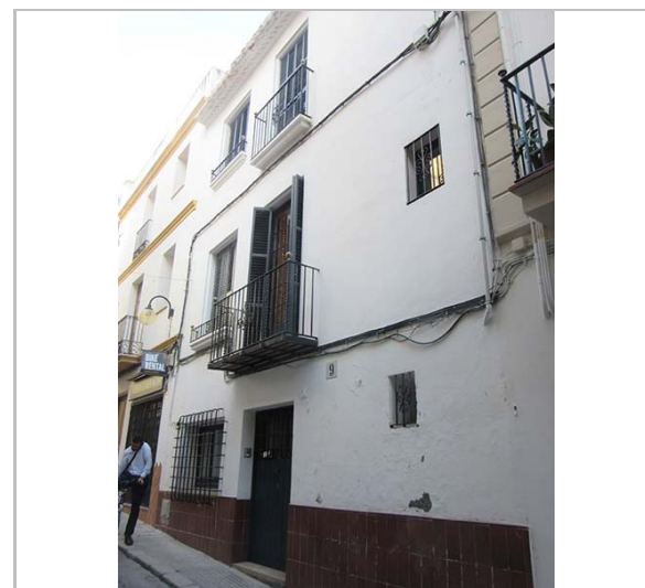
Façana. 28.19.2015. JM. Pujol
