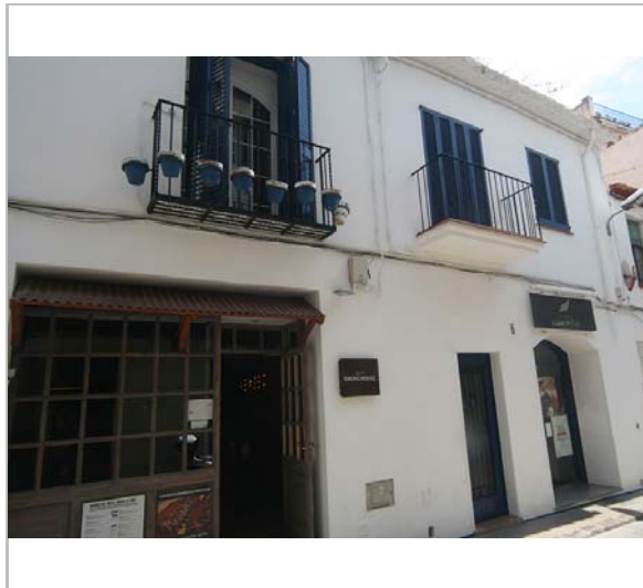
Façana. 3.6.2016 JM. Pujol
