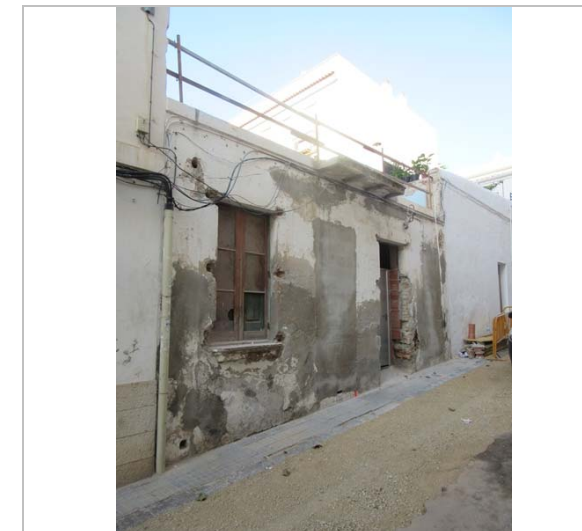
La casa a mig enderrocar. 21.10.2015 JM. Pujol
