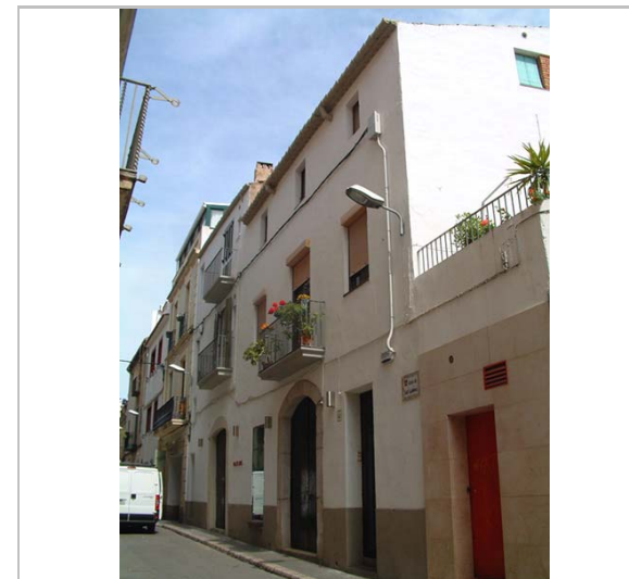
Vista de la façana. 24.4.2006. Diputació de Barcelona
