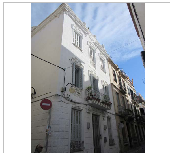
Façana. 18.1.2016. JM. Pujol
