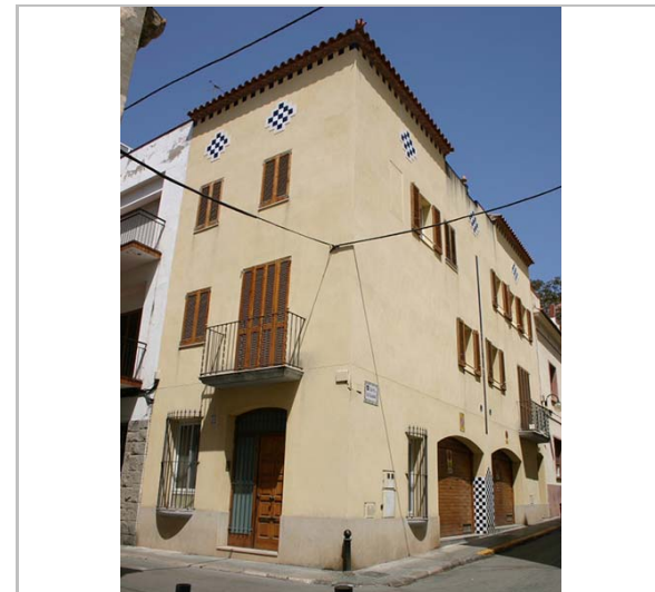
Vista de l'edifici. 2006. Diputació de Barcelona
