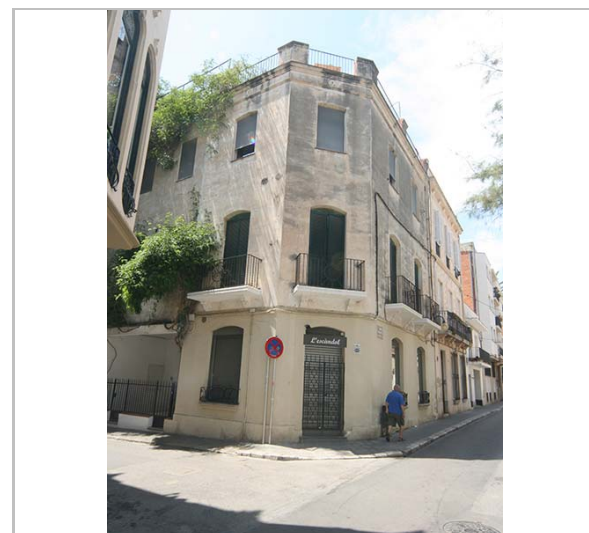
Façana. 3.6.2016. JM. Pujol
