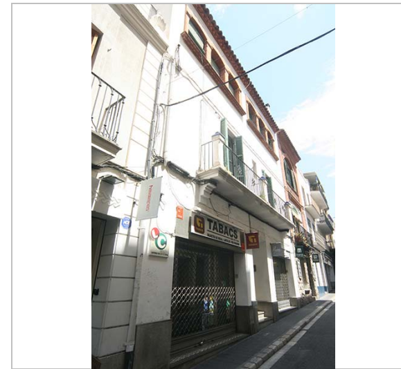
Vista de la façana. 3.6.2016.
