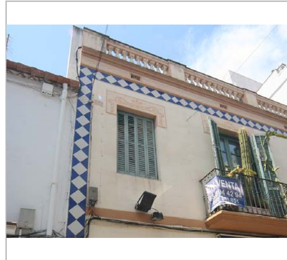
Detall de la façana. 3.6.2016. JM. Pujol
