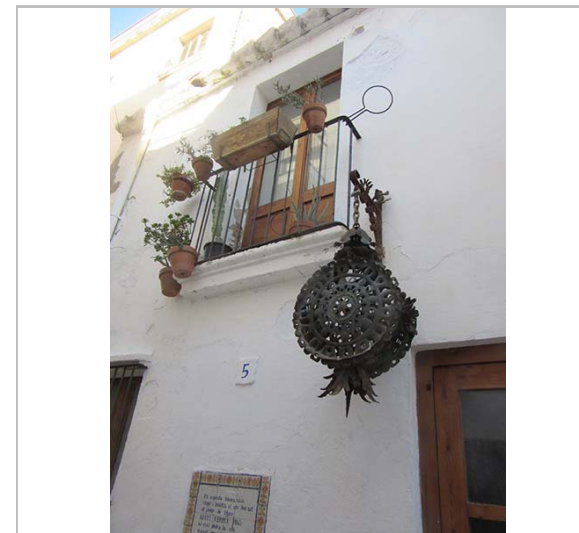
Detall de la façana. 17.11.2015.
