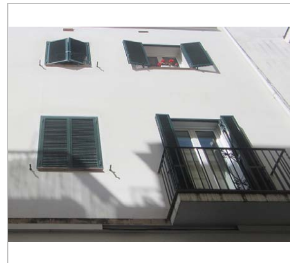
Detall de la façana. 1.7.2016. Sixto Pujol
