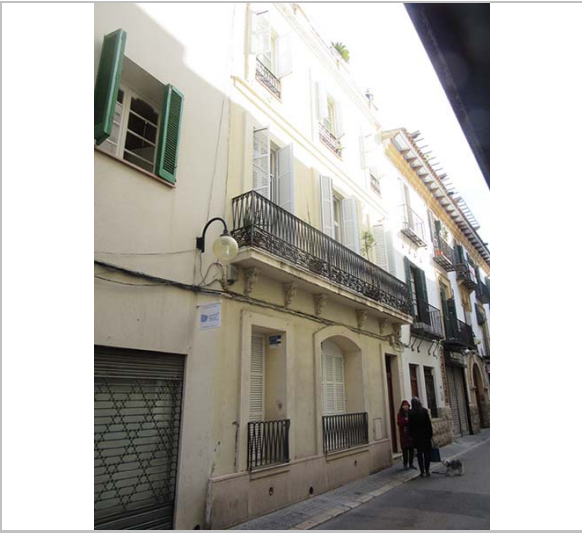
Façana. 18.1.2016. JM. Pujol
