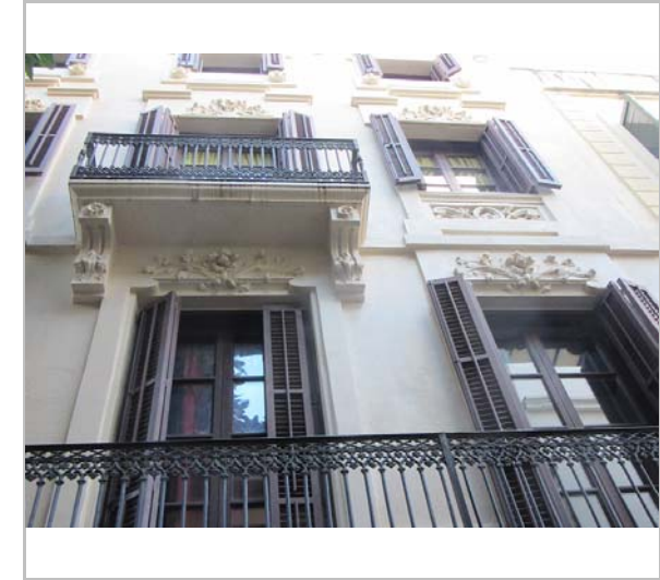
Detall de la façana. 28.10.2015. JM. Pujol
