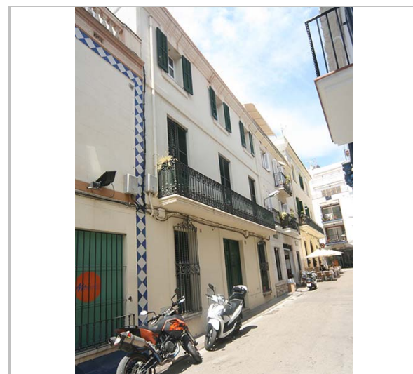
Façana. 3.6.2016. JM. Pujol
