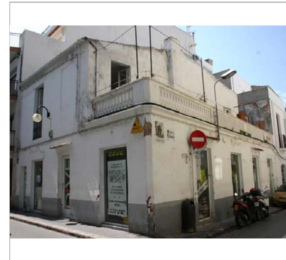
Vista de l'edifici. 2.5.2006. Diputació de Barcelona
