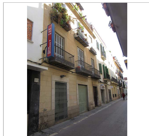
Façana del núm.18. 18.1.2016. JM. Pujol
