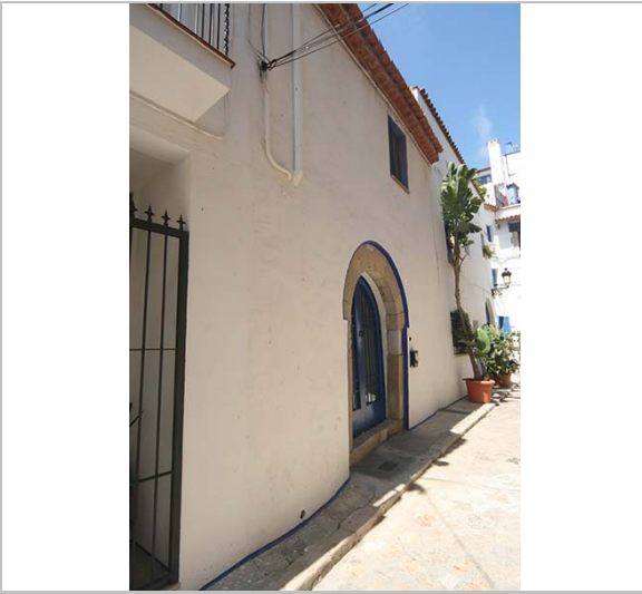
Façana. 3.6.2016. JM. Pujol
