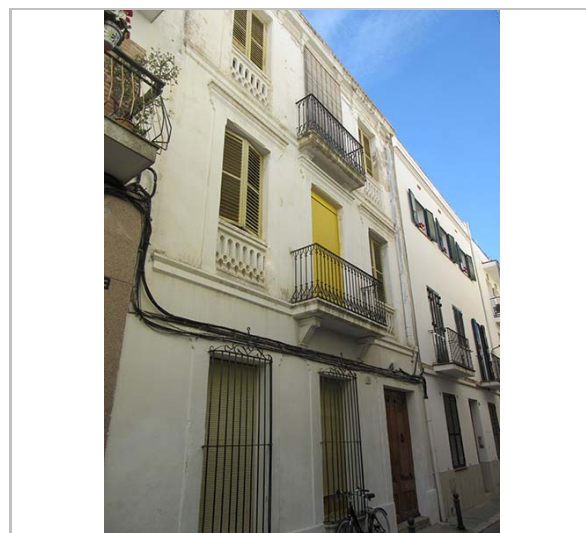
Façana. 18.1.2016. JM. Pujol
