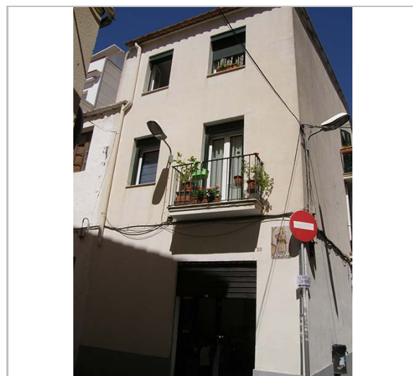
Vista de l'edifici. 22.6.2016. Foix Marsé
