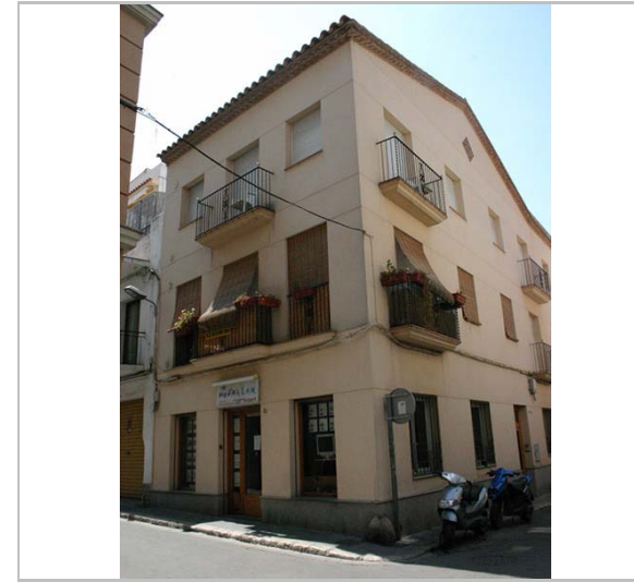
Vista de l'edifici. 2.5.2006. Diputació de Barcelona
