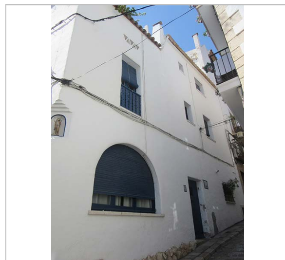
Façana del carrer de la Davallada 1.7.2016. Sixto Pujol
