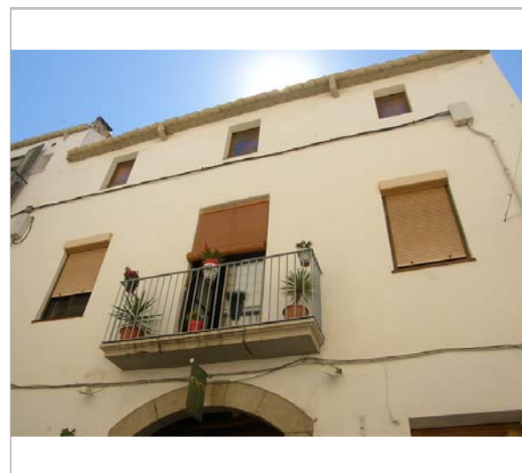
Part superior de l'edifici. 22.6.2016. Foix Marsé
