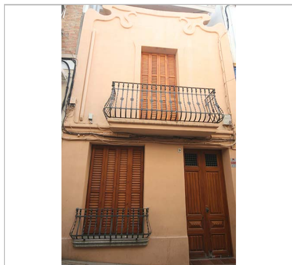
Façana. 16.6.2016. JM. Pujol
