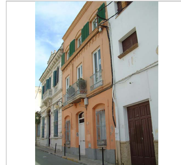
Vista de la façana. 24.4.2006. Diputació de Barcelona
