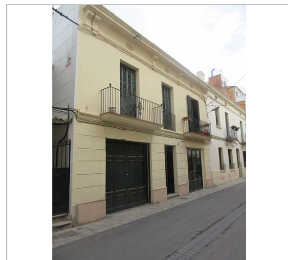
Vista de la casa. 29.2.2016. JM. Pujol
