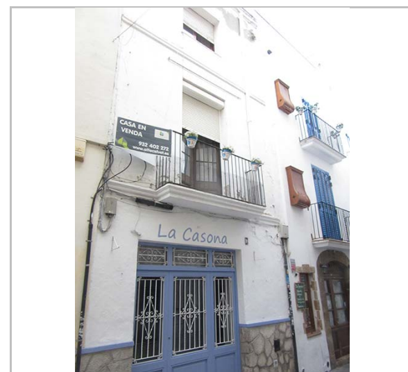
Façana. 28.10.2015 JM. Pujol
