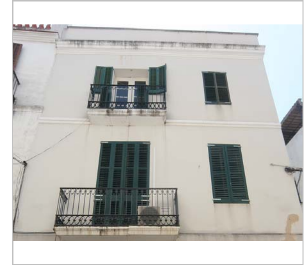
La part superior de l'edifici. 3.6.2016. JM. Pujol
