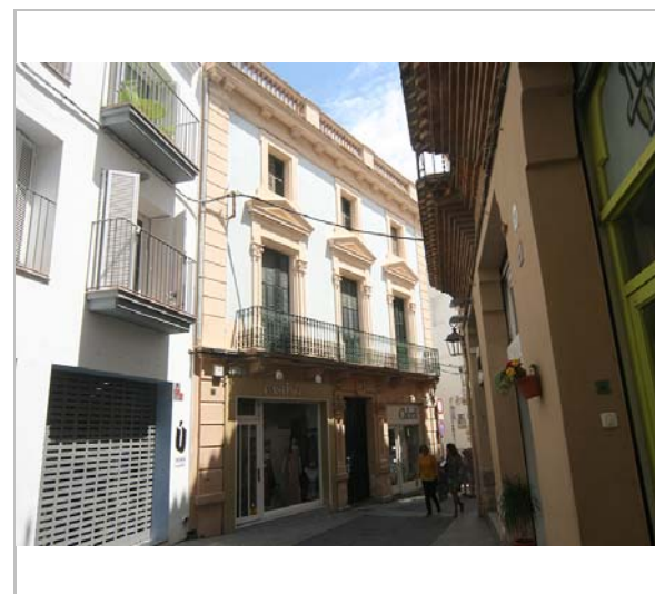
Façana. 3.6.2016. JM. Pujol
