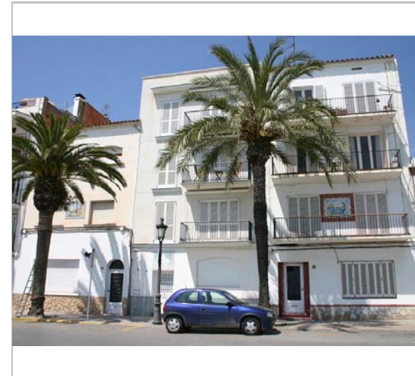
Vista dels tres edificis. 2006. Diputació de Barcelona
