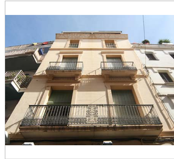
Part superior de la façana. 16.6.2016. JM. Pujol
