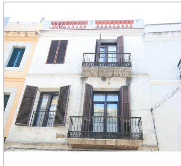
La part superior de l'edifici. 26.6.2016. Sixto Pujol
