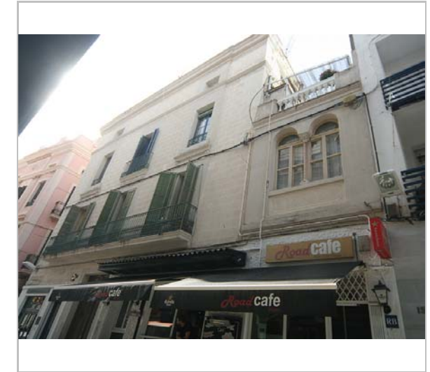
Part superior de l'edifici. 16.6.2016. JM. Pujol
