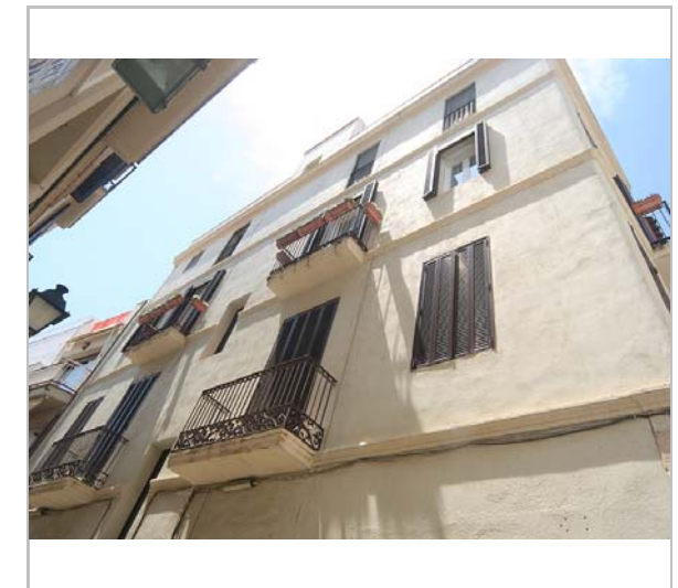
Part superior de la façana. 3.6.2016. JM. Pujol
