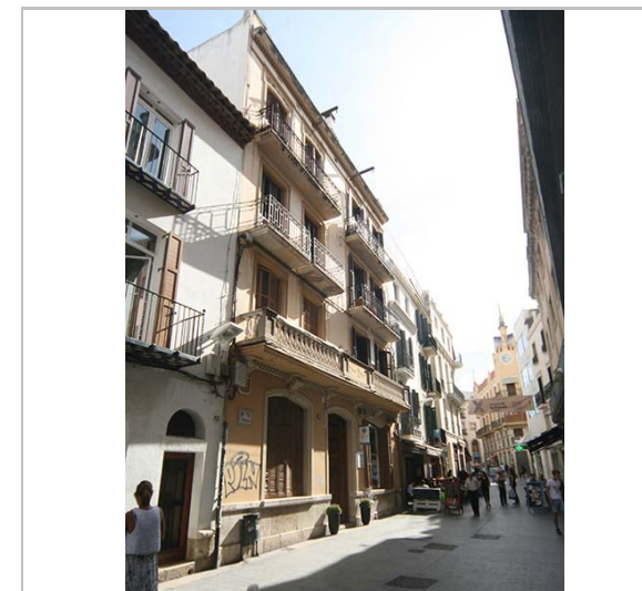
Façana. 16.6.2016. JM. Pujol
