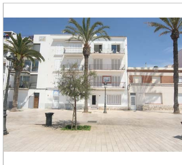
Façana. 3.3.2016. JM. Pujol
