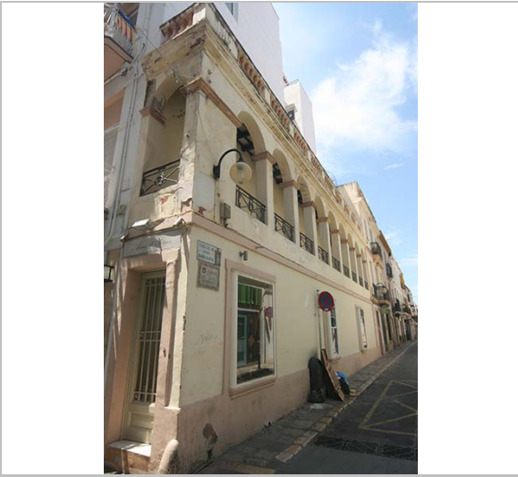
Façana del carrer de Sant Bartomeu. 3.6.2016. JM. Pujol
