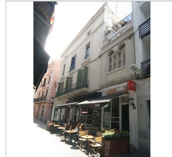
Façana. 16.6.2016. JM. Pujol
