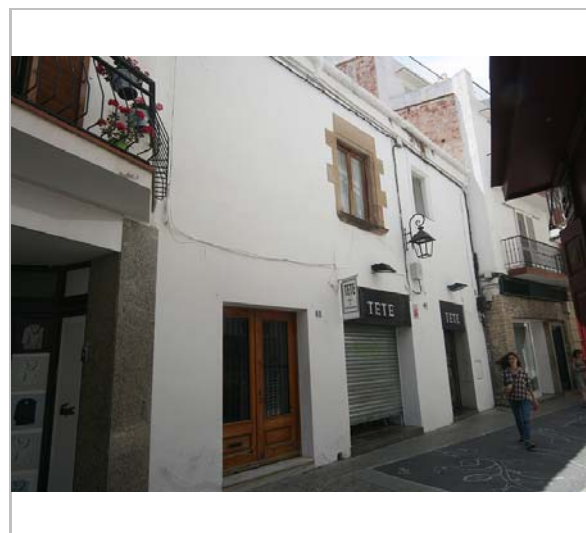
Façana. 3.6.2016. JM. Pujol
