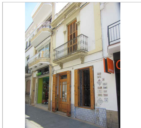
Façana. 29.7.2016. JM. Pujol
