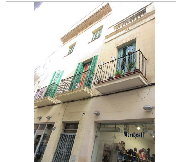
Façana. 29.2.2016. JM. Pujol
