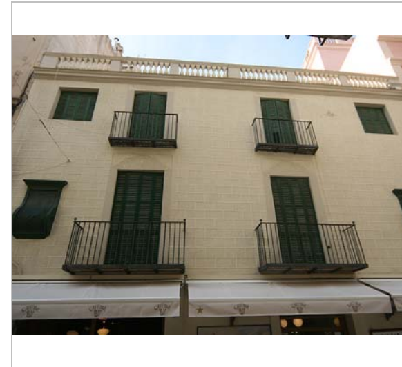
Part superior de la façana. 16.6.2016 JM. Pujol
