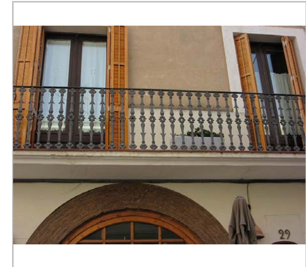
Detall de la façana. 29.2.2016. JM. Pujol
