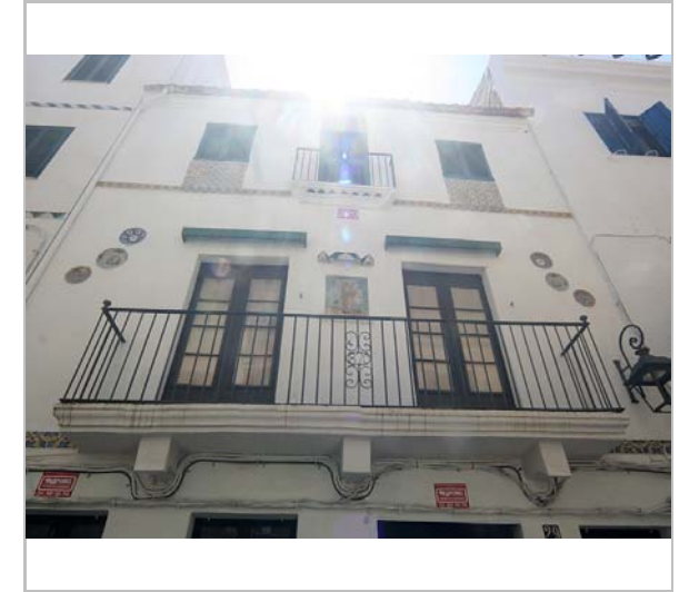
La part superior de l'edifici. 3.6.2016. JM. Pujol
