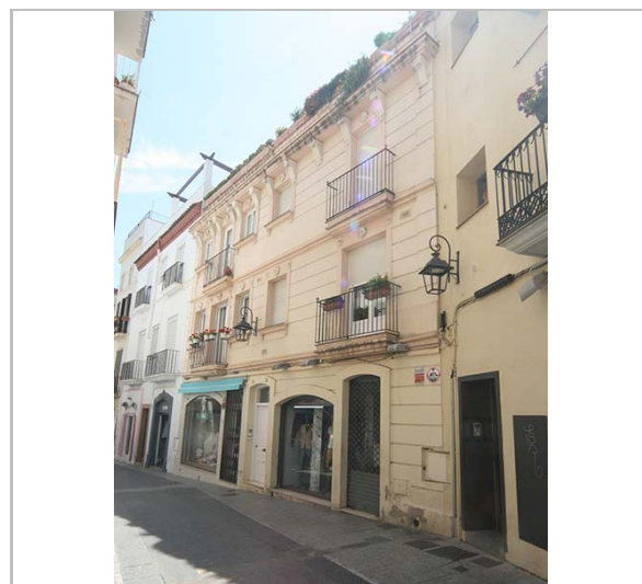
Façana. 3.6.2016. JM. Pujol
