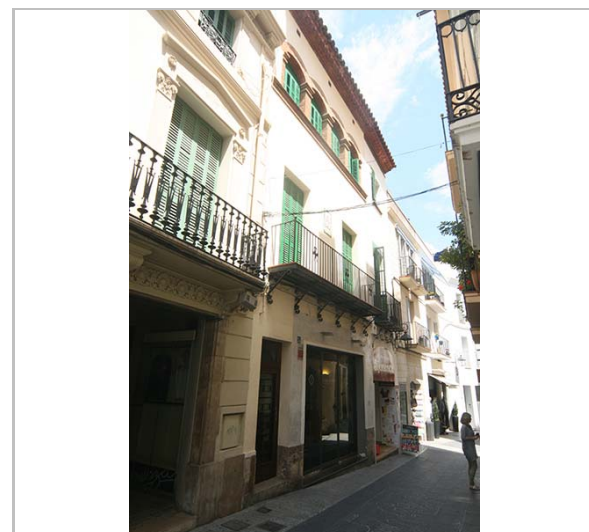
Façana. 3.6.2016 JM. Pujol
