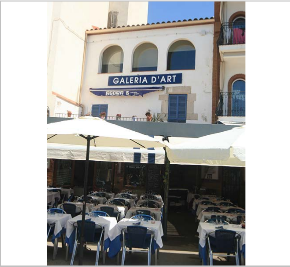
Vista de la façana. 27.6.2016. Sixto Pujol
