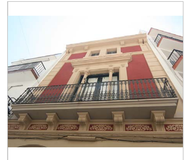
La part superior de l'edifici. 3.6.2016. JM. Pujol
