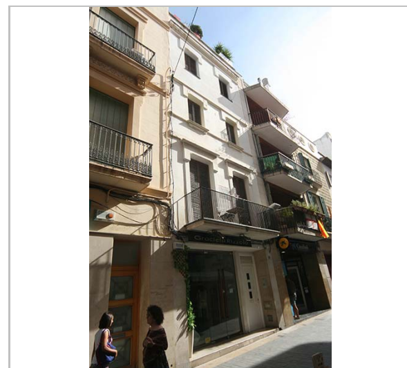
Façana. 16.6.2016. JM. Pujol
