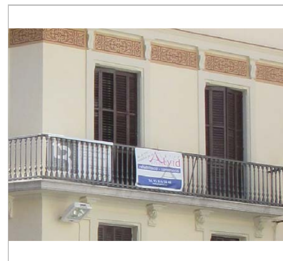
Detall de la façana. 26.3.2015. JM. Pujol
