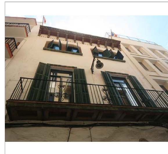
La part superior de l'edifici. 3.6.2016. JM. Pujol
