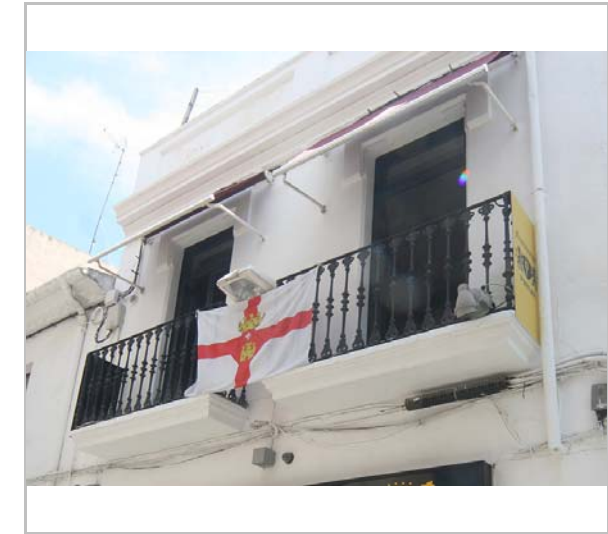
Detall dels balcons. 3.6.2016. JM. Pujol
