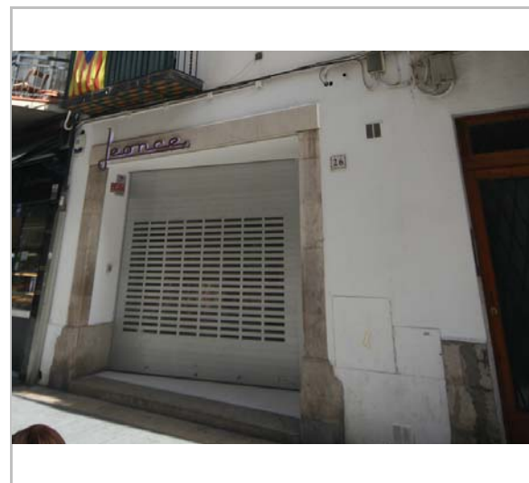
Detall de la façana. 16.6.2016. JM. Pujol
