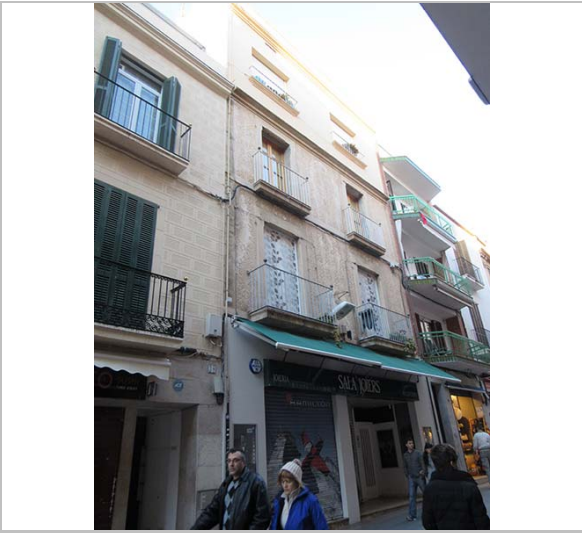
Façana. 22.2.2015. JM. Pujol
