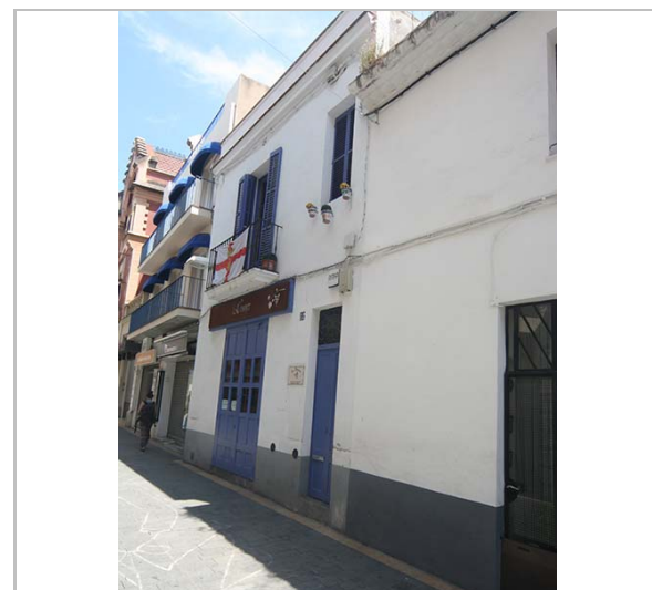
Façana. 3.6.2016. JM. Pujol
