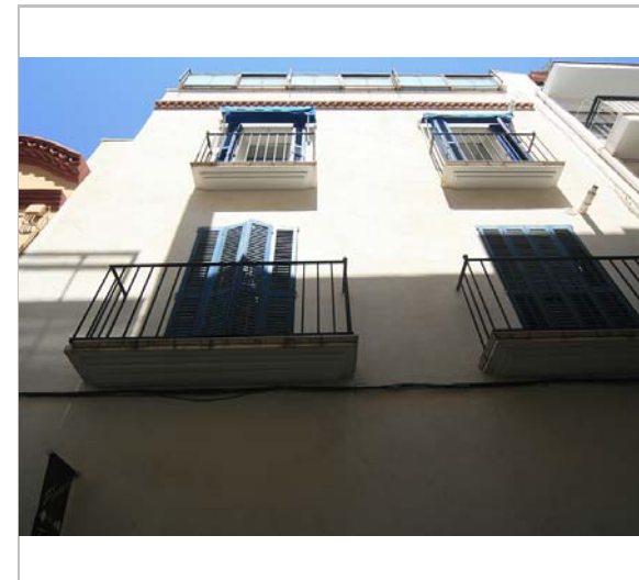
La part superior de l'edifici. 27.6.2016. Sixto Pujol
