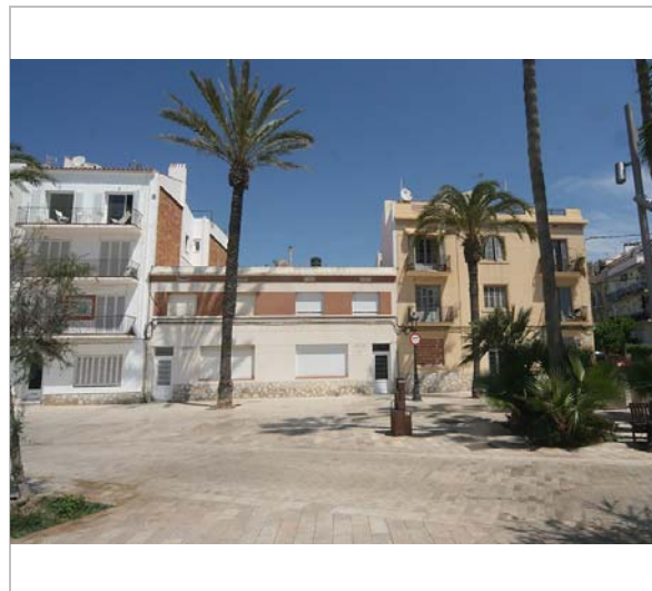
Façana. 3.6.2016. JM. Pujol
