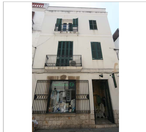
Façana del carrer Major. 3.6.2016. JM. Pujol
