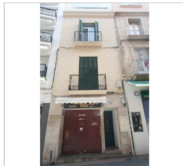
Façana. 16.6.2016. JM. Pujol
