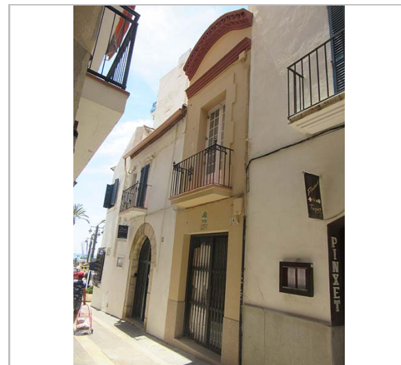
Façana. 9.6.2016. JM. Pujol
