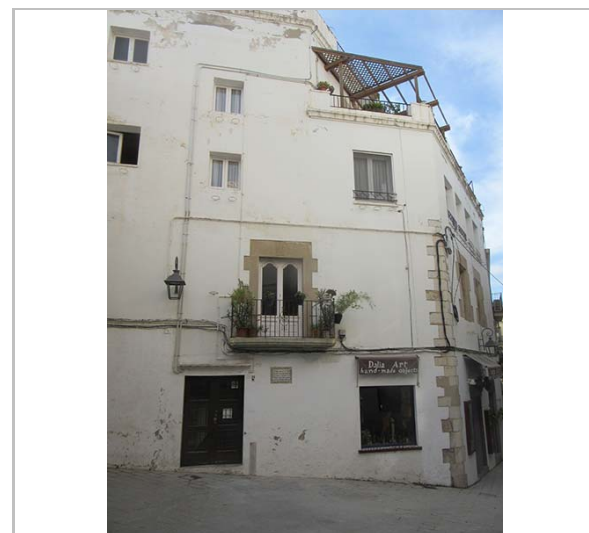
Façana. 2.12.2015. JM. Pujol
