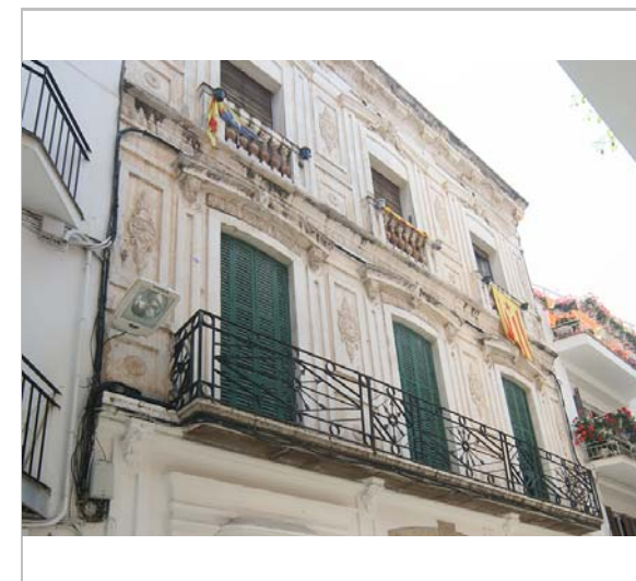
Detall de la façana. 3.6.2016. JM. Pujol
