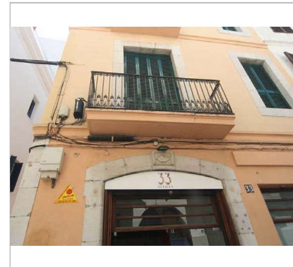
Detall de la façana. 3.6.2016. JM. Pujol
