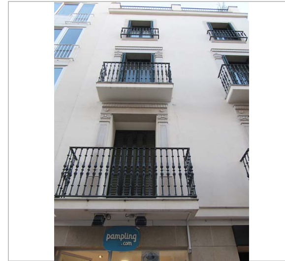
Part superior de la façana. 22.2.2015. JM. Pujol
