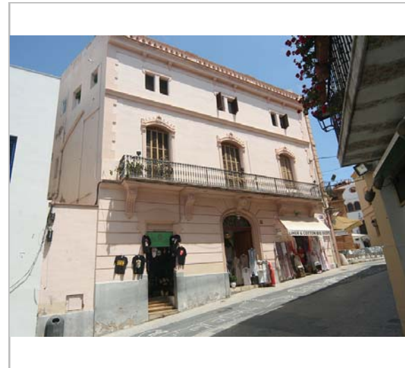
Vista de l'edifici. 3.6.2016. JM. Pujol
