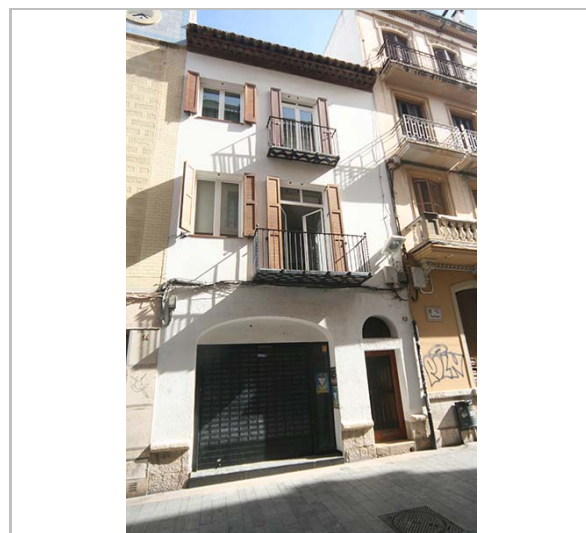
Façana. 16.6.2016. JM. Pujol
