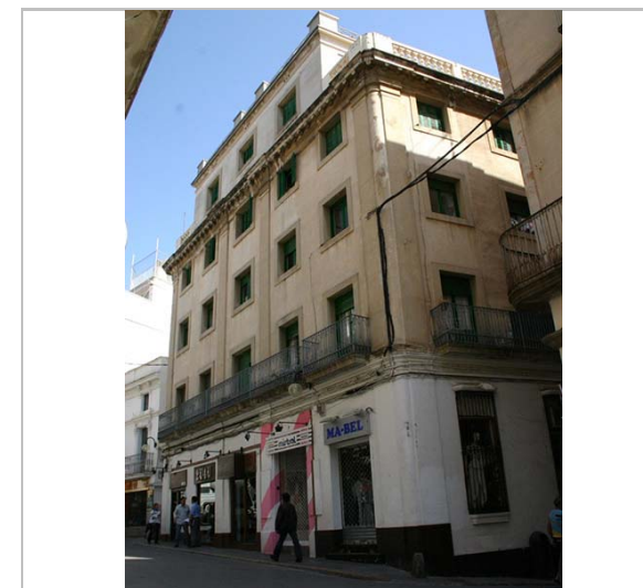
Vista de l'edifici. 25.4.2006. Diputació de Barcelona
