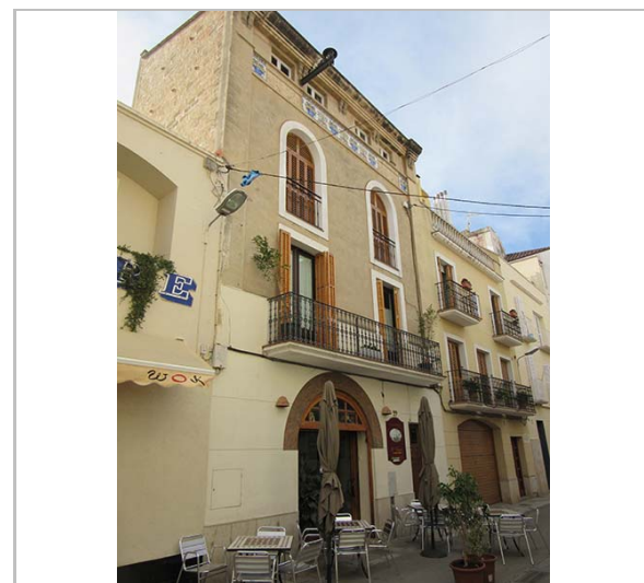
Façana. 2012. JM. Pujol
