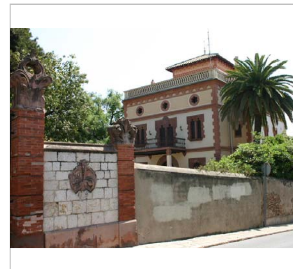
Vista de la casa. 2.5.2006. Diputació de Barcelona
