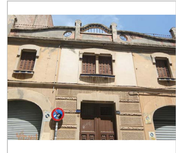
Façana. 3.6.2016. JM. Pujol
