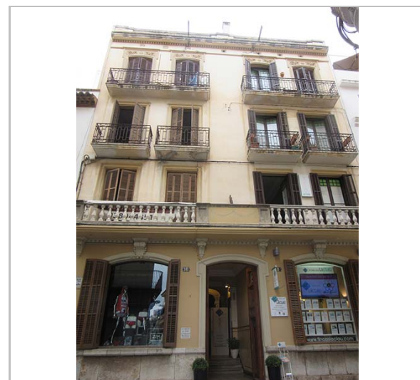
Façana. 27.7.2015 JM. Pujol
