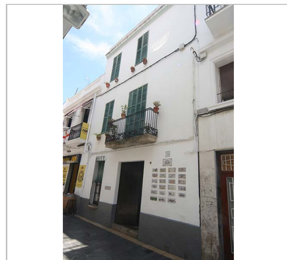
Façana. 3.6.2016. JM. Pujol
