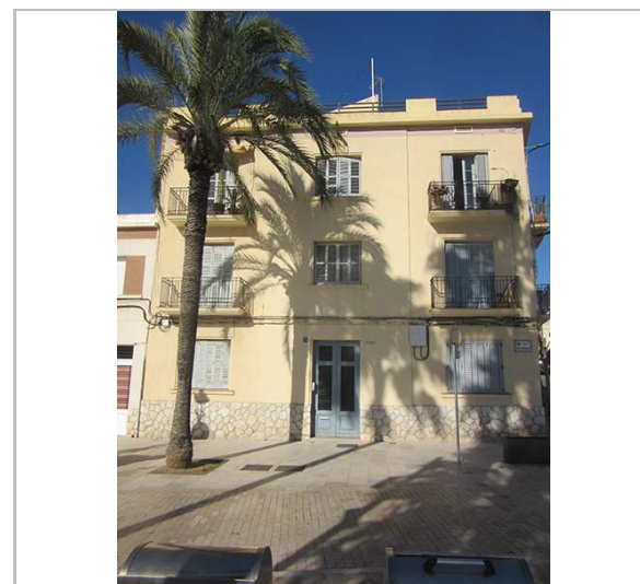
Façana. 17.11.2015. JM. Pujol
