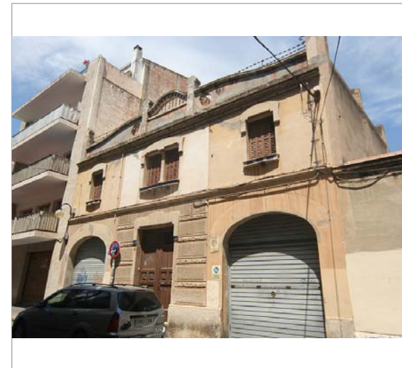
Façana. 3.6.2016. JM. Pujol
