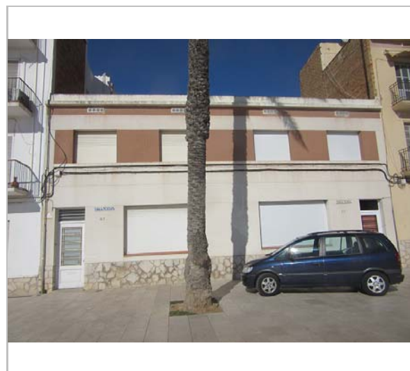
Façana. 17.11.2015 JM. Pujol
