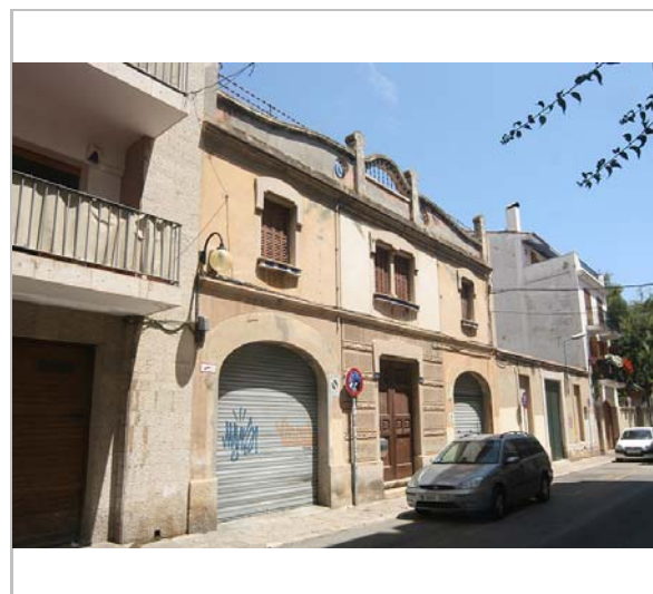
Façana. 3.6.2016. JM. Pujol
