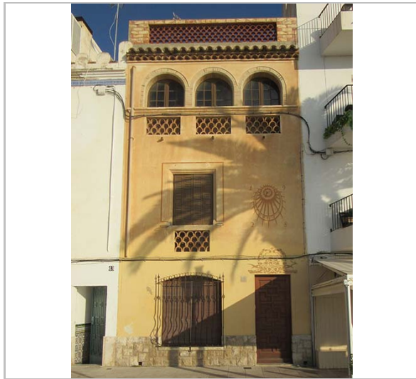
Façana. 21.10.2015 JM. Pujol
