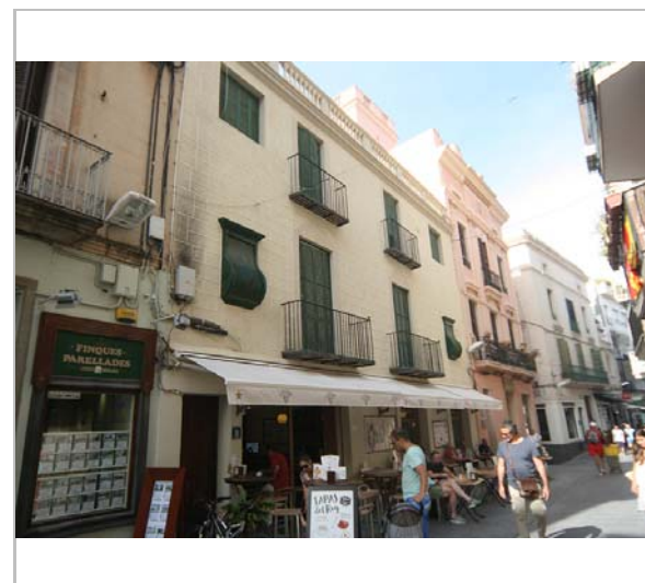
Façana. 16.6.2016 JM. Pujol
