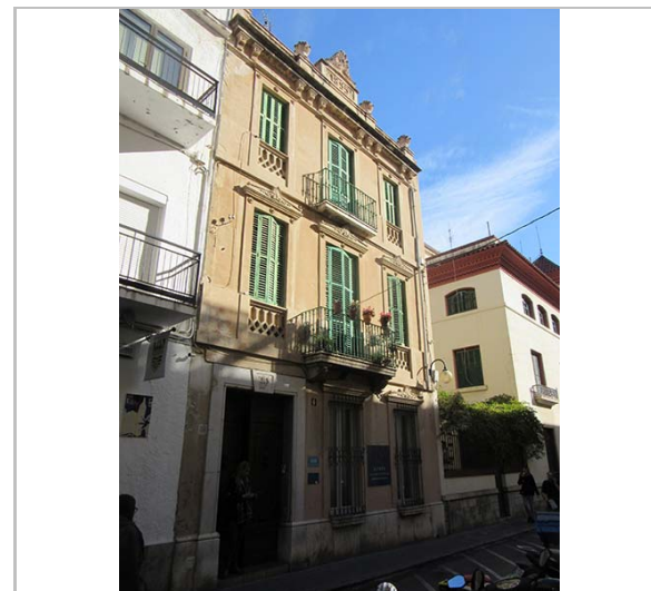
Façana. 18.1.2016. JM. Pujol
