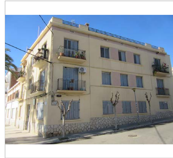
Façana lateral. 17.11.2015. JM. Pujol
