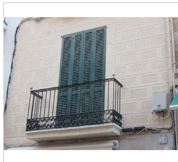
Detall de la façana. 22.2.2015. JM. Pujol
