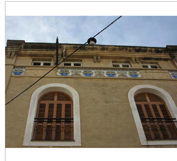
Part superior de la façana. 29.2.2016. JM. Pujol
