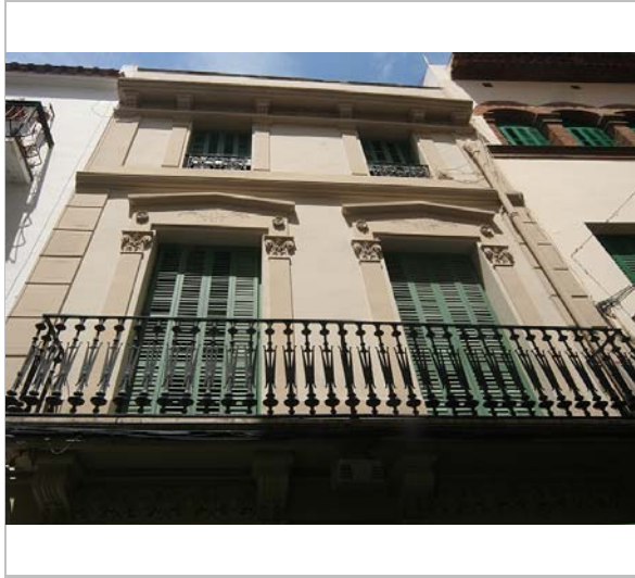
Part superior de la façana. 3.6.2016. JM. Pujol
