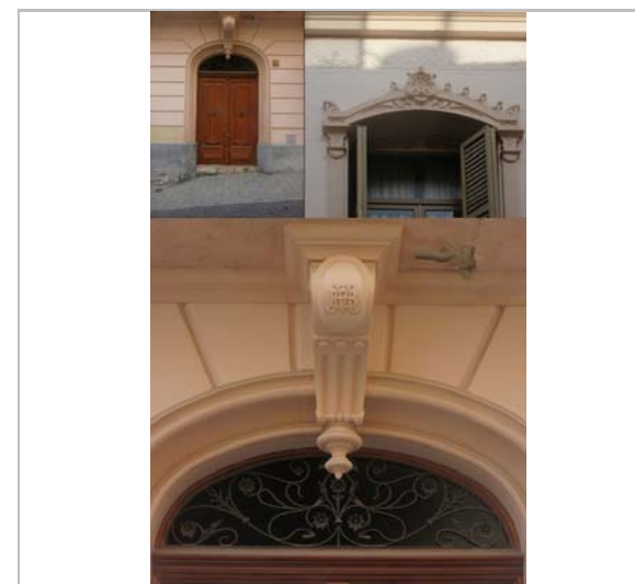
Detalls de la façana. 2015. JM. Pujol
