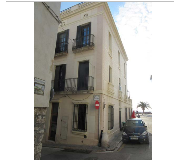
Façana lateral. 2015. JM. Pujol
