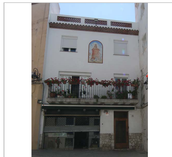
Vista de la casa. 3.6.2016 JM. Pujol
