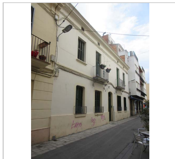
Façana. 29.2.2016. JM. Pujol
