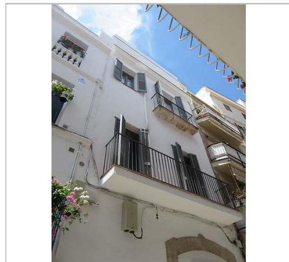
Part superior de l'edifici. 9.6.2016. JM. Pujol
