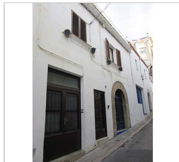
Façana. 29.2.2016 JM. Pujol
