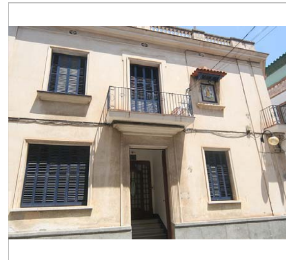
Façana. 3.6.2016. JM. Pujol
