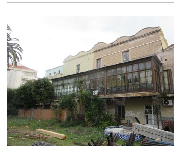
Vista de la façana del jardí. 2016. JM. Pujol
