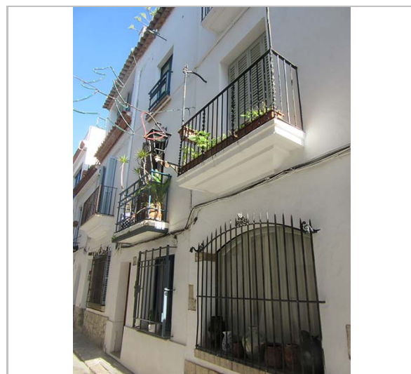
Façana. 17.11.2015. JM. Pujol
