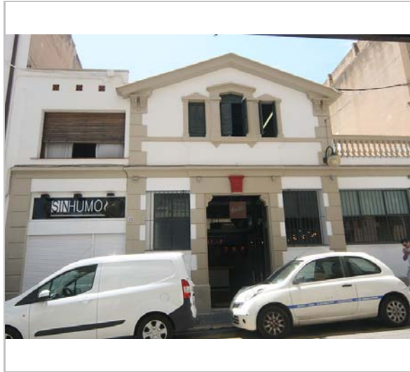
Façana. 3.6.2016. JM. Pujol
