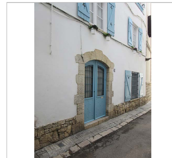
Façana. 29.2.2016. JM. Pujol
