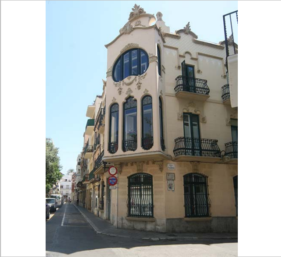
Façana. 3.6.2016. JM. Pujol
