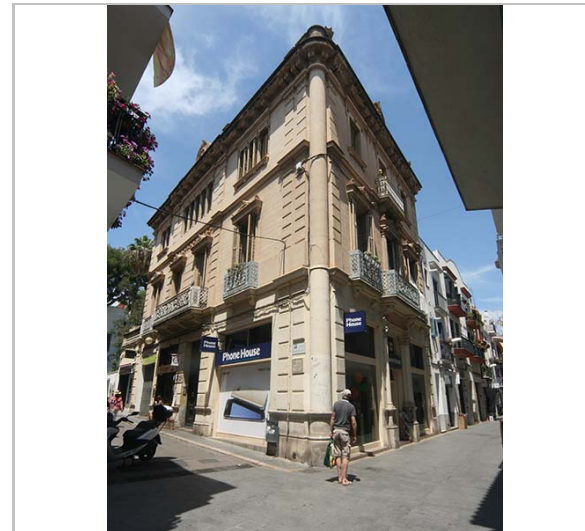
Vista de la casa. 3.6.2016. JM. Pujol
