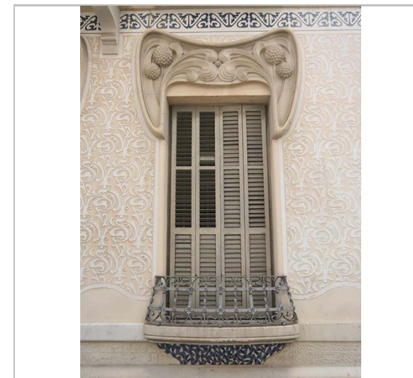
Detall de la façana. 3.6.2016 JM. Pujol
