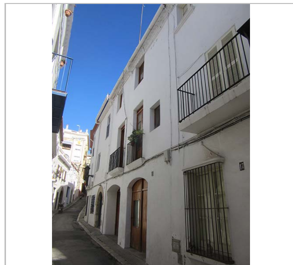
Façana. 17.11.2015. JM. Pujol
