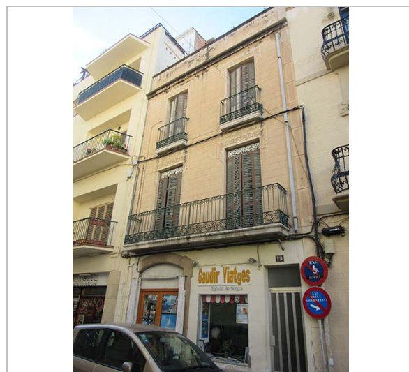
Façana. 18.1.2016. JM. Pujol
