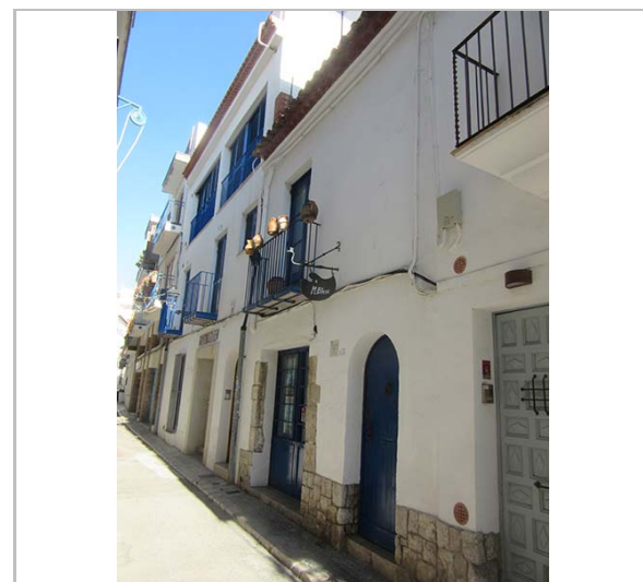
Façana. 17.11.2015. JM. Pujol
