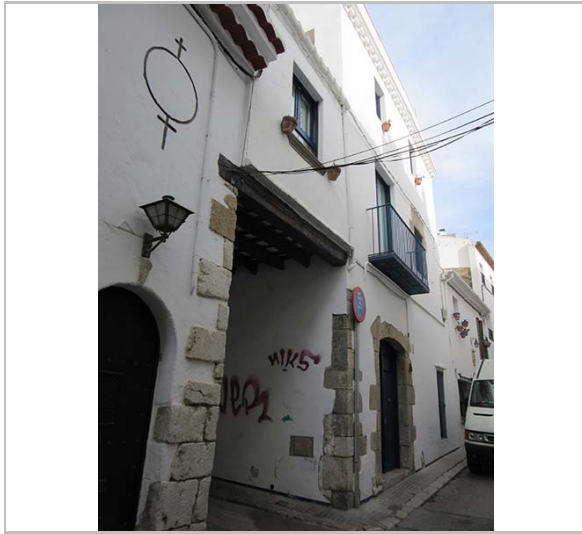
Pas que comunica amb el C. Pau Barrabeig, 2016. JM. Pujol
