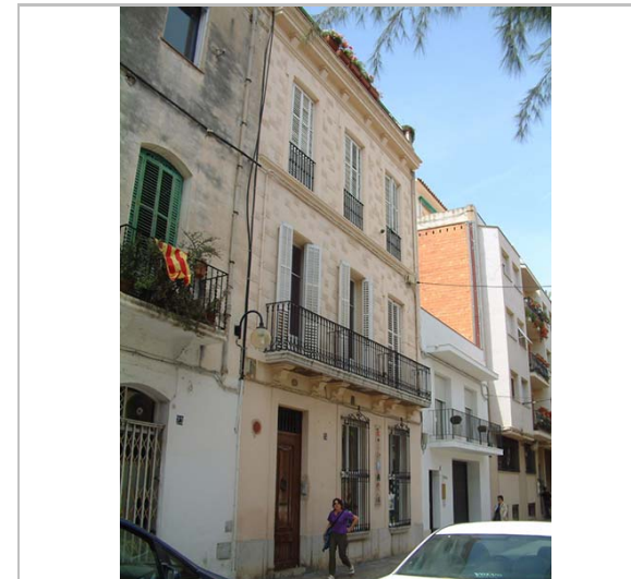
Detall de la façana. 2006. Diputació de Barcelona
