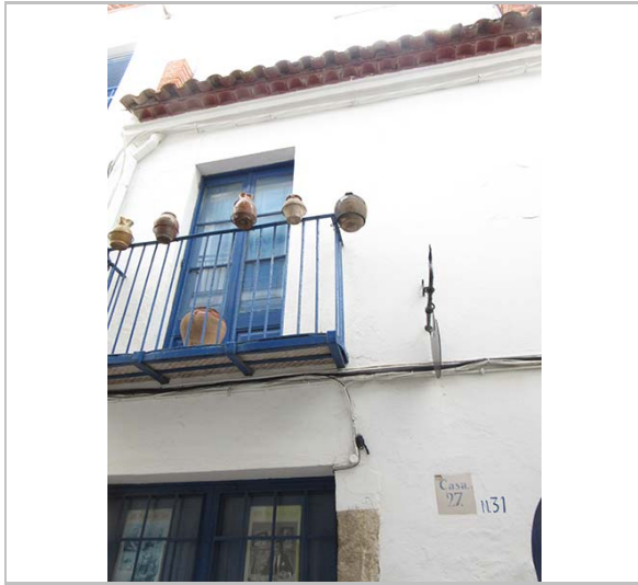
Detall de la façana. 29.2.2016 JM. Pujol
