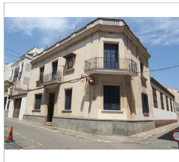
Vista de la casa. 3.6.2016. JM. Pujol
