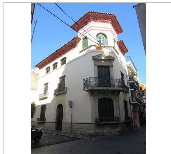
Façana. 18.1.2016. JM. Pujol
