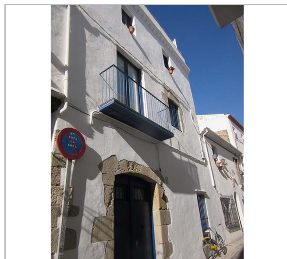
Façana. 17.11.2015 JM. Pujol
