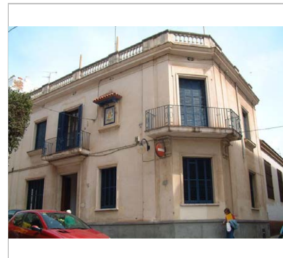
Vista de la casa. 2006. Diputació de Barcelona
