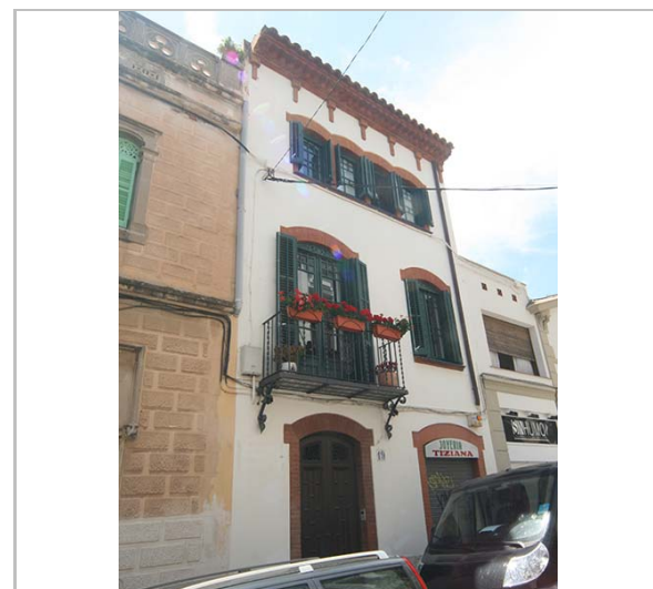
Façana. 3.6.2016. JM. Pujol
