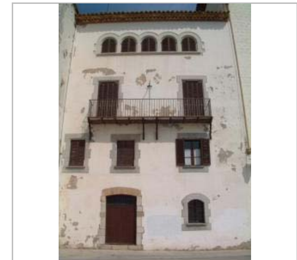
Façana que dona al Baluard de Miquel Utrillo. 2006. Diputació de Barcelona
