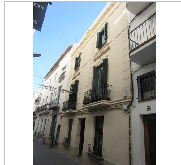
Façana. 17.11.2015. JM. Pujol
