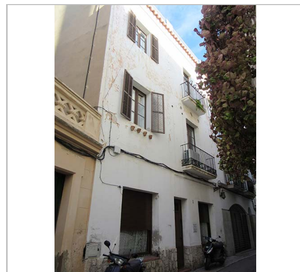
Façana. 2.1.2016. JM. Pujol
