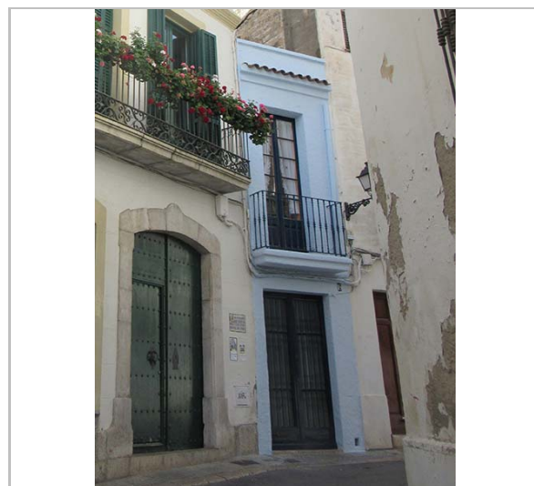
Façana. 16.6.2016. JM. Pujol
