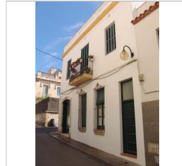
Façana del carrer de Sant Isidre. 2012. Ajuntament de Sitges
