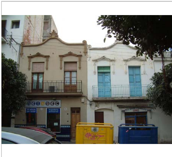
Façanes. 2006. Diputació de Barcelona
