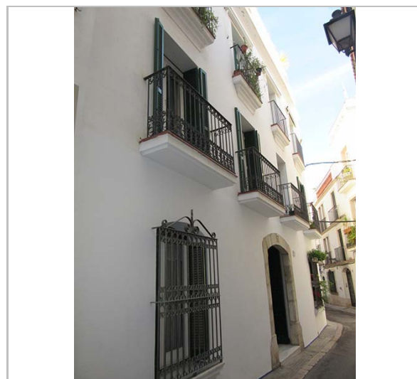
Façana. 2.1.2016 JM. Pujol
