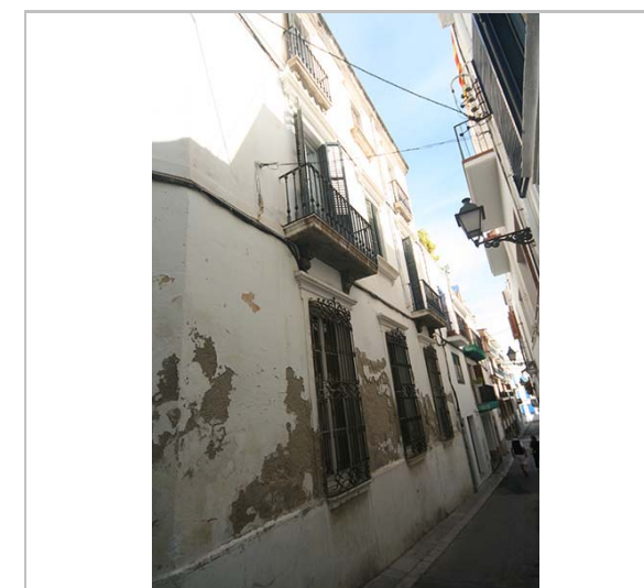
Façana lateral. 16.6.2016. JM. Pujol
