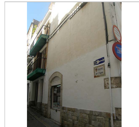
Imatge de l'edifici. 27.6.2016. Foix Marsé
