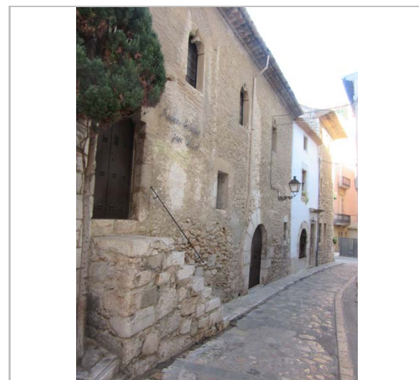
Façana. 17.11.2015. JM. Pujol
