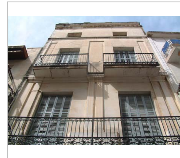
Balcons. 24.4.2006. Diputació de Barcelona
