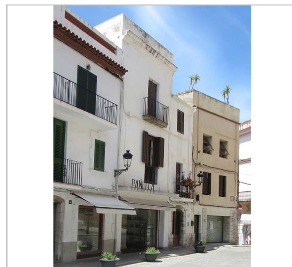
Les façanes. 9.6.2016. JM. Pujol
