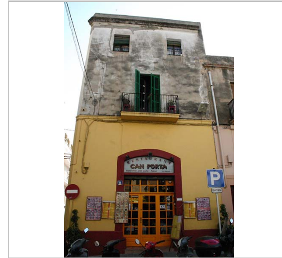
Façana principal. 2006. Diputació de Barcelona
