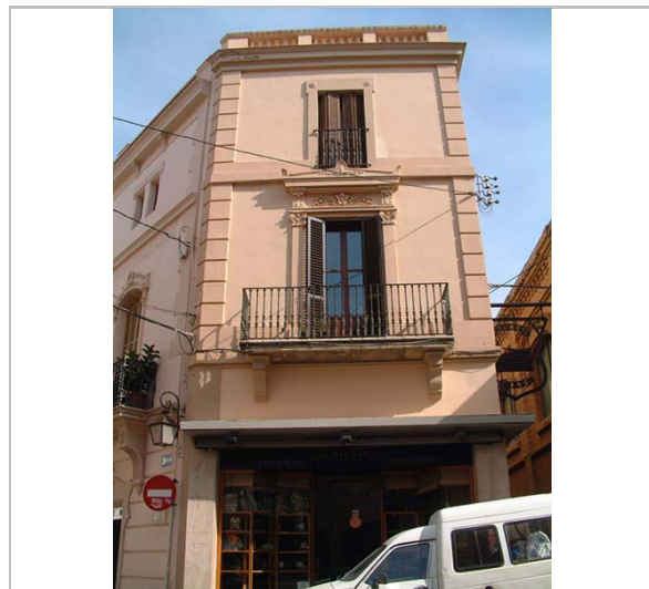
Façana principal. 2006. Diputació de Barcelona
