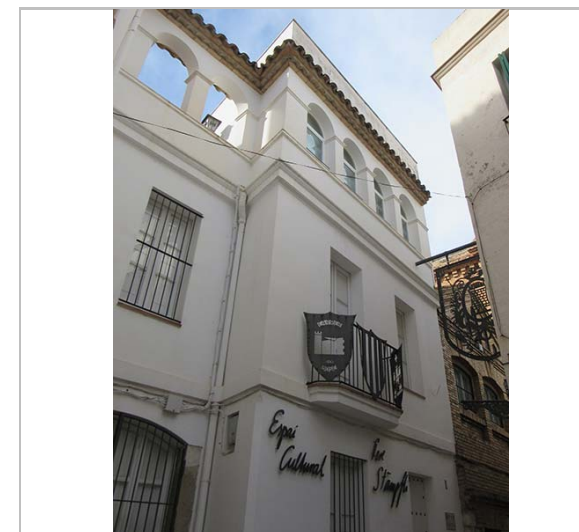
Detall de la façana. 29.2.2016. JM. Pujol
