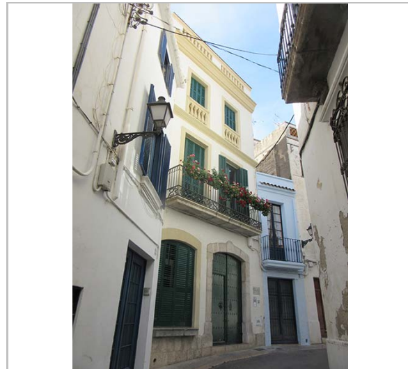
Façana. 16.6.2016. JM. Pujol
