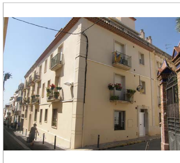
Imatge de l'edifici. 27.6.2016. Foix Marsé
