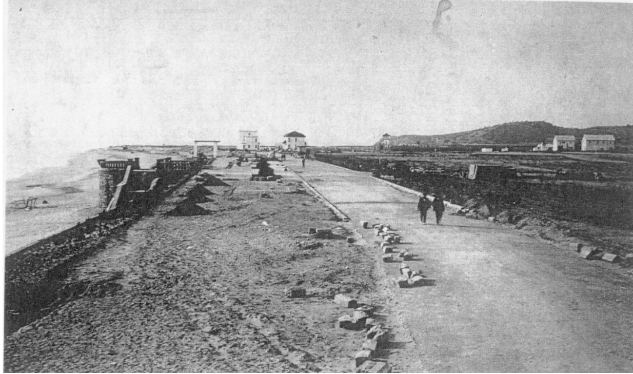
Construcció del Passeig Marítim (1922)
