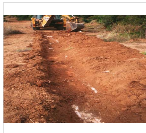
Excavació amb seguiment arqueològic. A. Vidal.
