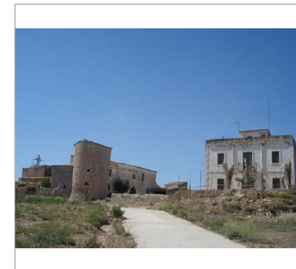
Vista de l'emplaçament. 23.5.2006. Diputació de Barcelona
