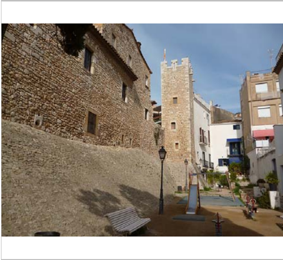
Muralla i escarpa del vall de la muralla.
