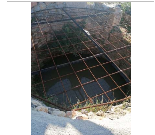
Vista del pou. 2020. Esteve Mestres Roca
