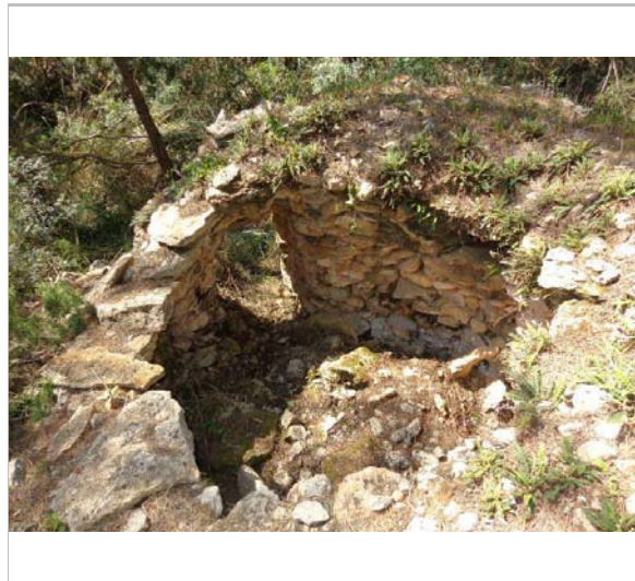
Vista de la barraca. 14.4.2014 Pau Tena
