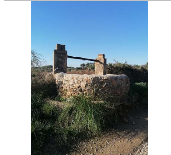
Vista del pou. 2020. Esteve Mestres Roca
