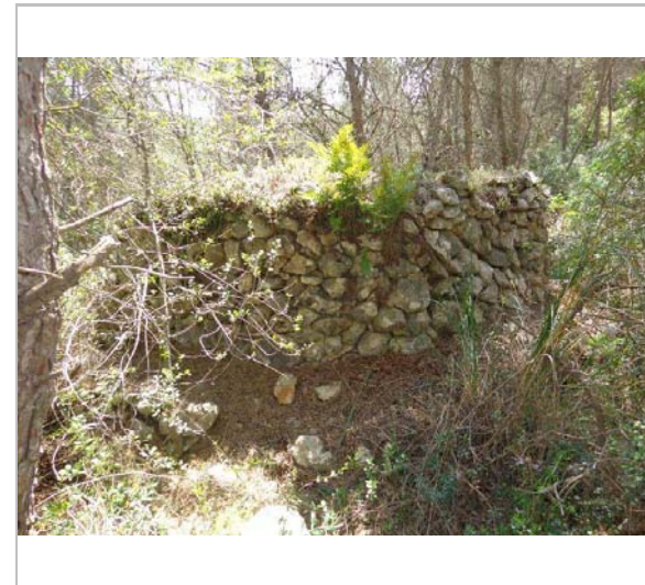
Vista de la barraca. 14.4.2014 Pau Tena
