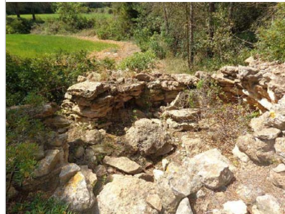
Vista de la barraca. 14.4.2014 Pau Tena
