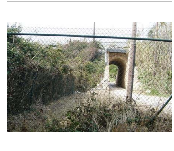
Tancament a l'altura del pas inferior de la via. Xavier Campillo
