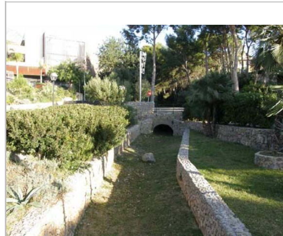
Canalització de la part final. 6.1.2015 Jaume Marsé
