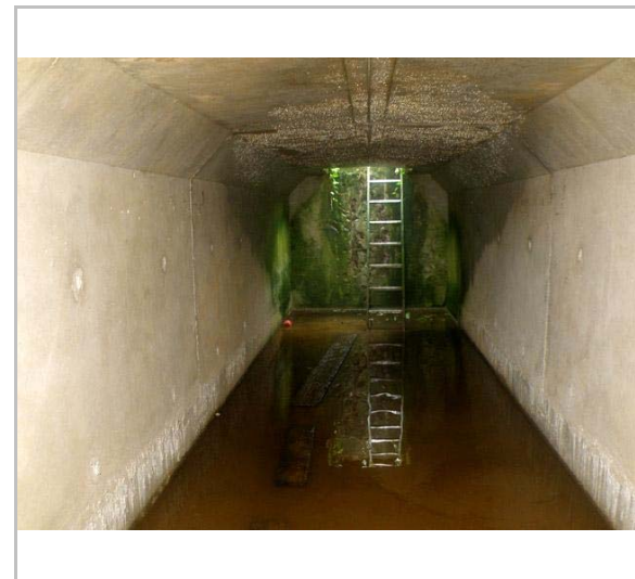
El túnel per sota l'autopista. 2013. espeleoindex
