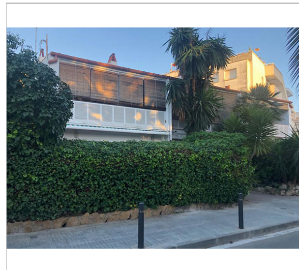
Apartaments Baracoa, de arq. Valls-Coderch (1953) Desconegut
