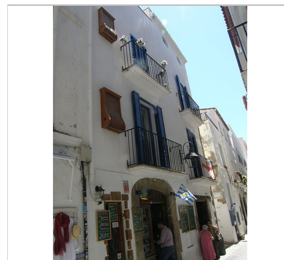
Vista al carrer Major. 22.6.2016. JM. Pujol
