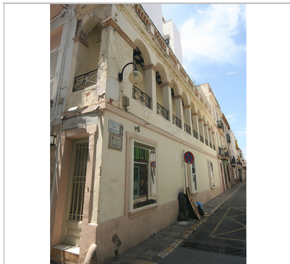
Vista del carrer de Sant Bartomeu. 18.1.2016. JM. Pujol
