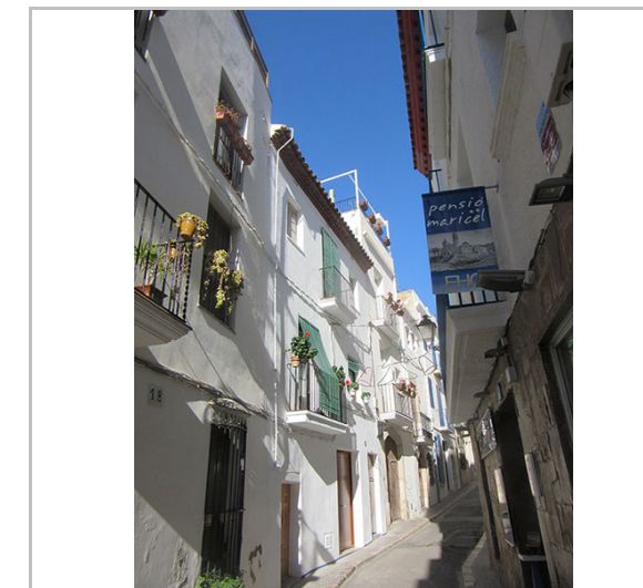
Vista del carrer d'en Tacó. 17.11.2015. JM. Pujol
