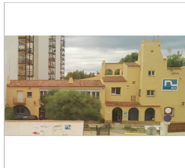
Façana Nord. 29.9.2016. JM. Pujol
