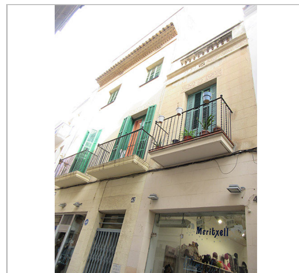
Vista de la façana. 29.2.2016 JM. Pujol
