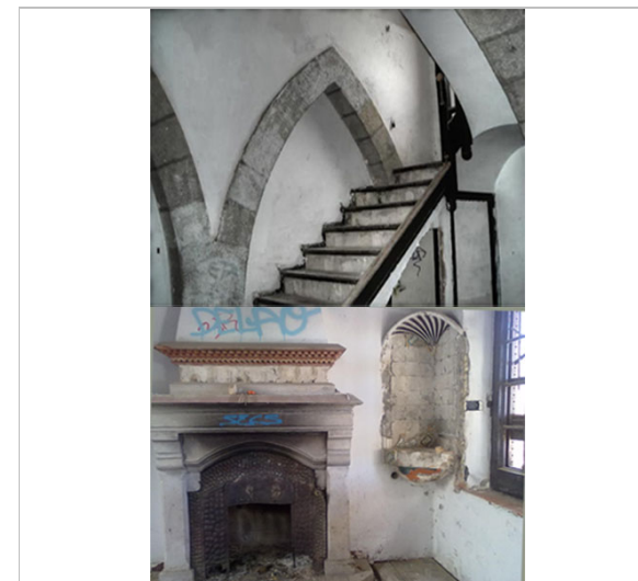
Vista interior, llar de foc i escala. 2015 R-400
