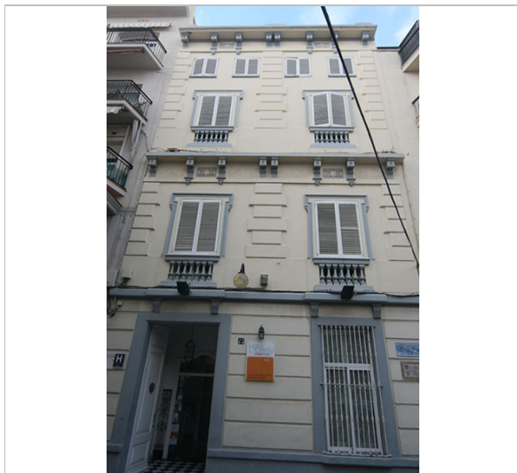
Vista de la façana. 9.12.2015 JM. Pujol
