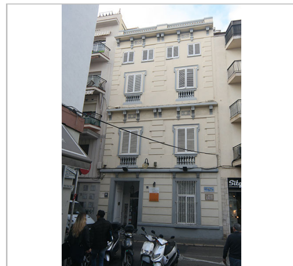
Vista de la façana. 9.12.2015 JM. Pujol
