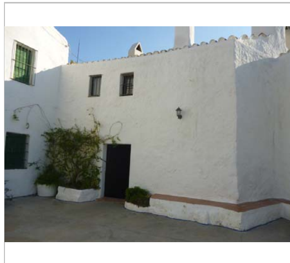
Vista de l'entrada. 26.11.2013 Sixto Pujol
