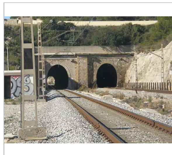
Boques dels túnels de Cala Forn. 1.2.2015. Jaume Marsé
