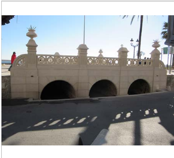
Vista del pont. 4.1.2015 JM. Pujol
