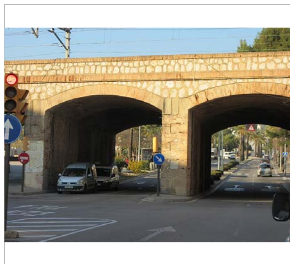
Vista el pont, banda sud. 14.1.2015 JM. Pujol
