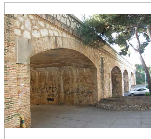
Vista el pont, banda nord. 13.1.2015
